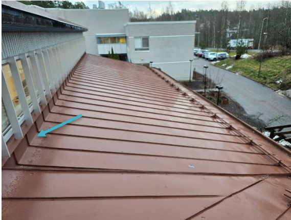
Kuva 68 Alkuperäisosan kattoa käytävän ZSK11 kohdalla. Ylempi räystäs suojasi ikkunallista ulkoseinää kastumiselta.
