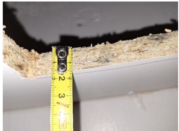
Kuva 22 Kotelointi on tehty 16 mm vahvasta vanerista.
