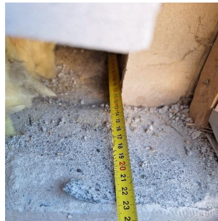
Kuva 40 Puujulkisivun ja tiiliseinän liittymäkohta.
