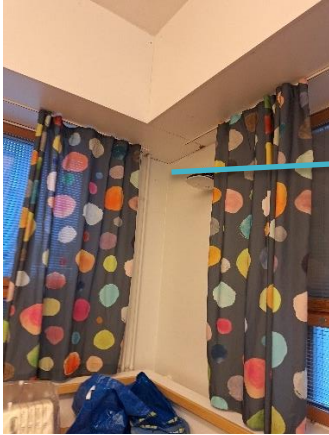
Kuva 15 Tilan SK0007 ulkokulmassa on kotelointi.
