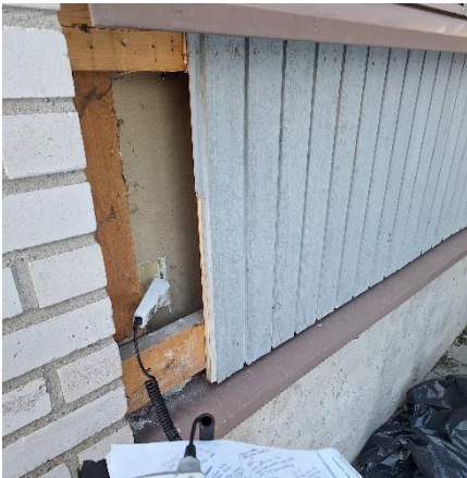
Kuva 33 Eristevillan rakennekosteus avauksessa RA4 oli normaali: 39,9 RH% lämpötilassa +8,2 °C.
