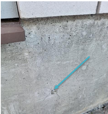
Kuva 57 Rakenneavaus RA11 tehtiin laajennososan sokkeliin noin 345 mm maanpinnasta.
