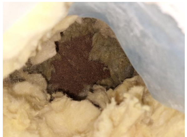
Kuva 28 Lasivillan takana oli mineraalivilla sekä ruskea tuulensuojalevy.
