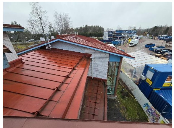
Kuva 61 Laajennososan ja yhdyskäytävän vesikattoa.
