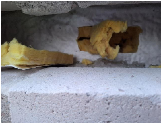
Kuva 37 Rakennearvauksesta otettiin villanäyte noin 1030 mm maanpinnan yläpuolelta, kolmannesta tiilirivistä.
