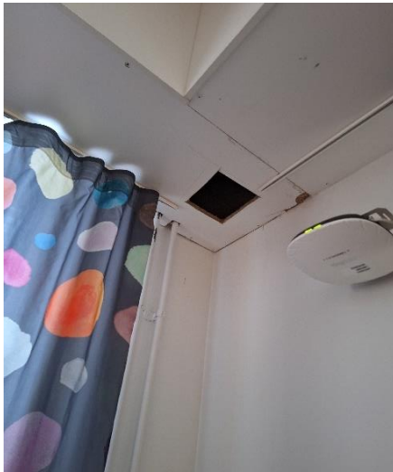
Kuva 19 Tilan SK0007 kotelointiin tehtiin pieni avaus.
