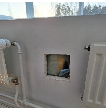
Kuva 23 Rakennearaus RA2 sisäkautta ulkoseinään käytävällä ZSK11 (alkuperäisosa).
