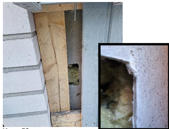
Kuva 52 Tuulensuojalevynä oli 2 mm paksu kovalevy. Lämmöneristeinä oli mineraalivillaa.
