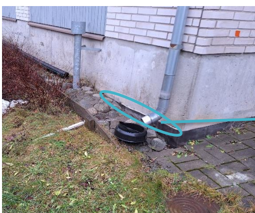
Kuva 47 Sokkelin maanvastaisella osalla oli bitumikermi. Kermi oli irronnut siniseltä alueelta.
