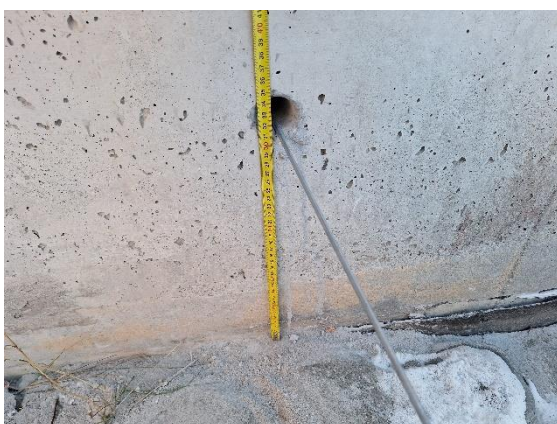
Kuva 45 Rakenneavaus RA8 tehtiin alkuperäisosan sokkelirakenteeseen noin 340 mm maanpinnasta.
