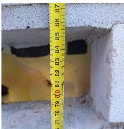
Kuva 53 Rakenneavaus RA10 tehtiin noin 755...855 mm maanpinnasta.
