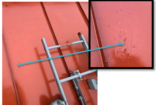
Kuva 67 Lapetikkaiden kiinnitys oli asianmukainen. Tik- kaan vieressä oli korjausjälki.
