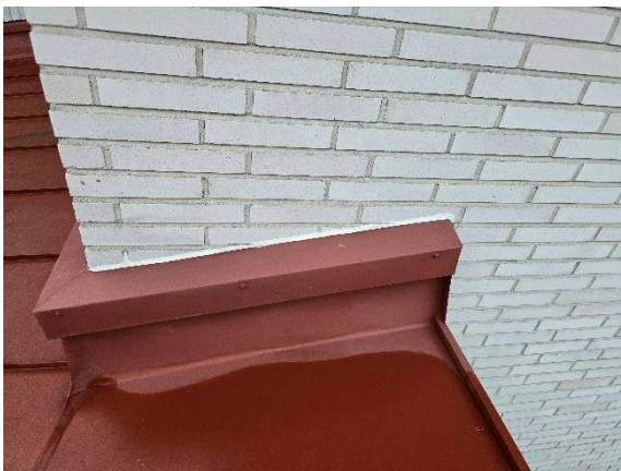
Kuva 70 Pellityksen ja julkisivumuurauksen liittymä oli tiivistetty liimatiivistemassalla. Liittymä vaikutti tiiviiltä.
