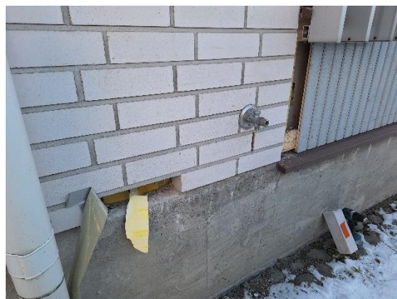
Kuva 50 Rakenneavaus RA9 puujulkisivuun ja RA10 tii- len kohdalle.
