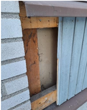
Kuva 31 Rakenneavaus RA4 julkisivulaudoituksen kohdalle. Takana on ristiinkoolaukset ja kipsilevy.
