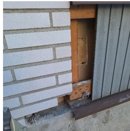
Kuva 38 Rakennearvaukset RA6 (puu) ja RA7 (tiili) tilan SK0007 pitkälle sivulle. Julkisivulaudoituksen kohdalla on pellitys.
