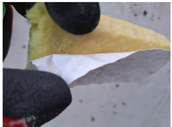
Kuva 36 Tuulensuojana on muovikalvo, joka on kiinni uloimmassa villassa.
