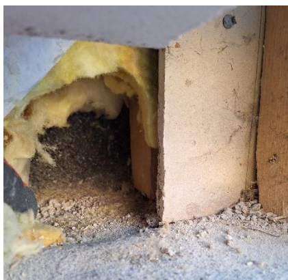
Kuva 43 Bitumi nousee reilusti betoniselle ulkoseinälle.
