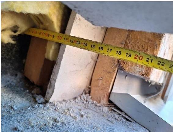
Kuva 39 Puujulkisivun ja tiiliseinän liittymäkohta.
