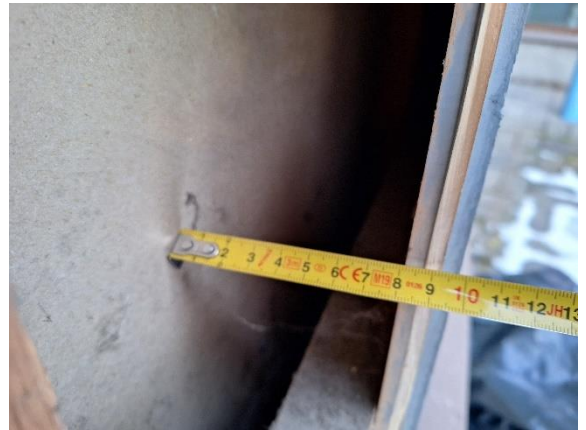
Kuva 32 Julkisivulauta oli 20 mm paksu ja takana on hyvä 80 mm syvä tuuletusrako.
