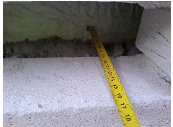
Kuva 34 Rakenneavaus RA5 julkisivutiilen kohdalle. Julkisivutiili on 85 mm paksu kahi-tiili. Sen takana on 85 mm syvä tuuletusväli.
