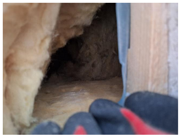
Kuva 24 Rakenne oli: kipsilevyt, höyrynsulkumuovi, lasivilla, mineraalivilla, tuulensuojalevy.
