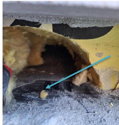
Kuva 56 Sokkelin päällä oli bitumikaistale sekä ulkopinnassa liukkaampaa muovipinnoitetta.
