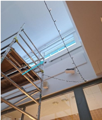
Kuva 25 Rakenneavaus RA3 käytävän ZSK11 ulkoseinälle.
