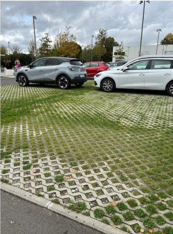
Kuva 3.2. Esimerkki pysäköintialueen läpäisevästä pinnasta.
