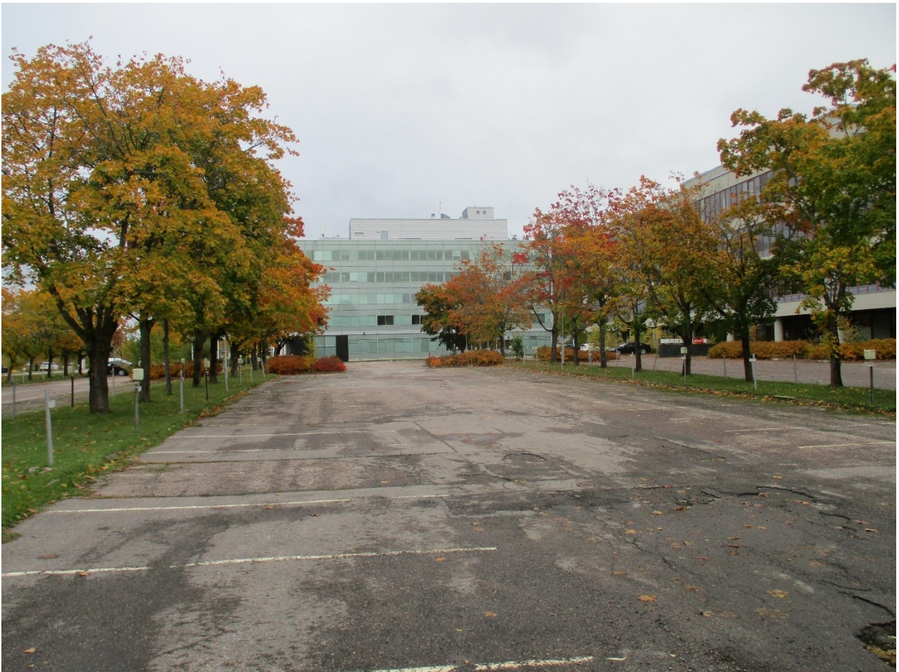
Kuva 2. Selvitysalueen pohjoisosaa, johon suunnitellaan uutta rakennusta. Purettavaksi suunniteltu rakennus kuvassa oikealla.
