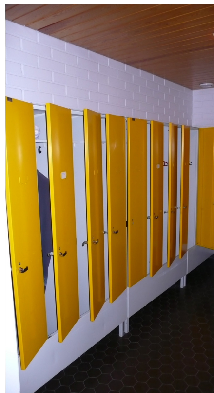
Kuva 54. Liikenne- ja aputilatornissa sijaitsevien saniteettitilojen alkuperäiset pukukaappien ovet. JRT Oy, 2008.
