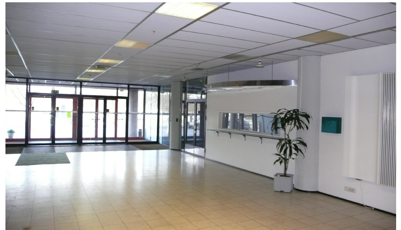
Kuva 49. Sisääntuloaula ennen vuoden 2009 remonttia. Vahtimestarin erillinen palvelutiski on poistettu ja sen tilalla on seinään avattu luukku tiskeineen. Lattian mosaiikkibetonilaatat ovat alkuperäisiä. Tuulikaapissa on alun perin ollut rautalankalasiseinät, kuten myös aulan ja näyttelytilojen välisissä seinissä. JRT Oy, 2008.
