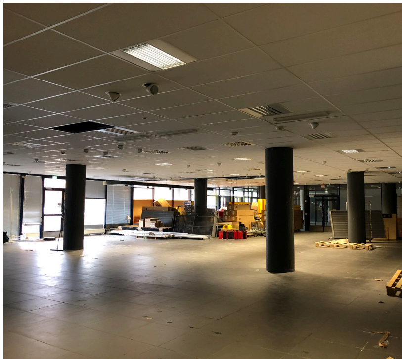
Kuva 69. Ensimmäisen kerroksen näyttelytilaa. Kaikki pintamateriaalit on uusittu. Pilareissa on ollut paljas betonipinta. Synopsis Arkkitehdit Oy, 2024.
