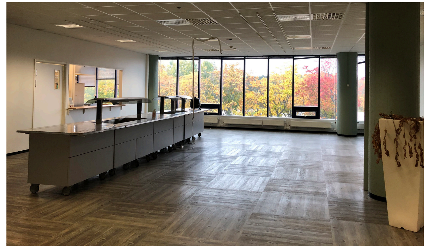
Kuva 78. Ruokasalista on avoin näköala ulos. Luukku keittiöön vasemmalla. Kaikki pintamateriaalit ovat uusia. Tilassa on alun perin ollut kotelattiamatto ja alakatossa ”Karhu” akustolevyt. Synopsis Arkktiehdit Oy, 2024.
