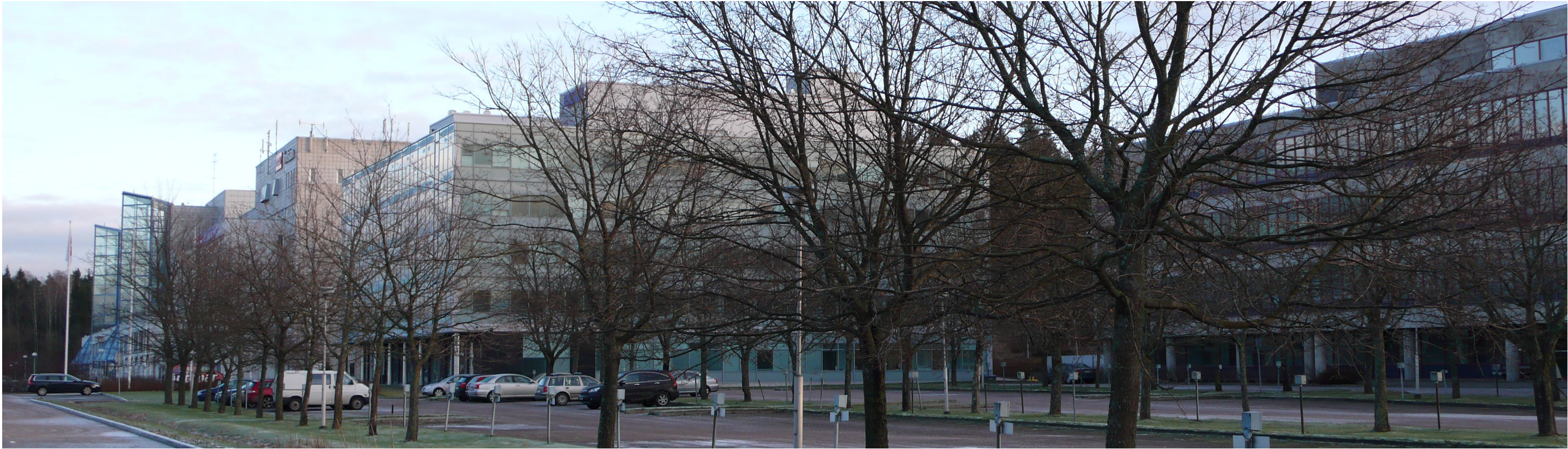
Kuva 1. Parkkipaikan pihanäkymää ja Rank Xeroxin viereiset rakennukset. JTR Oy, 2008.
