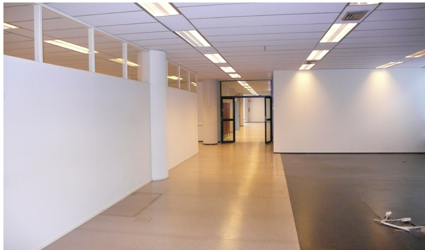
Kuva 53. Näkymä hissiaulasta uudisosaa kohti. Kuvan yläikkunallista väliseinää ei ole vuoden 1980 suunnitelmassa. Alkuperäiset alakatot integroituine valaisinjonoineen näkyvät hienosti lasiseinien läpi. 2. kerros. JRT Oy, 2008.
