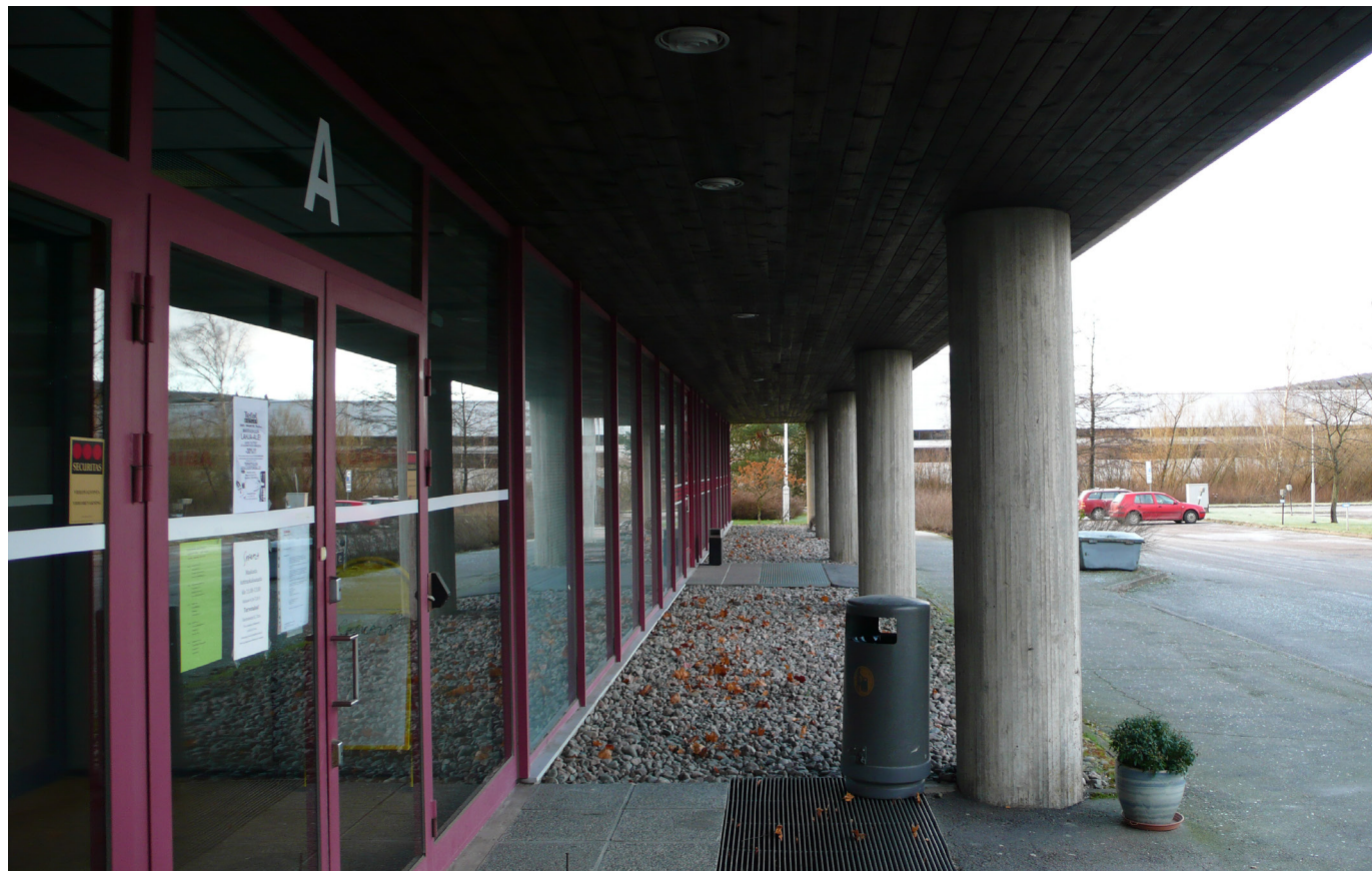
Kuva 13. Pilarit kannattelevat rakennuksen ylempien kerrosten julkisivua. Ikkunat ulottuvat lattiasta kattoon. Synopsis Arkktiehdit Oy, 2024.
