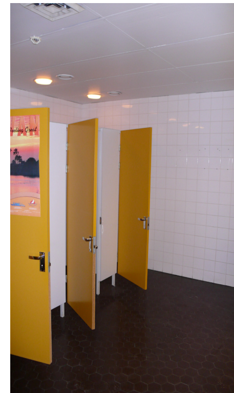
Kuva 52. Liikenne- ja aputilatornissa sijaitsevien saniteettitilojen alkuperäiset keltaiset ovet. JRT Oy, 2008.
