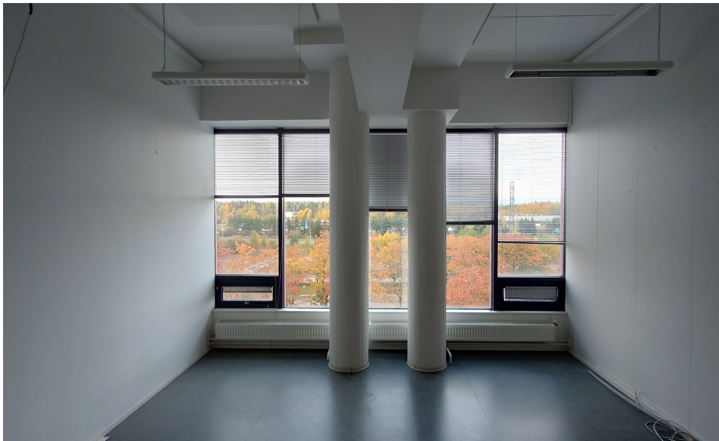
Kuva 39. Vanhan ja uuden osan saumakohta erottuu selvästi rakennuksen sisällä: vasemmalla paikalla valettu pilari-laatta-rakenne ja oikealla pilari-ontelolaatta-rakenne. Synopsis Arkkitehdit Oy, 2024.
