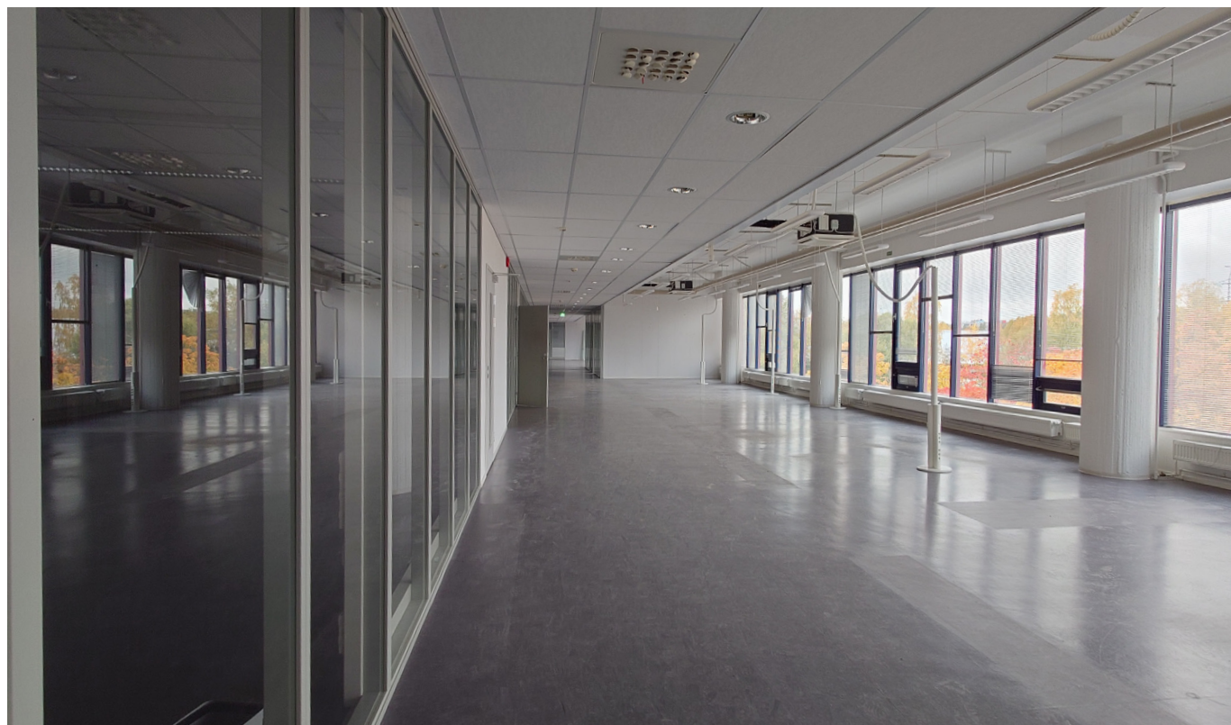
Kuva 86. Kolmannen kerroksen avotoimistoa. Keskelle entistä täysin avointa tilaa sijoitettiin mm. ryhmätyötiloja. Kookolattiamatto on vaihdettu linoleumiin. Synopsis Arkkitehdit Oy, 2024.
