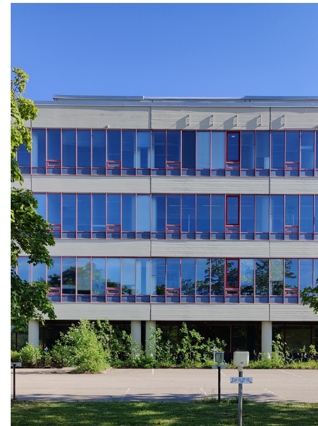
Kuva 40. Kaksoispilarien välissä on vanhan ja uuden osan liitoskohta. Synopsis Arkkitehdit Oy, 2024.
