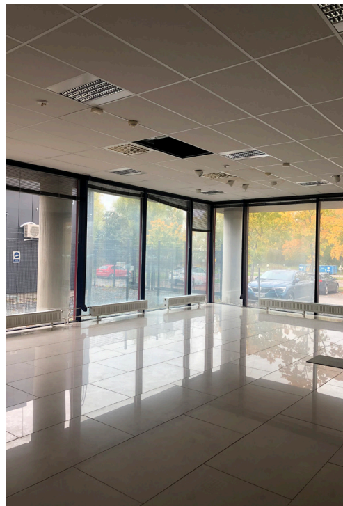
Kuva 68. Ensimmäisen kerroksen lounaiskylmä. Lattioissa on alunperin ollut kokolattiamatto. Synopsis Arkkitehdit Oy, 2024.
