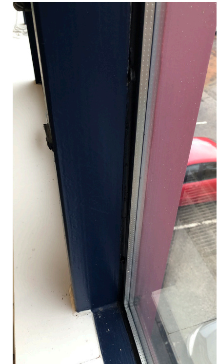
Kuva 82. Kaksilasinen teräsikkuna keittiössä. Synopsis Arkkitehdit Oy, 2024.
