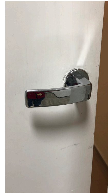
Kuva 81. Alkuperäinen painike keittiössä. Synopsis Arkkitehdit Oy, 2024.
