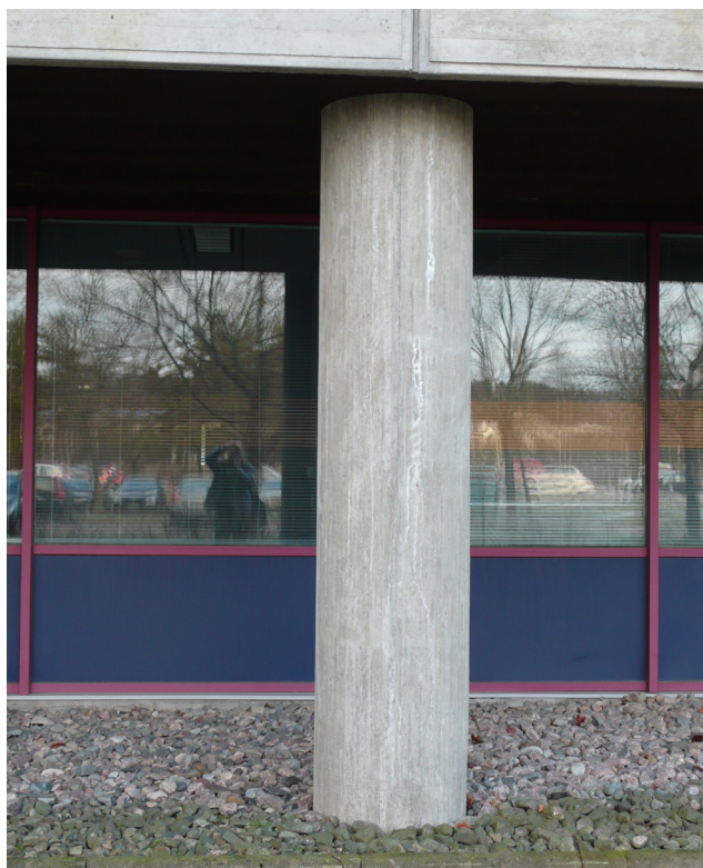
Kuva 41. Sisäänvedetty julkisivu. Pilari kannattelee ylempiä kerroksia. Synopsis Arkkitehdit Oy, 2024.
