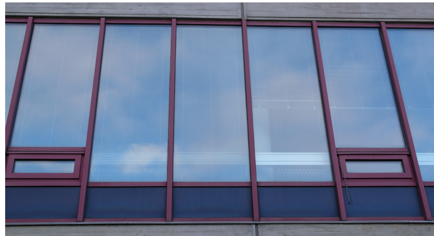
Kuva 42. Tuuletusikkunat on sijoitettu tasaisin välein julkisivuun. Synopsis Arkkitehdit Oy, 2024.
