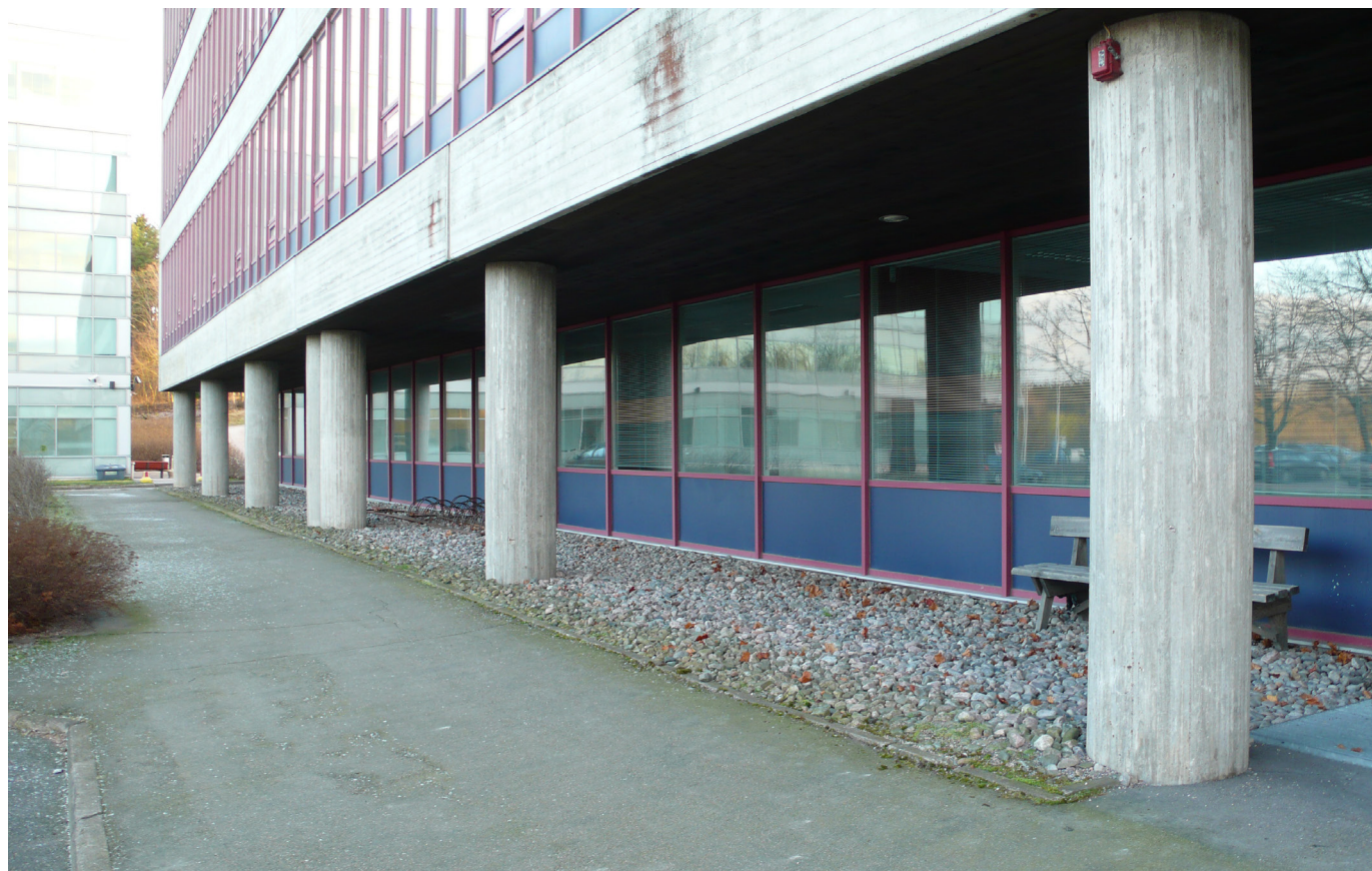
Kuva 14. Pilarit jatkuvat koko julkisivun mitalta. Synopsis Arkktiehdit Oy, 2024.
