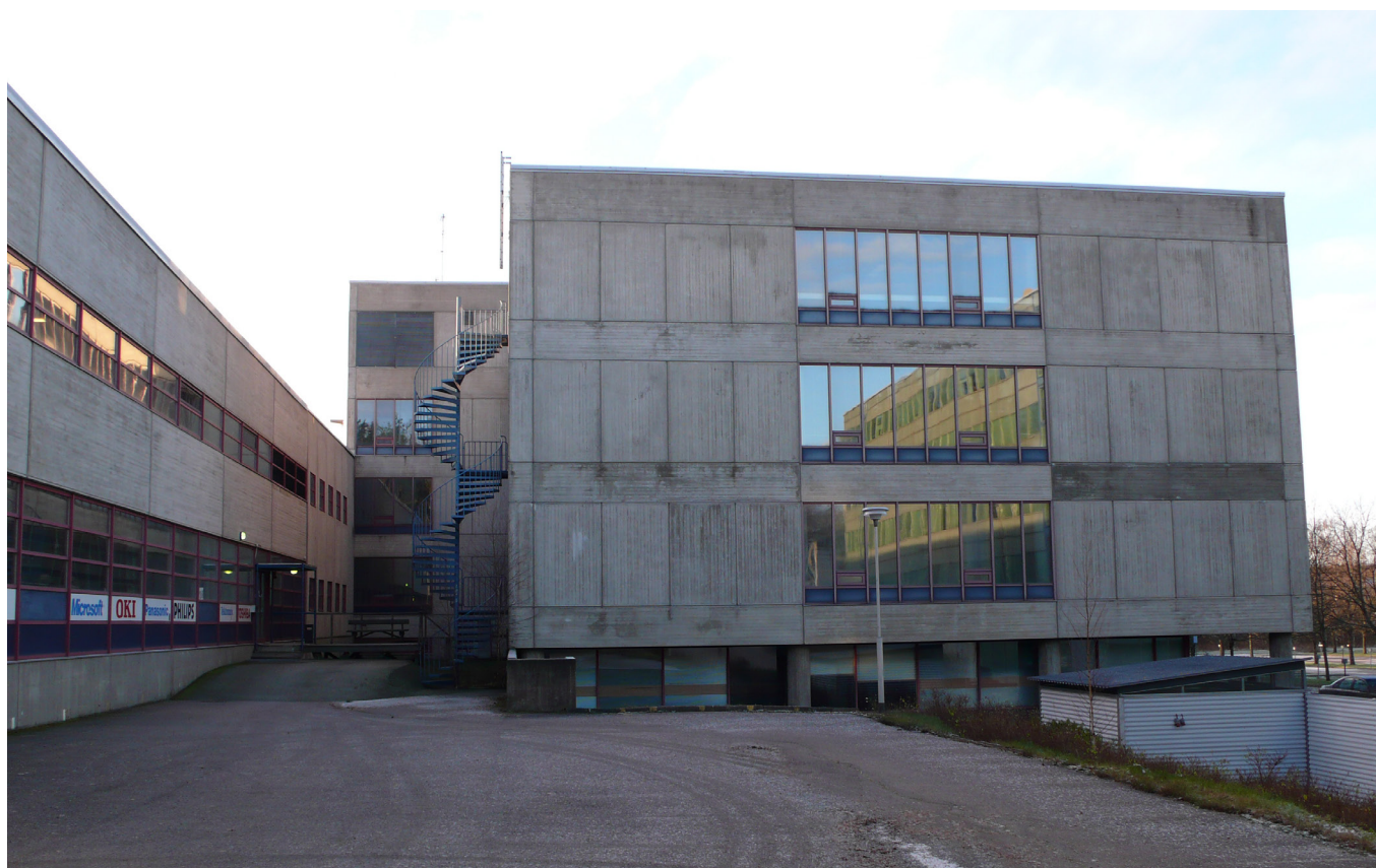
Kuva 22. Itäpääty 2008. Päätyjulkisivu on samannäköinen kuin alkuperäinen ennen talon jatkamista. Kuva JRT Oy
