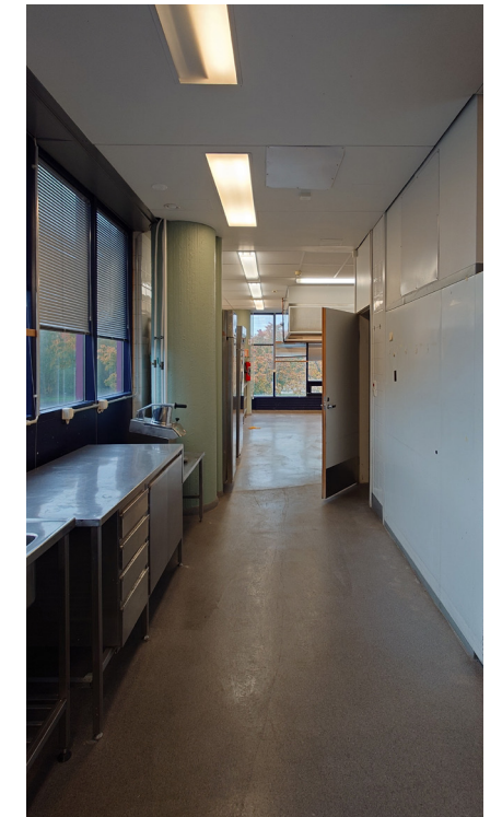
Kuva 76. Pitkä keittiönäkymä. Maalattu lujalevykatto vaikuttaa alkuperäiseltä. Synopsis Arkktiehdit Oy, 2024.
