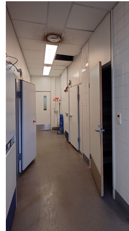
Kuva 74. Keittiössä on säilynyt alku- peräinen Pukkilan lasitettu seinälaa- toitus. Keittiön sintratut lattialaudat on vaihdettu massalattiaksi. Synopsis Arkkitehdit Oy, 2024.
