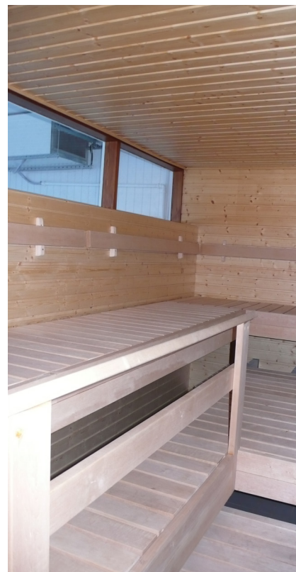
Kuva 64. Saunan panelointi ja lauteet on uusittu. JRT Oy, 2008.
