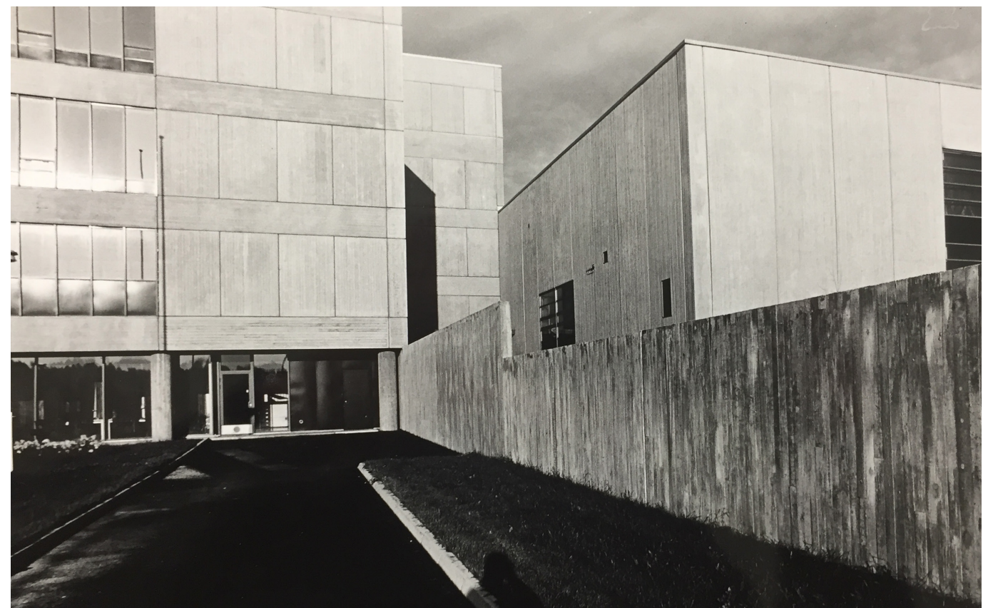
Kuva 27. Rakennuksen länsipäätä, keittiön sisäänkäynti. Vasemmalla varasto-osa. Siren Arkkitehdit Oy, 1974.
