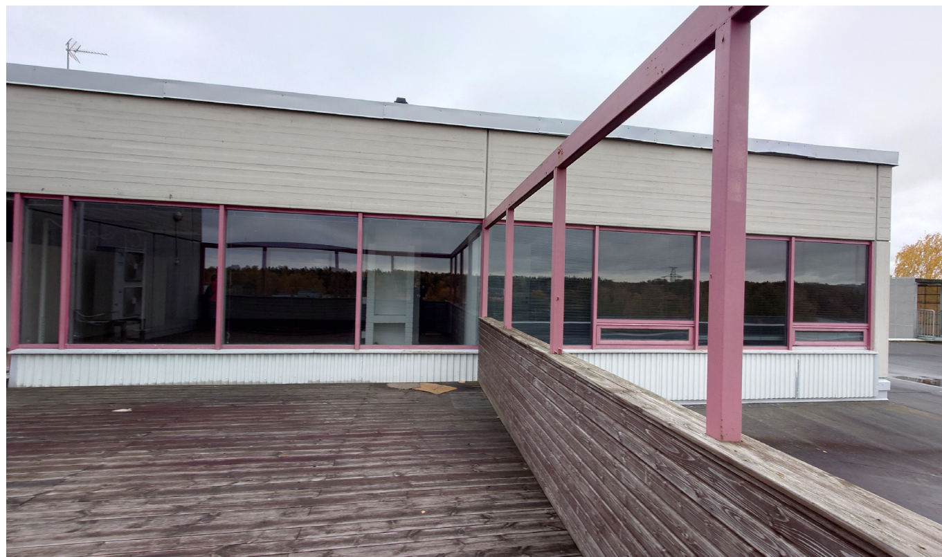
Kuva 97. Vanhan saunaosaston kattamaton ulkoterassi. Synopsis Arkkitehdit Oy, 2024.
