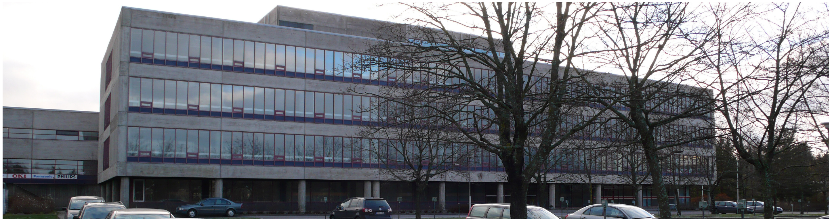
Kuva 43. Toimitalon 1980-luvulla rakennettu osa etualalla. Uuden ja vanhan osan saumakohta on tuplapilarien kohdalla. Uusi osa kuvassa vasemmalla. Varasto-osa näkyy taustalla. Kuva JRT Oy, 2008
