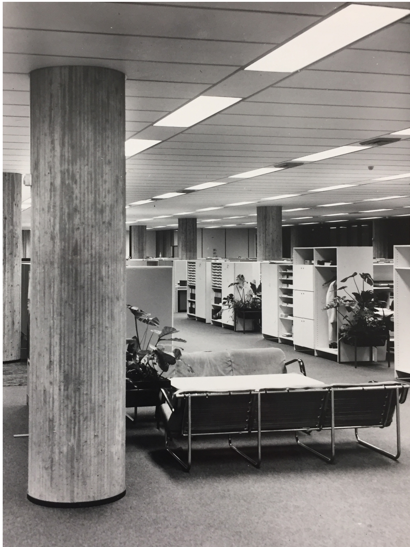
Kuva 25. Alun perin pilarit ovat sisälläkin olleet betonipinnalla. Lattiaa peittää Hyvilla Oy:n ”Manestra” kokolattiamatto. Katossa on ”Karhu” akustolevyt, joihin valaisinjonot on upotettu. Siren Arkkitehdit Oy, 1974.
