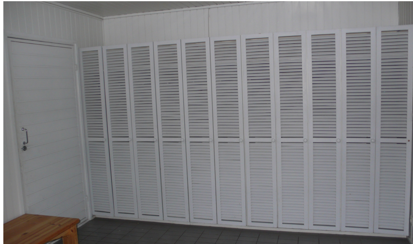
Kuva 63. Pukuhuoneen alkuperäiset mäntysäleovet ja seinien mäntypaneelit sekä katto on maalattu valkoisiksi. JRT Oy, 2008.
