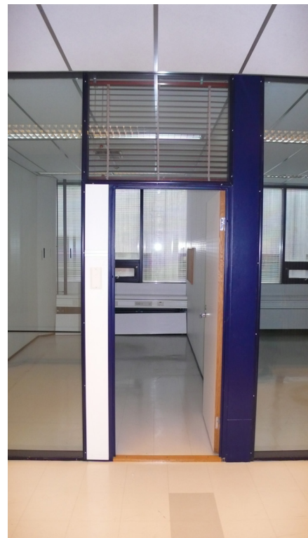
Kuva 51. Alkuperäistä lasiseinää, joka on maalattu ikkunoiden metalliosien kanssa samaan sävyyn. JRT Oy, 2008.
