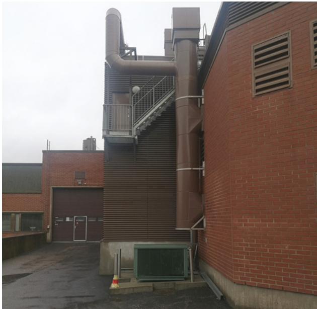
Huippumurin hormi lisättiin rakennukseen vuoden 2013 remontissa.
