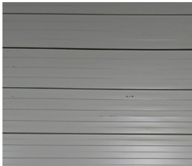
Seinän pintamateriaali on valkoiseksi maalattu teräslery.
