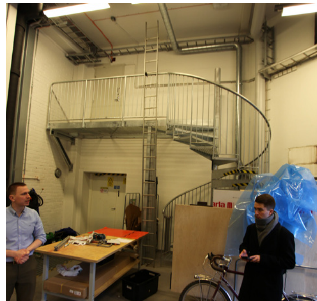
Kevytrakenteiset kierreportaat toimivat seinän takana sijaitsevien toimistotilojen hätäpoistumistienä. Porrastasanteen alla on myös pajatilaan johtava ovi.
