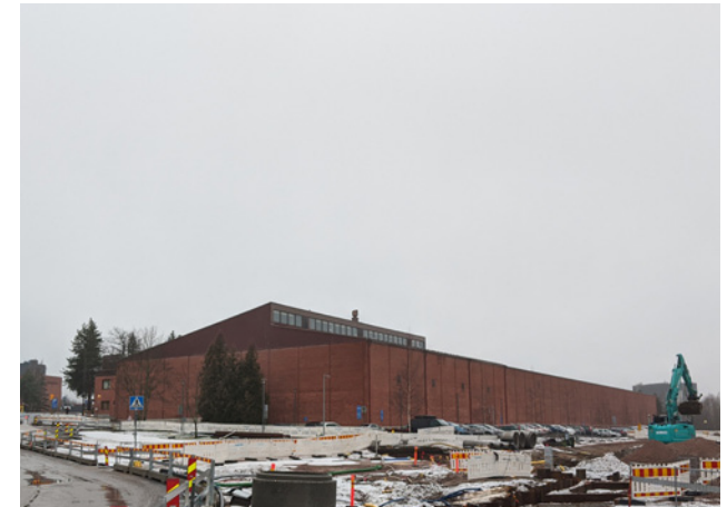
Kattojen pystypinnoissa sijaitsevat nauhaikkunat ovat osa ulkoarkkitehtuuria. Ne tuovat valoa sisään rakennuksen rungon syvimpiin kohtiin.
