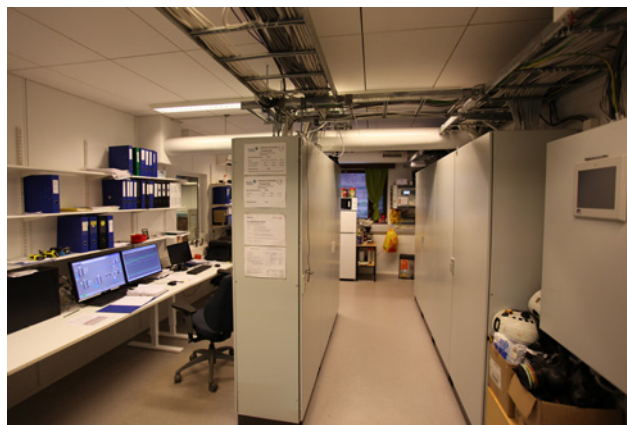
Valvomo poikkeaa pintamateriaaleiltaan muista tiloista. Lattia on päällystetty muovimatolla ja kattoon on asennettu valkoiset akustiikkalevyt.
