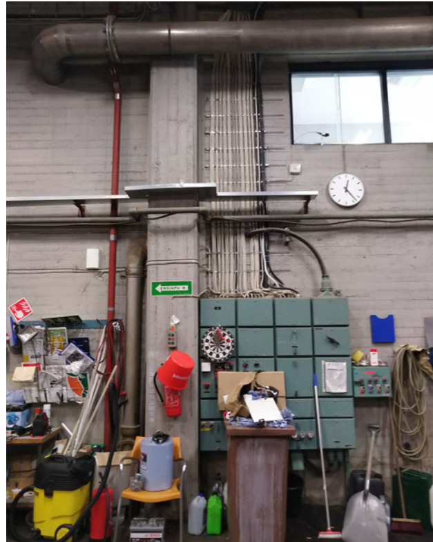
Mallihallin alkuperäistä tekniikkaa.
