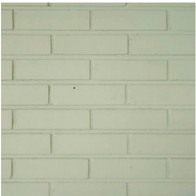
Vihreäksi maalattu tiiliseinä.
