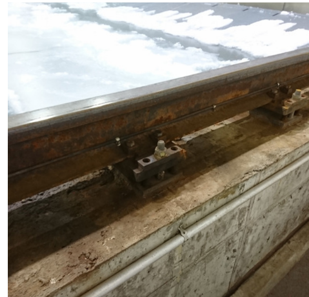
Altaan reuna on raakapintaista betonia.
