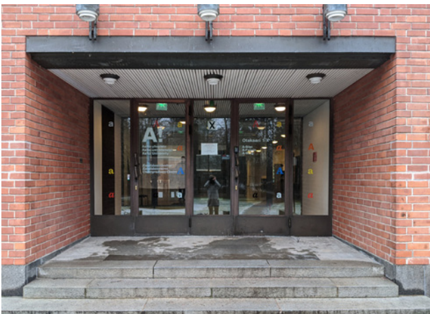
Aalto-yliopiston päärakennuksen sisäänkäynti X, Alvar Aalto 1965.
