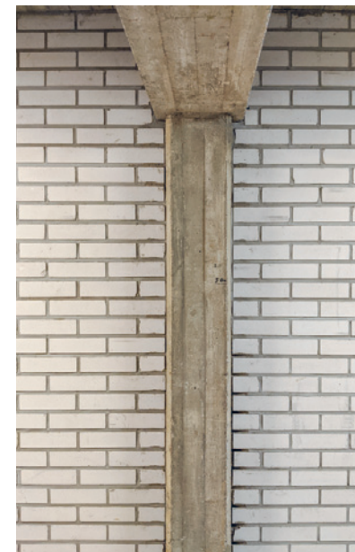
Kantavat rakenteet ovat esillä varaston sisätiloissa.
