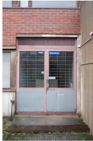
Käyntiovia alkuperäisen osan eteläjulkisivussa
