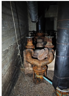
Kuvat E ja F - Putkistoa ja mallikoealtaan tyhjennysputki
