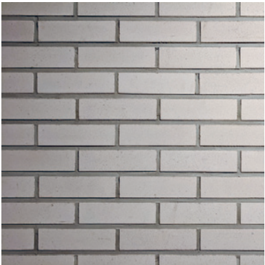
Tiiliseinä harmaalla saumalla
