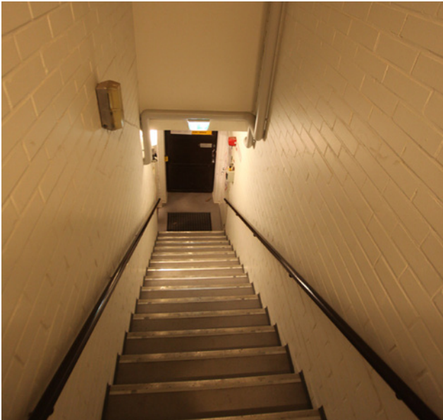
Toisen kerroksen valvomoon johtavat portaavat. Alhaalla näkyy sisäänkäynti, jonka yläpuolella on valvomon wc-tila. Porrashuoneen sivuseinät ovat valkoiseksi maalattua tiiltä. Itse portaavat ovat metallisilla reunalistoilla varustettua betonia.
