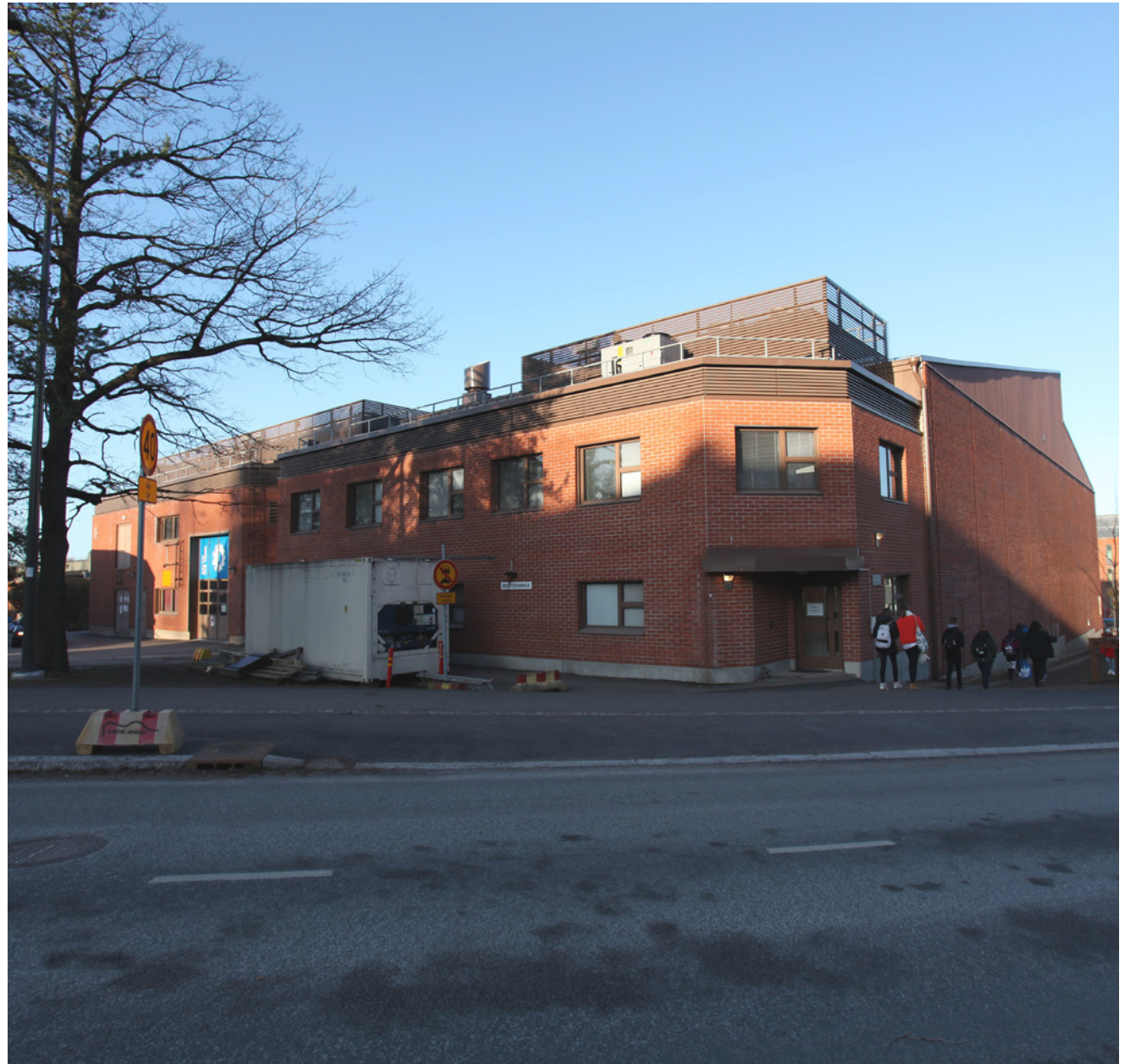
Laajennusosan julkisivu Tietotien metrosisäänkäynnin suunnasta.
