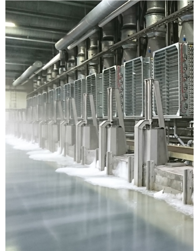
Itäseinällä sijaitsevat jäädytyslaitteiden lisäksi aaltokoneet, joita on yhteensä 16 kappaletta.
