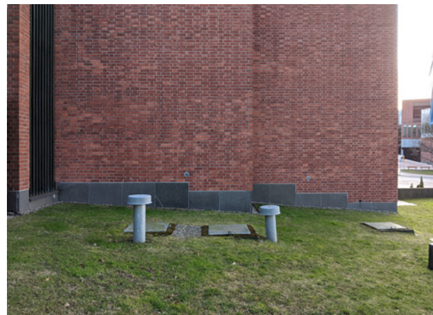
Aalto-yliopiston päärakennuksen porrastuvaa sokkeliä, Alvar Aalto 1965.
