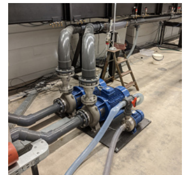
Kourualtaan laitteissa on käytetty samaa sinistä väriä kuin siltanosturin kiskoissa.
