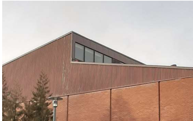
Jääkoehallin yläikkunat ovat tilan eristämisen myötä peitetty.
