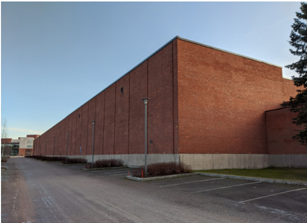
Tietotie 1:ssä on käyttötarkoituksen sanelemana laajoja umpinaisia julkisivupintoja.
