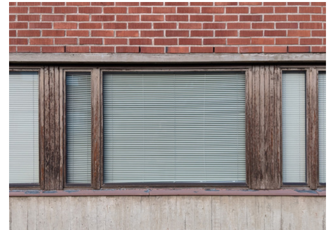
Tietotie 1:n ikkunan karmeissa on käytetty tummaksi maalattua puuta, joka muistuttaa päärakennuksen ikkunakarmeja. Sokkelissa on käytetty lunnonkiven sijaan betonia.
