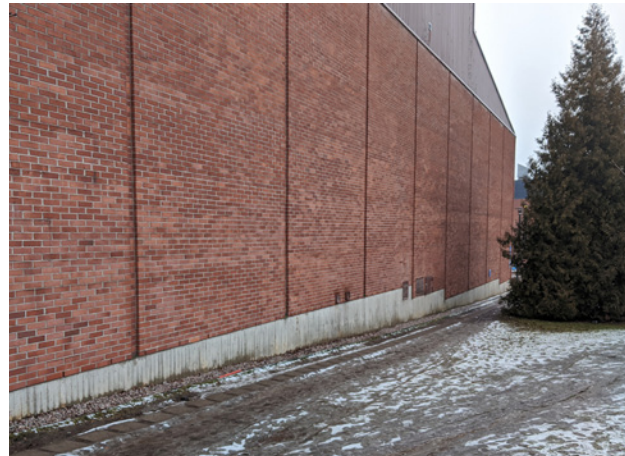
Meritekniikan laboratorio hyödyntää tontilla sijaitsevat korkeuserot esimerkiksi huoltoajaossa. Tämä näkyy muun muassa porrastuvassa sokkelissa.
