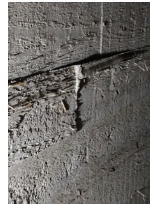
Puumuotin jälkiä altaan seinustan betonivalussa ja maalattian kevytsoraa. 71
