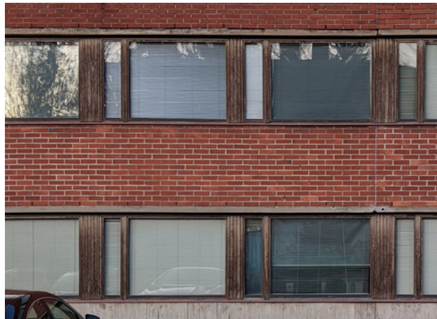
Nauhaikkunan rytmi mukailee kantavia rakenteita.
