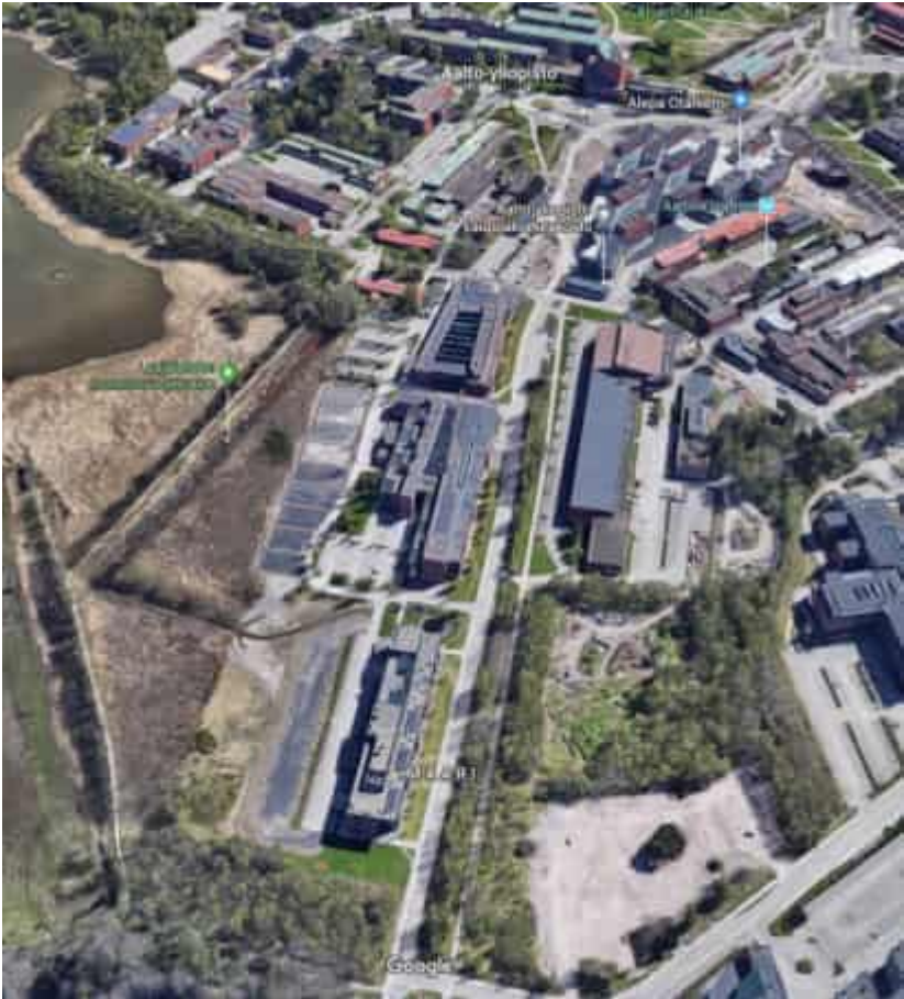
Alueen suhde Otaniemen Väreeseen rakentamisen myötä muuttuneeseen keskusta hahmottuu Google Mapsin 3d-kuvasovituksesta. Aiemmin oikealle kirjaston ohi kaartunut katulinja ohjautuu nykyään suoraan kohti TKK:n entistä päärakennusta.
