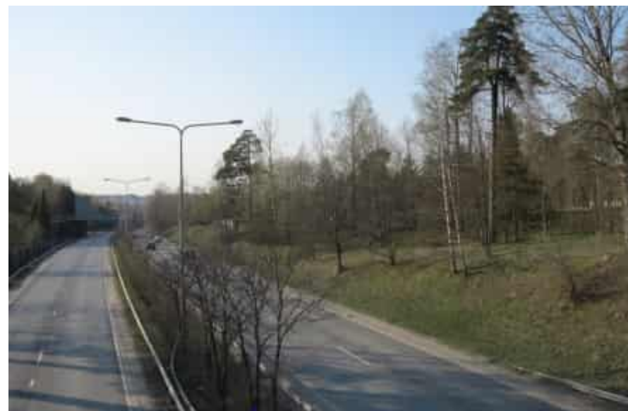
Näkymä Hagalundintietä ylittävältä kevyen liikenteen sillalta pohjoiseen
