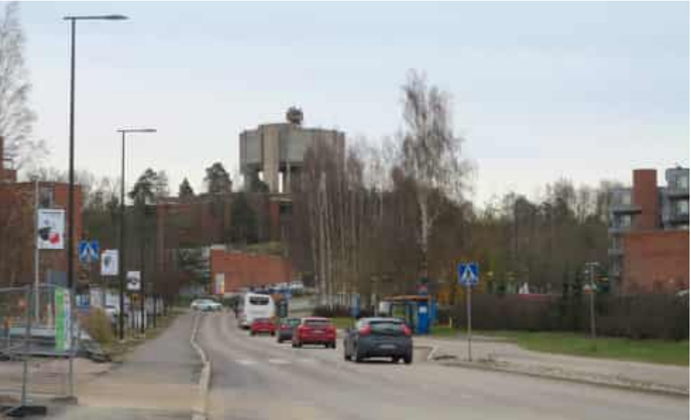
Vesitorni muodostaa hallitsevan päätteen Tekniikantien katunäkymässä
