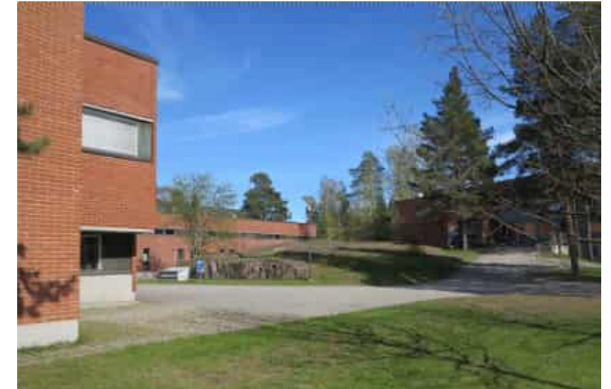
Osoitteessa Tekniikantie 3-5 on pihan keskellä avokallio.
