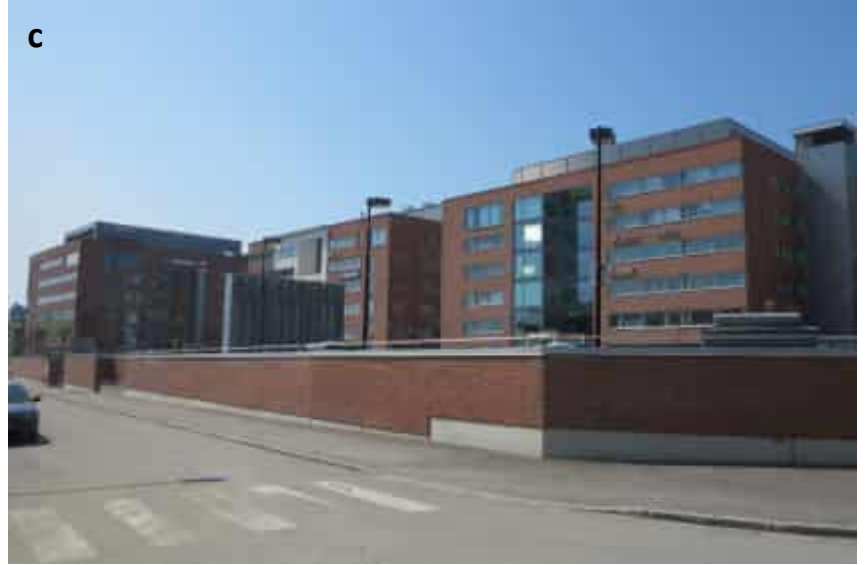
Vaisalantietä rajaa Innopoli 3 :n kansipihan punatiilinen seinämä.
