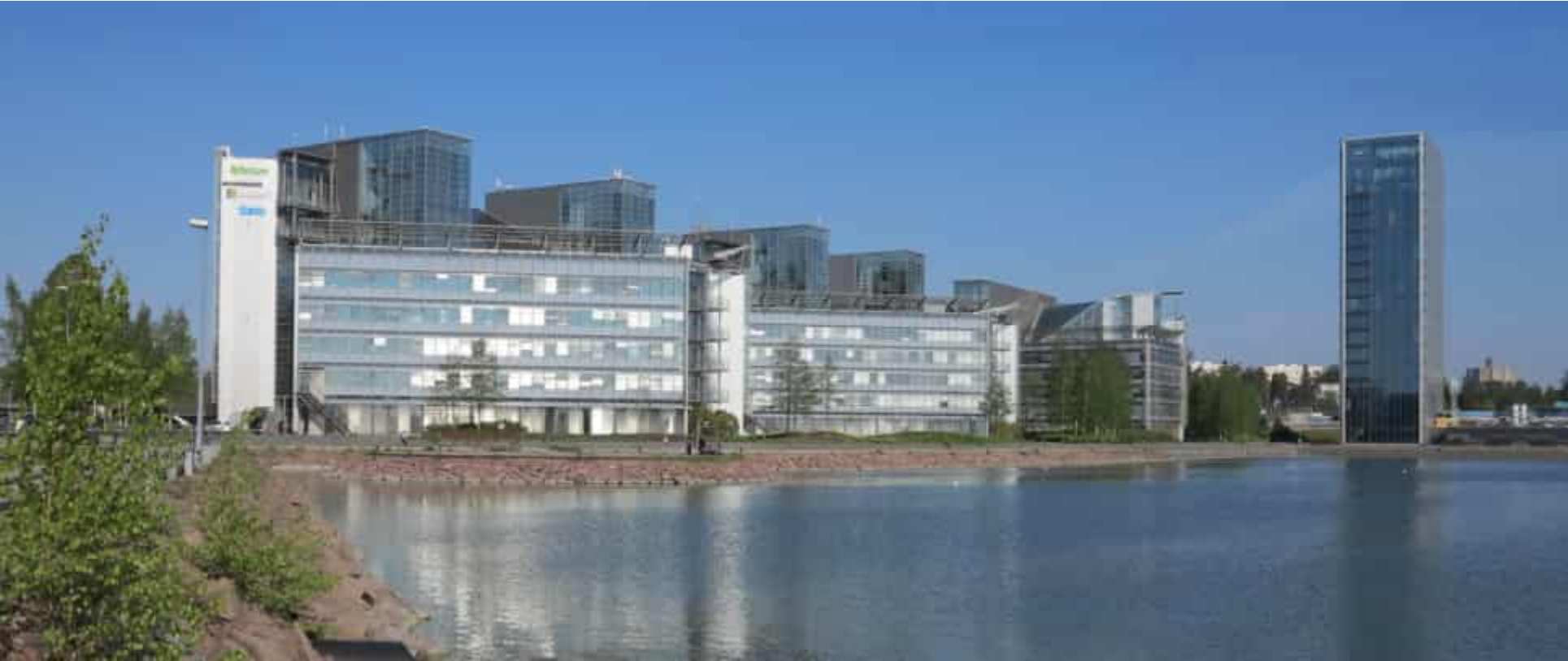
Aluejulkisivu kaakkoon. Poiketen Keilaniemen muista alueista, on osa-alueen ranta luiskattu ja tuettu suurin kivilohkarein. Muualla on rannassa vertikaali betonimuuri. Rannan edustalla on helikopterikenttä.
