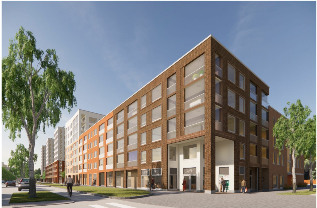
Kuvasta on poistettu kasvillisuutta julkisivun esittämisen takia.
