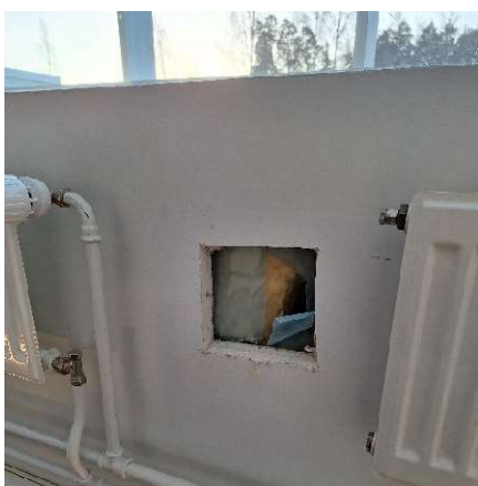
Kuva 23 Rakenneavaus RA2 sisäkautta ulkoseinään käytävällä ZSK11 (alkuperäisosa).
