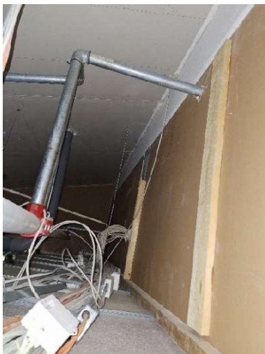
Kuva 76 Yleiskuva laajennososan käytävän alaslaskutista, jossa ei havaittu kosteusjälkiä.
