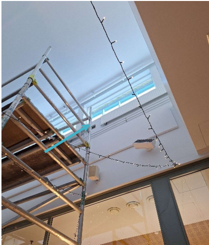
Kuva 25 Rakenneavaus RA3 käytävän ZSK11 ulkoseinälle.
