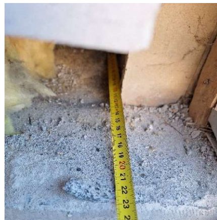
Kuva 40 Puujulkisivun ja tiiliseinän liittymäkohta.
