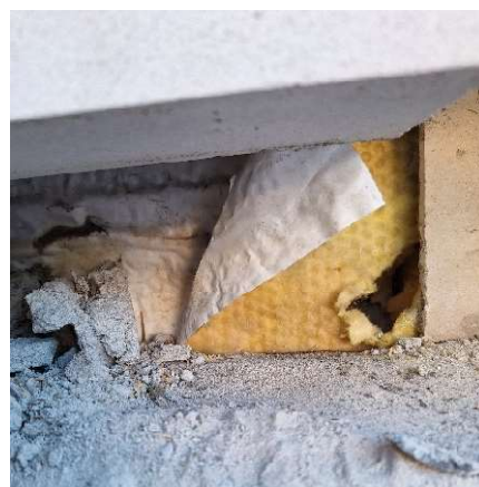
Kuva 42 Sokkelin päällä on bitumikaistale. Villanäyte otettiin sokkelin ja bitumin päältä.
