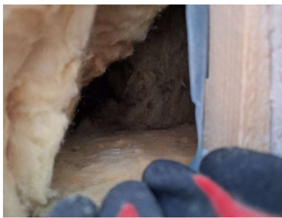
Kuva 24 Rakenne oli: kipsilevyt, höyrynsulkumuovi, lasi-villa, mineraalivilla, tuulensuojalevy.
