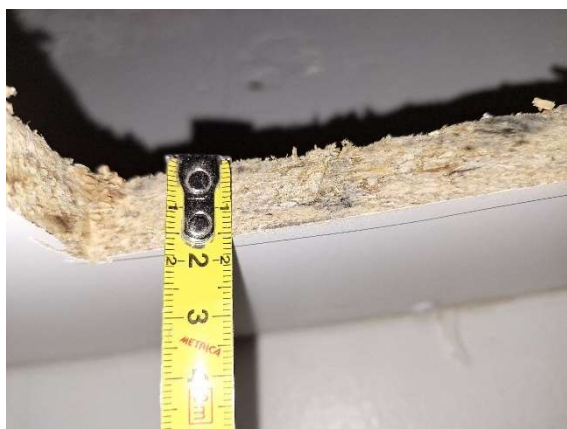
Kuva 22 Kotelointi on tehty 16 mm vahvasta vanerista.
