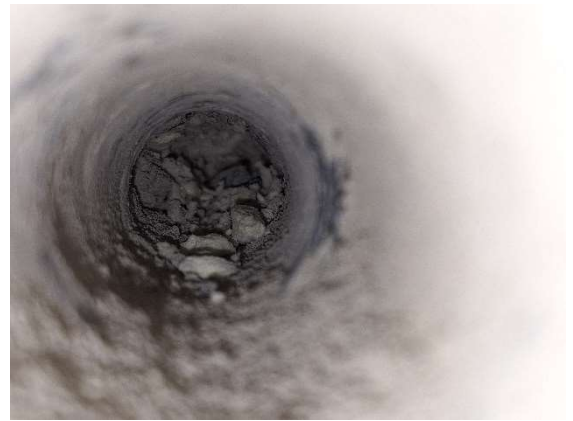
Kuva 46 Sokkelin betonin vahvuus oli 170 mm ja sen takana oli noin 55 mm paksu XPS-eriste.
