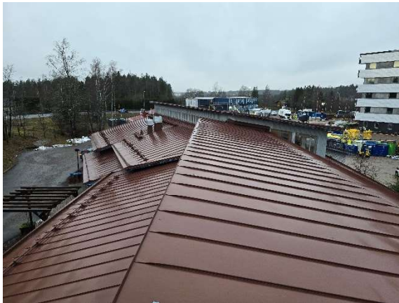
Kuva Alkuperäisosan vesikattoa.
