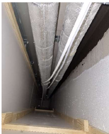
Kuva 20 Kotelossa kulkee kaksi lämmöneristettyä patteriputkea sekä sähköjohtoja. Kotelossa ei havaittu kosteusjälkiä.
