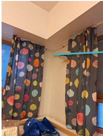
Kuva 15 Tilan SK0007 ulkokulmassa on kotelointi.
