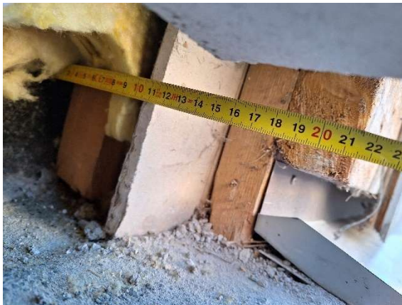
Kuva 39 Puujulkisivun ja tiiliseinän liittymäkohta.
