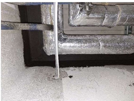
Kuva 21 Ulkoseinän ja välipohjan liittymä sekä johtojen läpivienti ulkoseinässä on tiivistetty.
