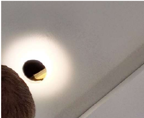
Kuva 74 Laajennososan rakenneavaus aulatilassa.
