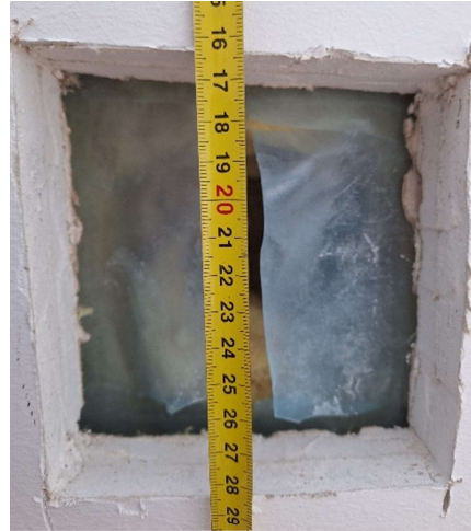
Kuva 26 Avaus tehtiin noin 165 mm yläikkunoista alaspäin pattereiden väliin.
