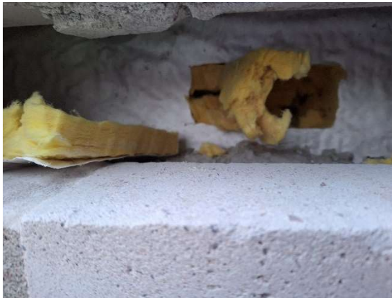
Kuva 37 Rakenneavauksesta otettiin villanäyte noin 1030 mm maanpinnan yläpuolelta, kolmannesta tiilivistä.
