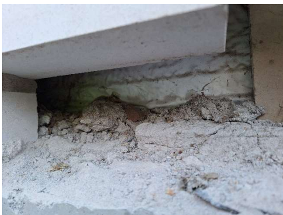
Kuva 41 Avauksen RA7 kohdalla tuuletusväli on paremmin avoinna.
