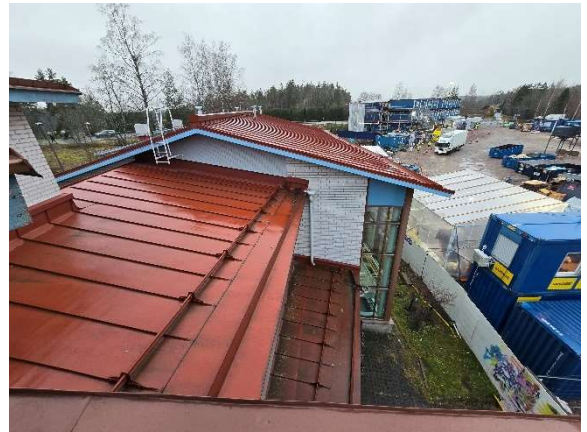
Kuva 61 Laajennososan ja yhdyskäytävän vesikattoa.
