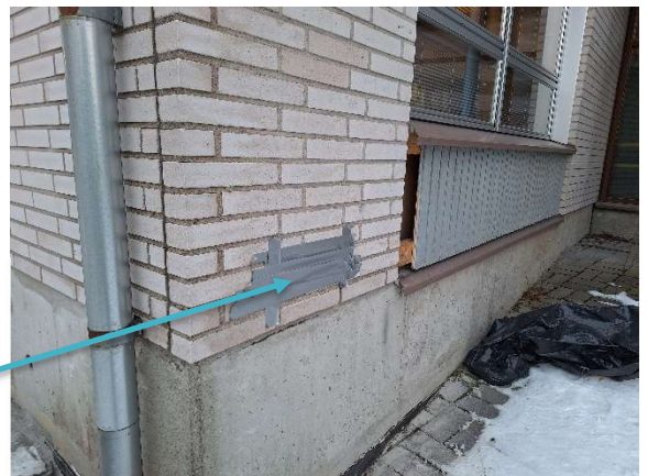
Kuva 30 Avaukset RA4 (puu) ja RA5 (tiili) alkuperäisosan päätyseinään tilan SK0007 kohdalle.
