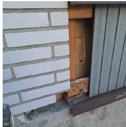
Kuva 38 Rakenneavaukset RA6 (puu) ja RA7 (tiili) tilan SK0007 pitkälle sivulle. Julkisivulaudoituksen kohdalla on pellitys.
