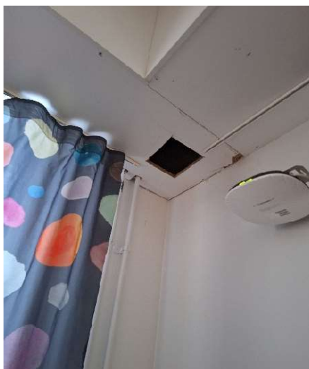
Kuva 19 Tilan SK0007 kotelointiin tehtiin pieni avaus.
