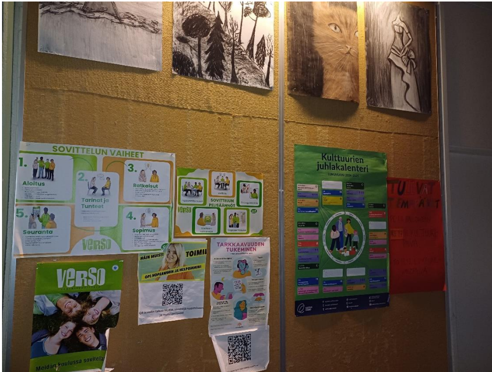
Kuva 4.11. 2krs. käytävien ilmoitustaulut ovat huonossa kunnossa.
