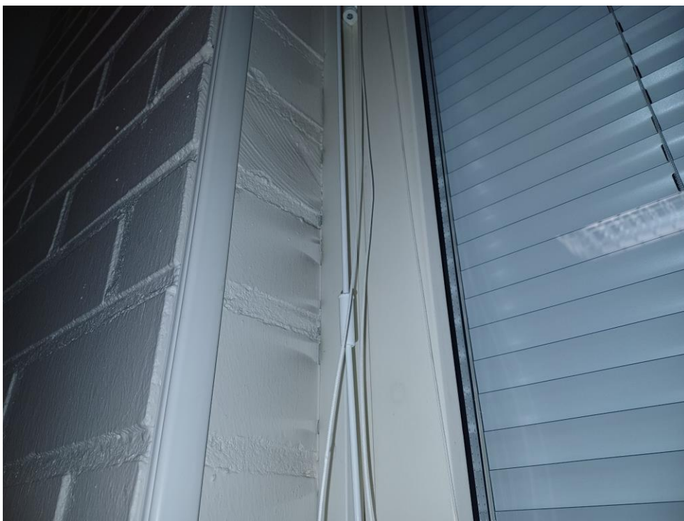
Kuva 4.4. 1064 kuraattorin tila, ikkunaliittymistä on runsaasti ilmavuotoja.
