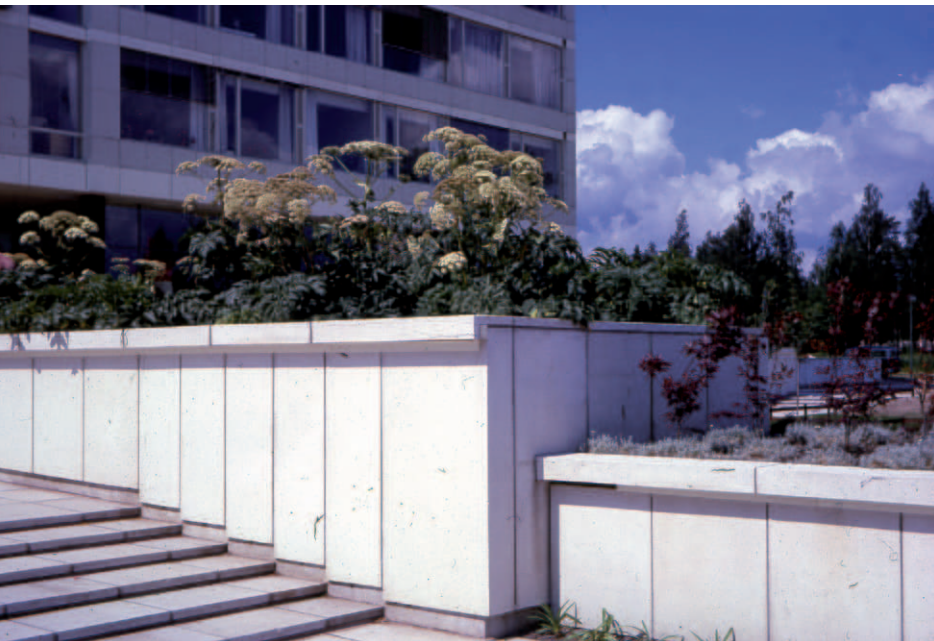
Portaan istutusaltaissa oli 1960-luvulla ukonputkea ( Heracleum ) ja japaninvaah- teraa ( Acer palmatum ), jotka vietiin tal- veksi Tapiolan Lämmön kasvihuoneeseen. Kuva: Jussi Jänneksen arkisto (SRM)
