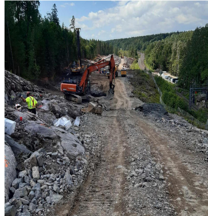
Espoon kaupunkiradan louhintaa Kaupunginkalliossa. Kuva: Lasse Kämpe
