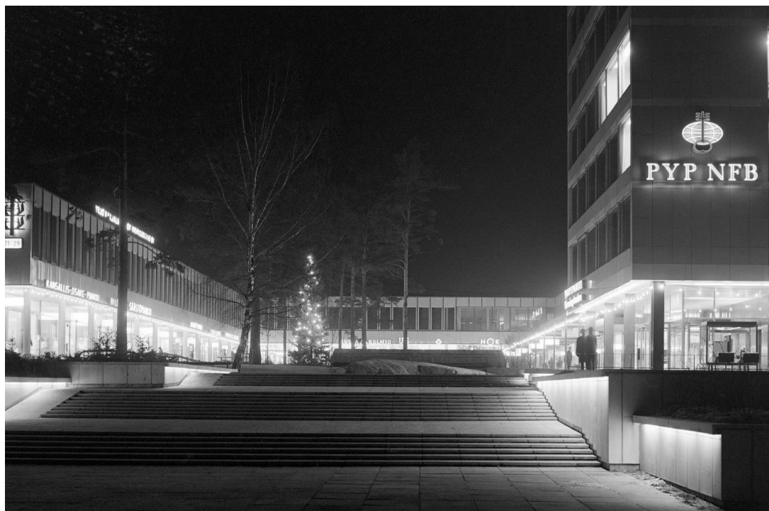
Näkymä Tapiontorin sisäpihalle ja sisäpihan julkisivuja vuonna 1963.
