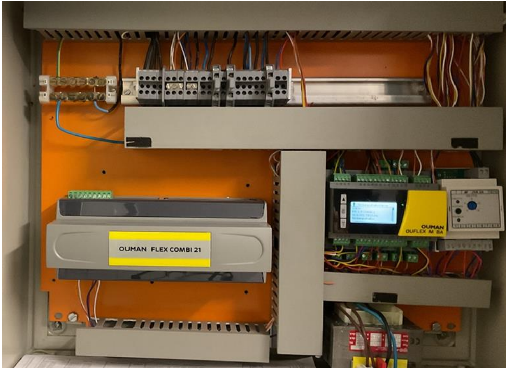
Kuva 6.1. Rakennusautomaatio.
