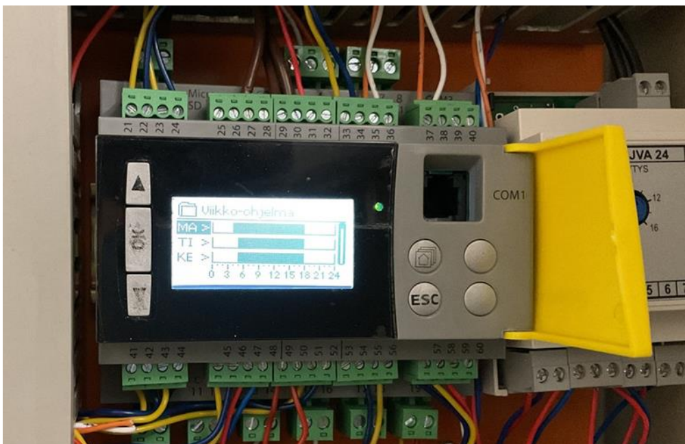
Kuva 6.2. Aikaohjelma, käyttönappeja käytetty kovakouraisesti.
