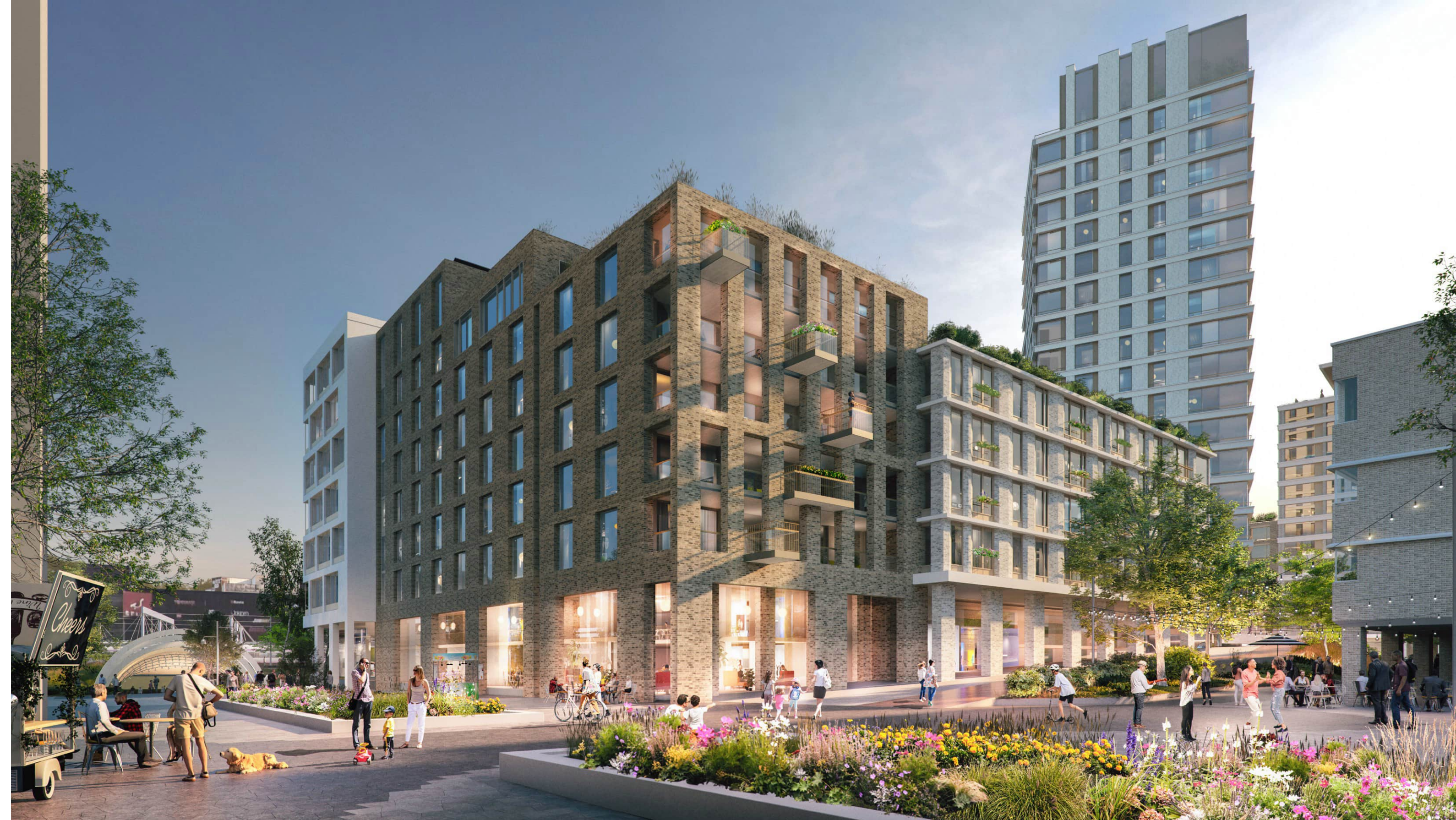
NÄKYMÄ MÄÄRÄTYSTÄ NÄKYMÄPISTEESTÄ LÄKKITORILTA LOUNAASEEN
