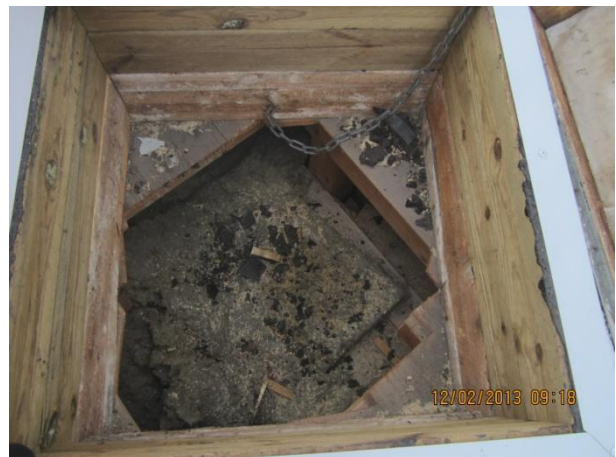
Kuva 22 Tarkastusluukun alla on IV-kanavan tarkastusluukku, jonka kohdalta on ahdas pääsy yläpohjaonteloon.
