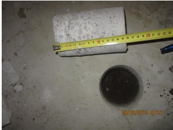
Kuva 7 Alapohjan rakenneavaus AP-AV1, laatan paksuus 160 mm, alla hienoaaineksia sisältävää soraa.
