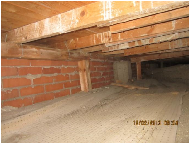
Kuva 25 Ulkoseinän vierellä eristeiden päällä on tuulisuojana reijitettyä alumiinipaperia.
