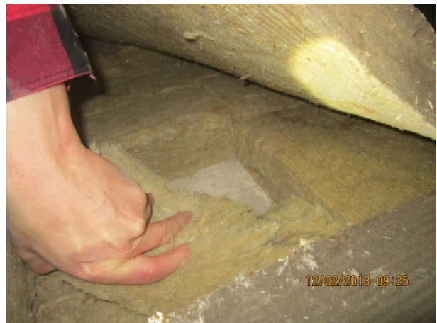
Kuva 28 Eristepaksuus on 15 cm, alla on betonilaatta.
