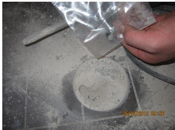
Kuva 20 Laatoituksen ja pintalaatan alla on vedeneristeenä bitumikermi.
