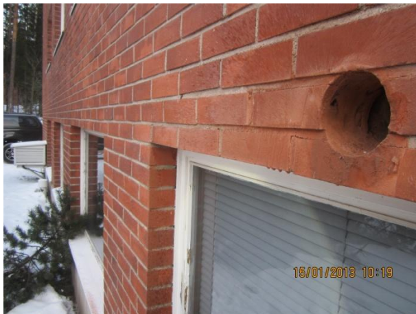
Kuva 9 Rakenneavaus AV3 länsisivulla.
