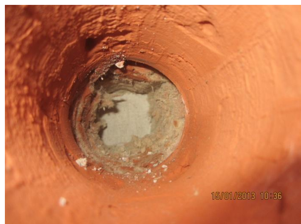
Kuva 12 AV4 kohdalla tiilimuuraus, takana eristevilla ja tb-sisäkuori.
