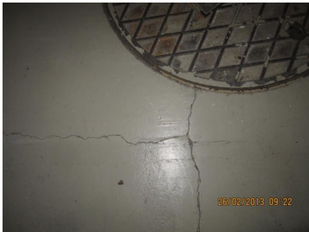
Kuva 9 Laatan halkeilua.
