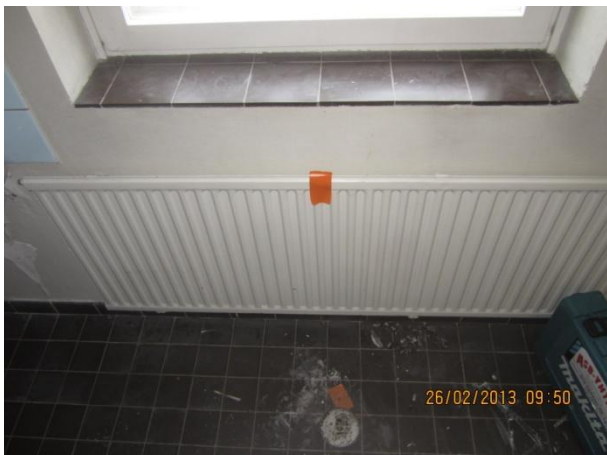
Kuva 19 Välipohjan märkätilan avauspaikka pohjoispäädyn wc-tilassa VP-AV1
