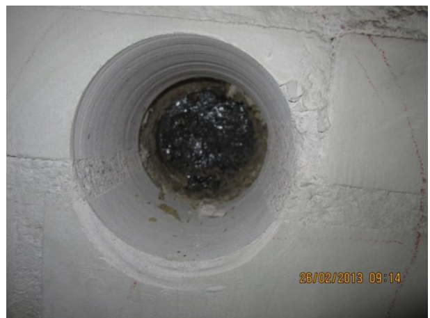
Kuva 14 Avaus MP-AV3 itäisivulla, tiilen ja mineraalivillan jälkeen bitumisively.
