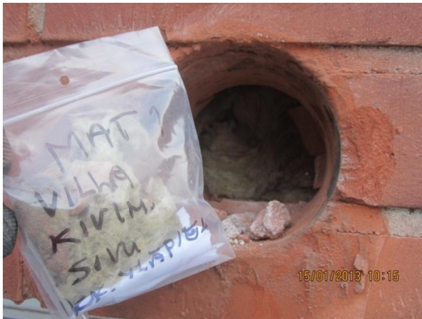
Kuva 17 AV3/ MAT1 länsisivulta 1. kerroksen ikkunan yläpuolelta, eristevillaa. Samasta kohtaa otettiin myös MAT2, jossa oli tiiltä ja laastia muurauksen sisältä.
