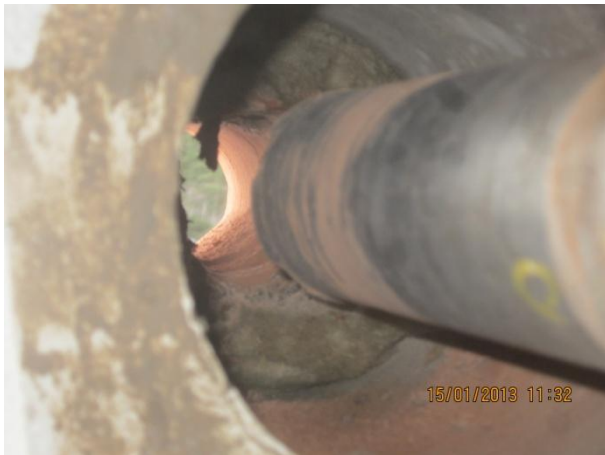
Kuva 15 Julkisivutiilen läpi porattiin 50 mm:n lieriöporalla
