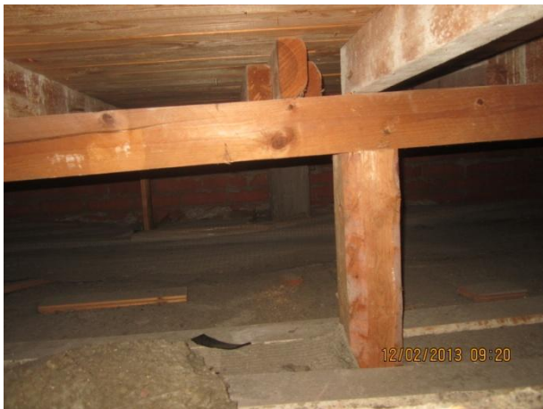
Kuva 23 Vesikaton tukirakenteet ovat suunnitelmien mukaiset. Kattotuolit ovat 50x100 puutavaraa.
