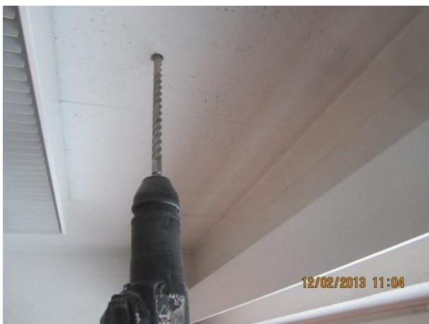
Kuva 29 Yläpohjan kantavaan laattaan tehtiin alaspäin läpiporaus, 160 mm betonia, yläpuolella on villaeristys.
