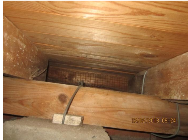
Kuva 26 Räystäällä tuuletusaukko on varustettu verkolla, kattotuolien tuulisteet.
