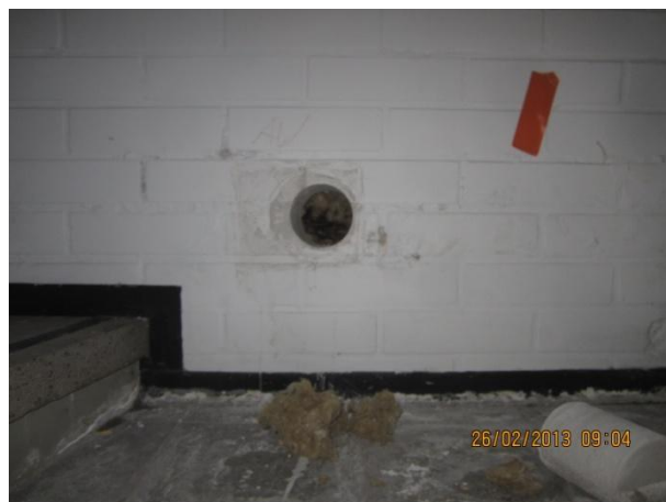
Kuva 13 Maanpaineseinän rakenneavaus MP-AV2 portaan välitason yläpuolelle
