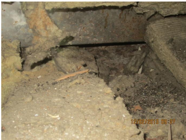
Kuva 27 Pistesyöpyimiä peltikanavassa.
