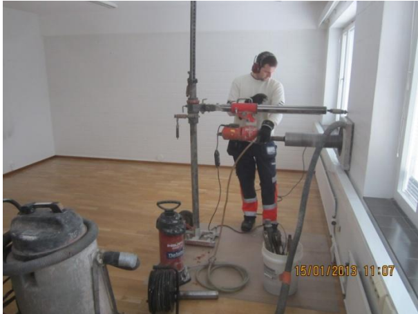
Kuva 13 Rakenneavaus AV5 6. kerros länsisivulla.
