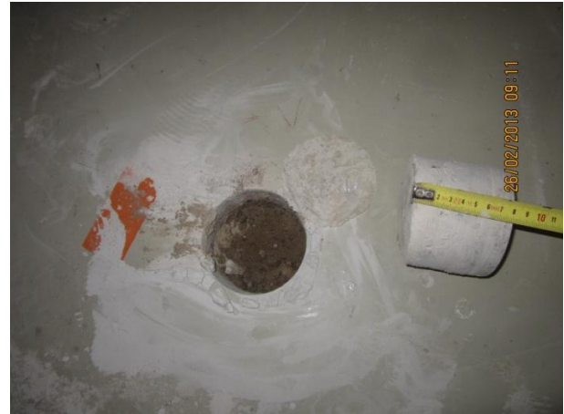
Kuva 8 Alapohjan rakenneavaus AP-AV2, laatan paksuus 80 mm, alla muovikalvo ja hienojakoista soraa.
