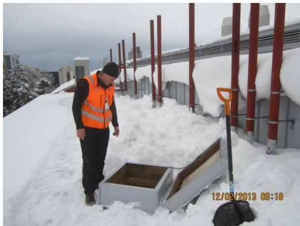
Kuva 21 Yleiskuva vesikatoilta, avattu kulkuluukku itäsivulla räystäään ja IV-konehuoneen välissä.
