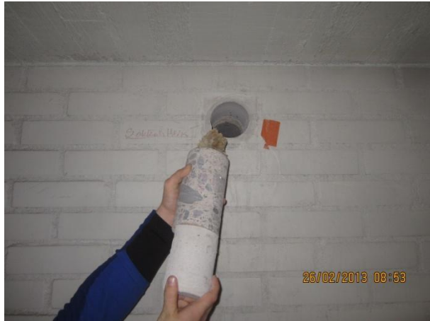
Kuva 11 Maanpaineseinän rakenneavaus MP-AV1 länsisivulle katorajaan.
