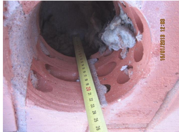
Kuva 6 AV1 kohdalla tiilipinnasta betoniseen sisäkuoreen on n. 230 mm.
