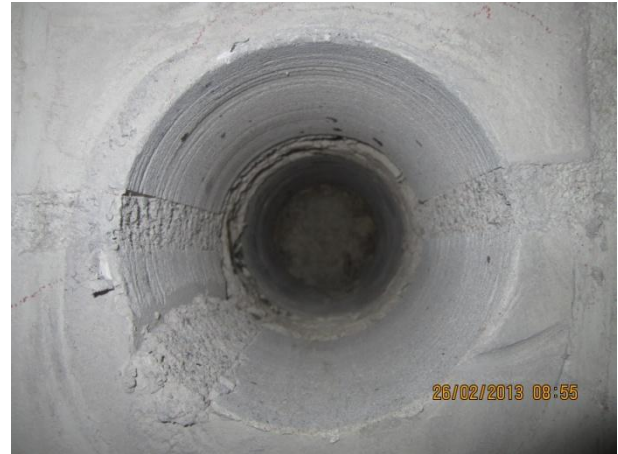
Kuva 12 Avaus MP-AV1 tehtiin sokkelihalkaisuun asti.
