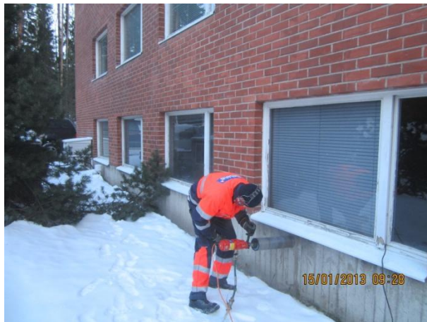
Kuva 7 Rakenneavaus AV2 länsisivulla.
