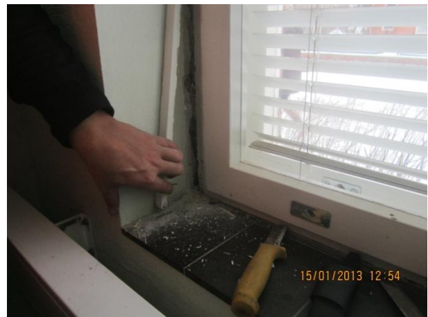
Kuva 20 MAT7 1. kerroksen ikkunan pielen villarive ja laasti.
