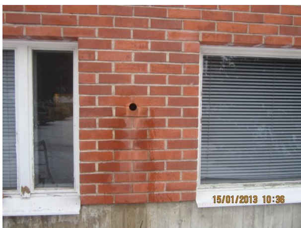
Kuva 11 Rakenneavaus AV4 länsisivulla.
