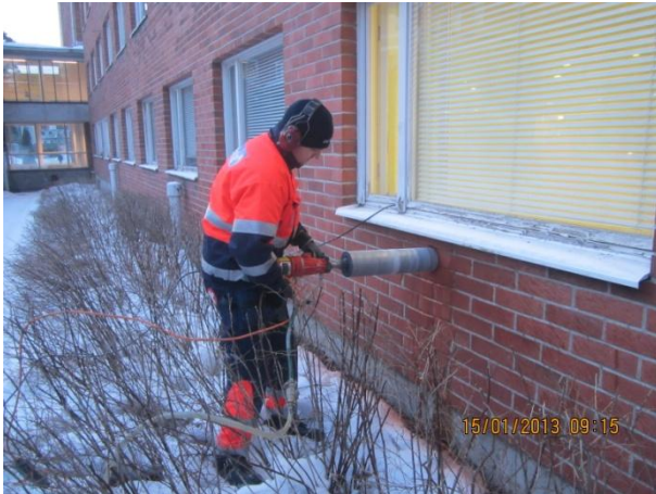
Kuva 5 Rakenneavaus AV1 itäsivulla.
