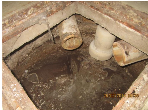
Kuva 10 Keskialueen salaojakaivo, jossa on ruukkuputkia, märkää maata pohjalla.
