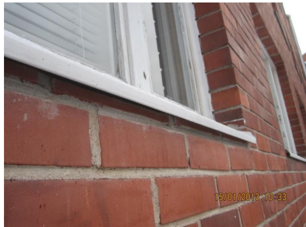
Kuva 4 Uusittujen vesipeltien alla on uudehko korotusmuuraus.
