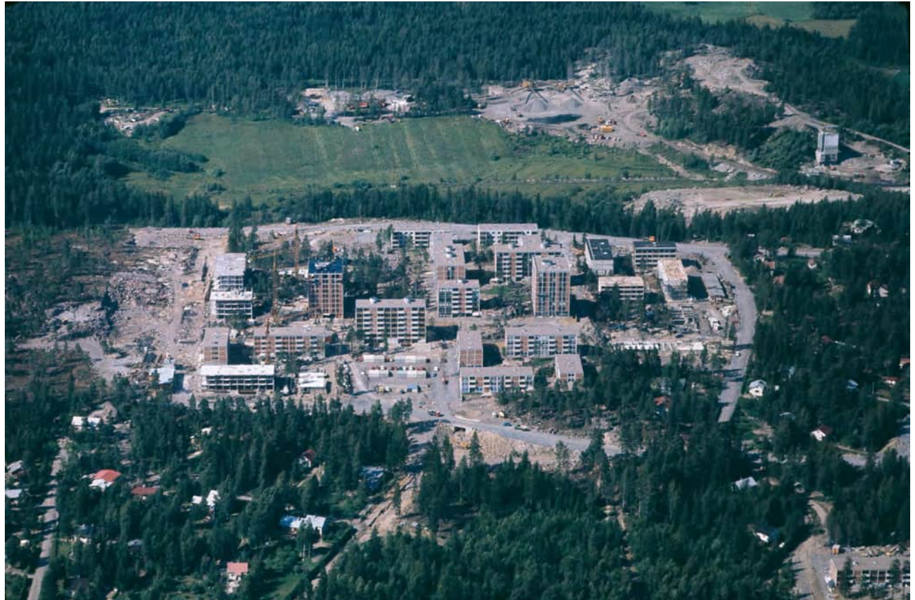
↑ Olarin keskus rakentumassa heinäkuussa 1970. Taustalla näkyvä avoin nurmikenttä on Olarin koulun tuleva rakennuspaikka. Kai R. Lehtonen. EKM.
