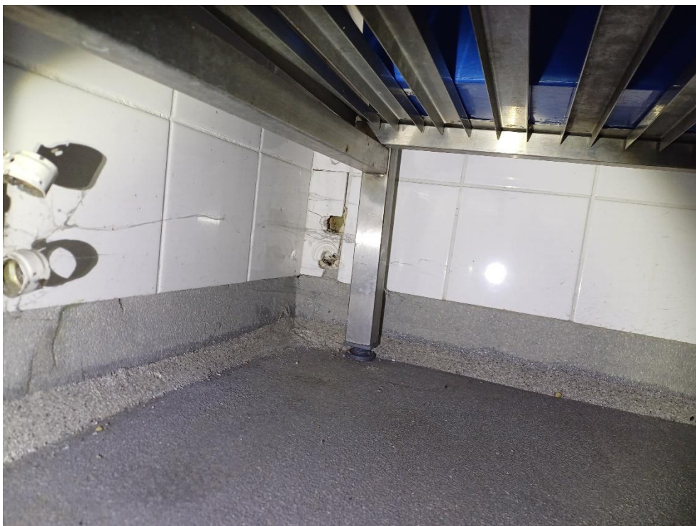
Kuva 4.9. 128 Keittiö, purettujen vesijohtojen läpiviennit ovat tiivistämättä.
