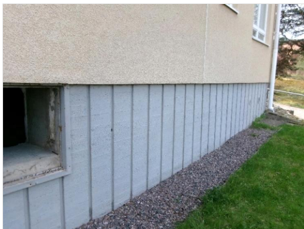
Kuva 13. Rakennuksen B-osan ryömintätilaan on kaksi lukittavaa käyntiluukkua, joista toinen tekstiilityöluokan/kotitalousluokan 1 kohdalla (kuvassa). Ryömintätila rajoittuu käytävän luokkien puoleisen seinän kohdalle ja on avointa tilaa luokkien 017, 015, 018 ja 023, sekä tilojen 024 ja 025 alla.
