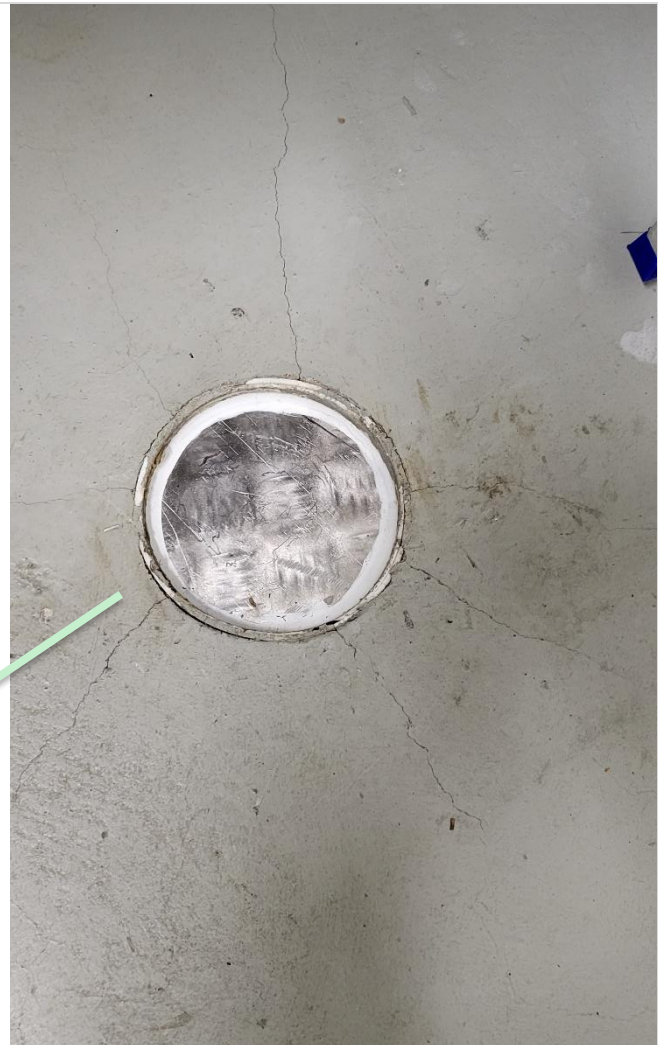
Kuva 21. Tutkimusten aikana kaivo tulpattiin. Poikkeavia hajuhavaintoja ei tehty.
