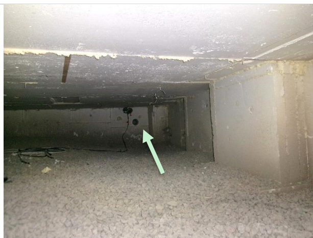
Kuva 14. Yleisilme on siisti ja ilma lähes hajuton. Maatäytön päällysteenä on sorakerros (>200 mm). Kuvan 13 luukun edestä otetussa kuvassa näkyy ryömintätilan päätyseinän korvausilma-aukko. Lattian alapinta ja seinät on ryömintätilassa lämmöneristetty laadukkaasti.
