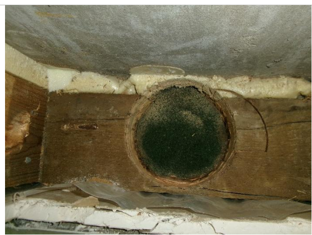
Kuva 2. Näyte ASB 2, 152 työtilan ulkoseinän bitumikaista alaohjauspuun alta ei sisällä asbestia.
