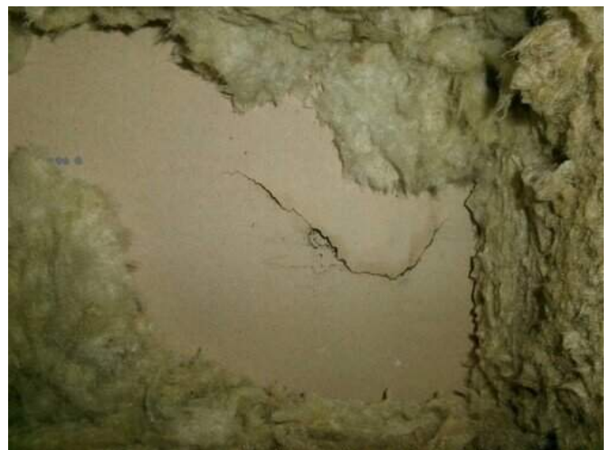
Kuva 43 Tuulensuojakipsilevy rikkoutunut
