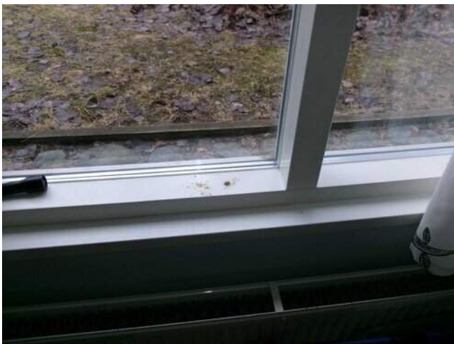
Kuva 52 Liikuntasalin kiinteän lämpölasi-ikkunan karmiin tehtiin rakenneavaus asennusvälin eristeen selvittämiseksi.
