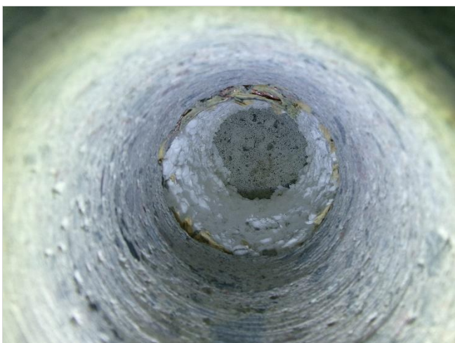
Kuva 20. Alapohjarakennetta tutkittiin timanttioralla tehdyistä rei'istä, kuvassa AP2 alapohja tilassa 151 pesuhuone RA24.
