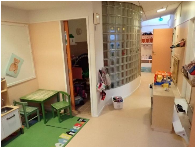
Kuva 16. Käytävillä ja ryhmätiloissa on lattiapäällysteenä muovimatto.
