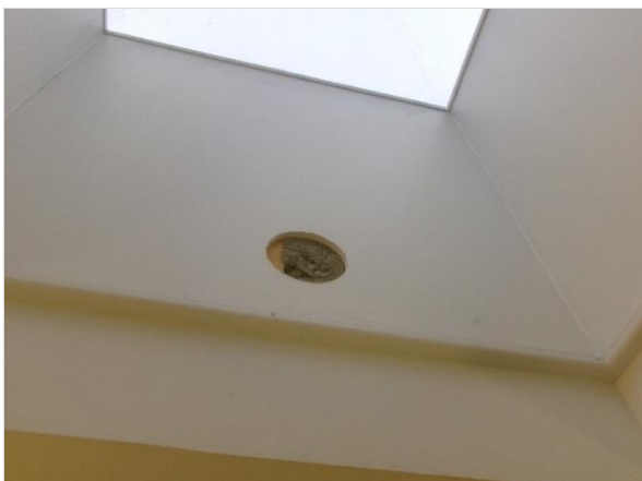
Kuva 50. RA11 tehtiin aulaan 146 kattoikkunan ylösnostoon.
