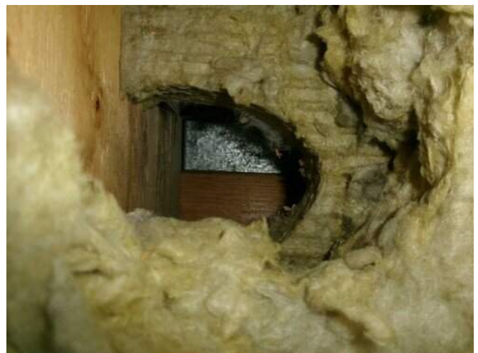
Kuva 12 Peltikatteen alla ei ollut aluskatetta.
