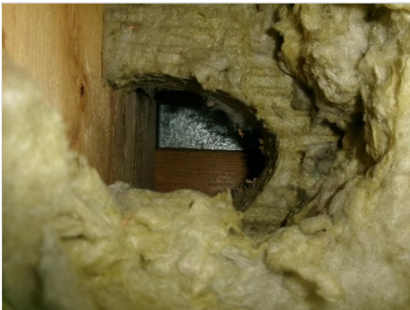
Kuva 48. RA6 tehtiin leikkitilaan 154, jossa todettiin rakenteen olevan suunnitelmien mukainen ja rakenteessa ei ole aluskatetta.
