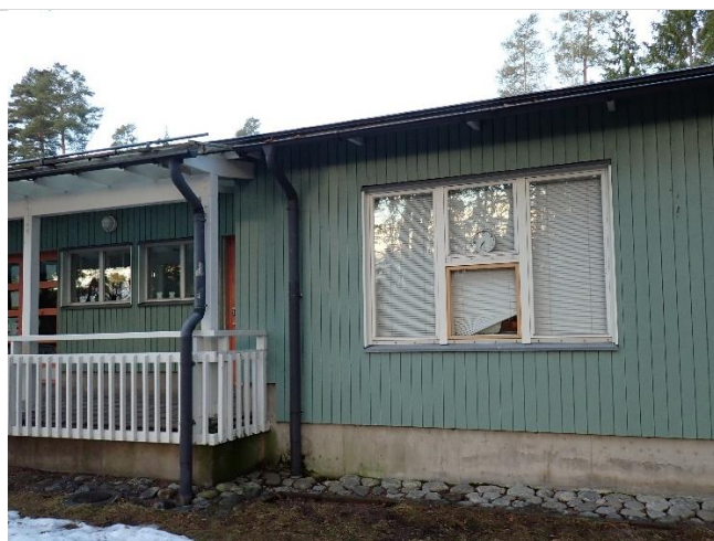
Kuva 35. Rakennuksen sadevesijärjestelmä oli uusittu 2005. Syöksyt olivat kunnossa. Sokkelissa havaittiin yleisesti vähän merkkejä kosteusrasituksesta.
