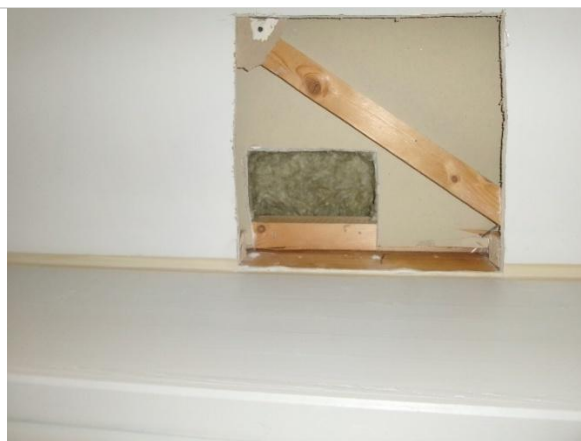
Kuva 51. Yläpohjan rakenneavauksia tehtiin kolme, RA14 tehtiin liikuntasalin kattoon kantavan palkin viereen keskelle tilaa.
