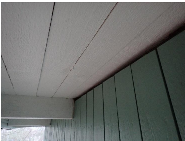
Kuva 32. Rakennuksen ”päätyjä” lukuun ottamatta rakennusta kiertävät noin 500 mm:n räystäät.
