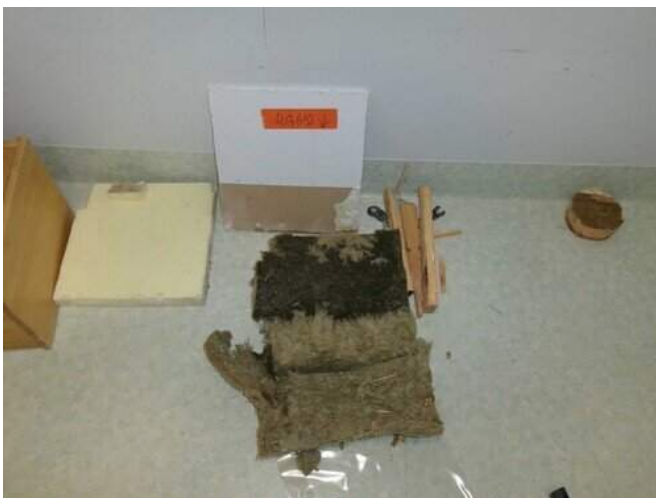
Kuva 14 Lämmöneristeessä runsaasti ilmavuodosta johtuvaa tummentumaa
