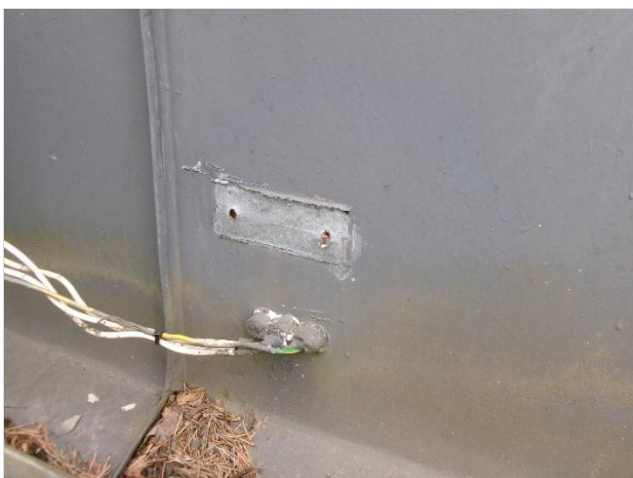
Kuva 66. Vesikatolla havaittiin vanhan kiinnikkeen reiät, jotka olivat korjaamatta.
