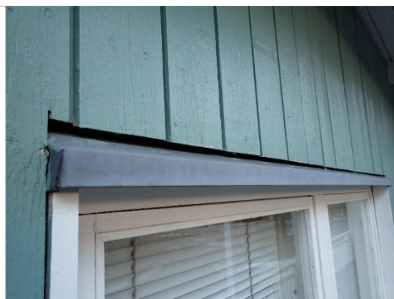
Kuva 29. Ikkunarakenteiden yläosissa oli pellitykset, jotka olivat hyväkuntoisia ja näyttivät johdattavan veden tarvittaessa pois päin ulkoseinärakenteesta.
