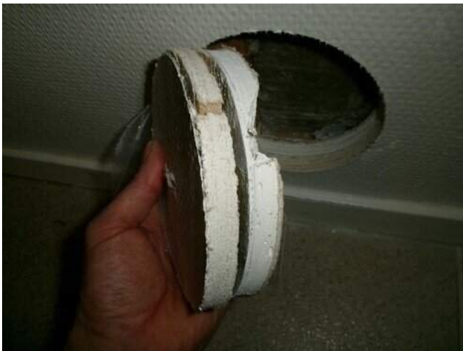
Kuva 1 Kipsilevyn pintaan liimattu puukuitulevy, jossa maalattu lasikuitutapetti.
