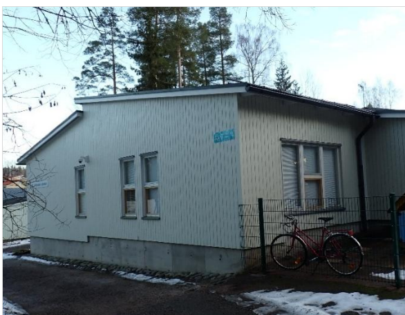
Kuva 30. Rakennuksen länsipäädyssä maanpinta oli noin 60 cm lattiapintaa alempana. Julkisivulaudoitus ja sen maalipinta oli havaintojen perusteella erinomaisessa kunnossa.
