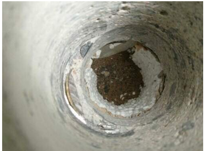
Kuva 49 Maa-aines lattian alla oli hiekka tiivistetyn soran sijaan. Hiekan havaittiin olevan huonosti tiivistynyt ensimmäisen 15 cm jälkeen.
