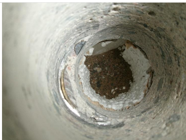
Kuva 21. Alapohjarakennetta tutkittiin timanttioralla tehdyistä rei'istä, kuvassa AP1 alapohja tilassa 106 pesuhuone RA25. Rakenneavauksessa havaittiin maatäytön olevan hiekkaa.
