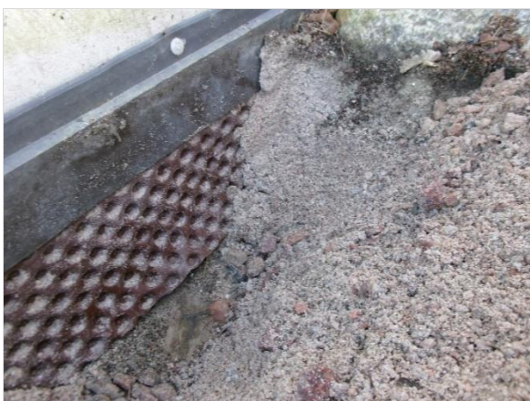
Kuva 7. Rakennuksen parkkipaikan puoleisessa päädyssä sokkelin patolevy ja reunalista on uusittu 2005 tehdyssä pihan perusparannuksessa.
