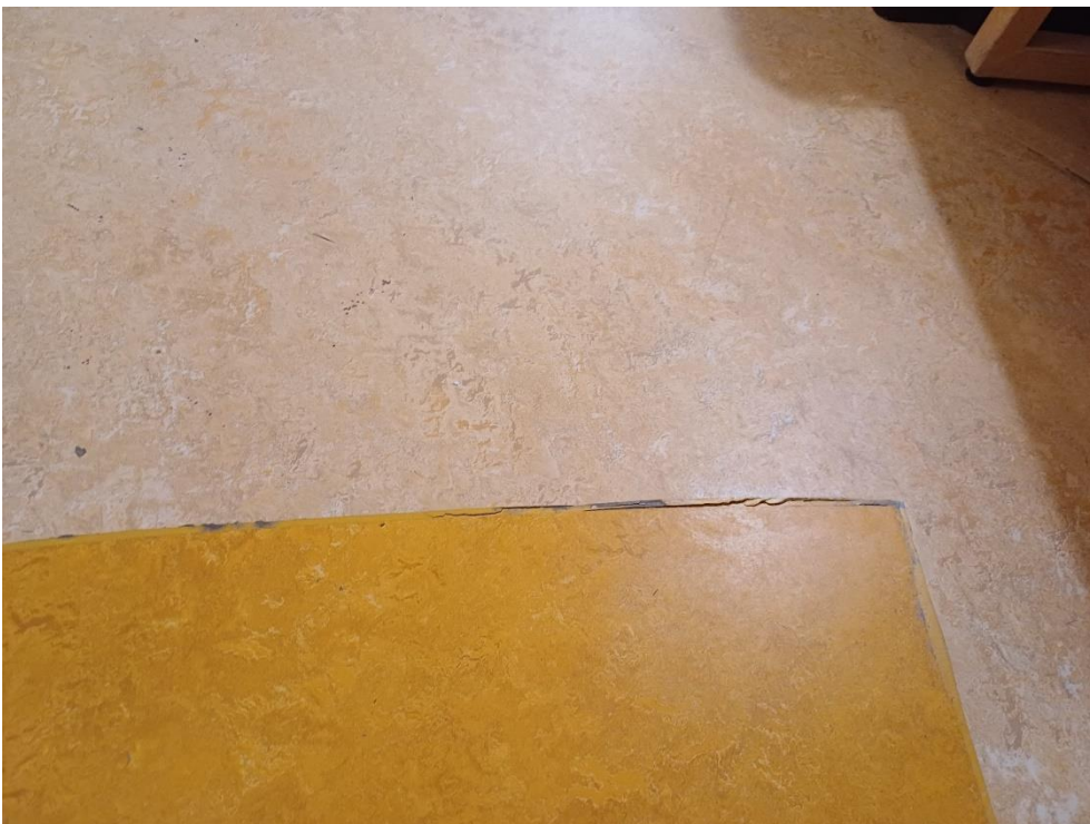
Kuva 4.12. 148 Leikkitila, lattiamaton hitsaussaumoja on ratkeillut auki.
