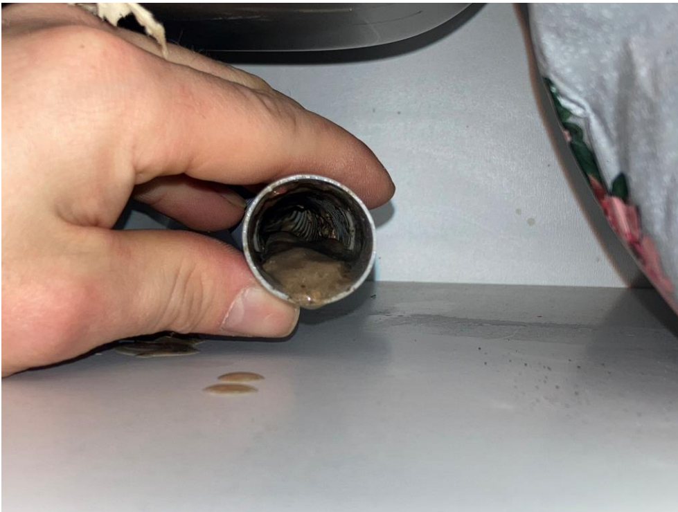
Kuva 5.1. Ryhmähuoneiden pesualtaiden ylivuotoputkistosta pääsee tilaan tunkkaista maakellarintapaista hajua.
