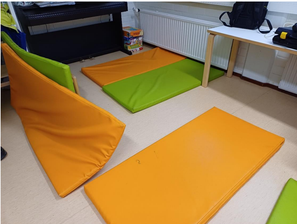
Kuva 4.4. 124/125 Toimisto/Toimenpidehuone, tilassa on käytössä useita vinyylipintaisia patjoja, joista irtoaa voimakasta hajua, mikä saattaa heikentää sisäilman laatua.
