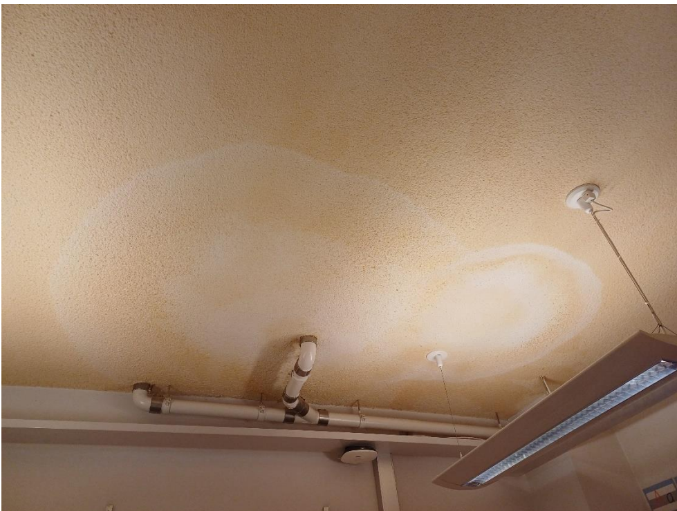
Kuva 4.7. A114 Luokka, alakaton pinnoitteessa on värimuutoksia.
