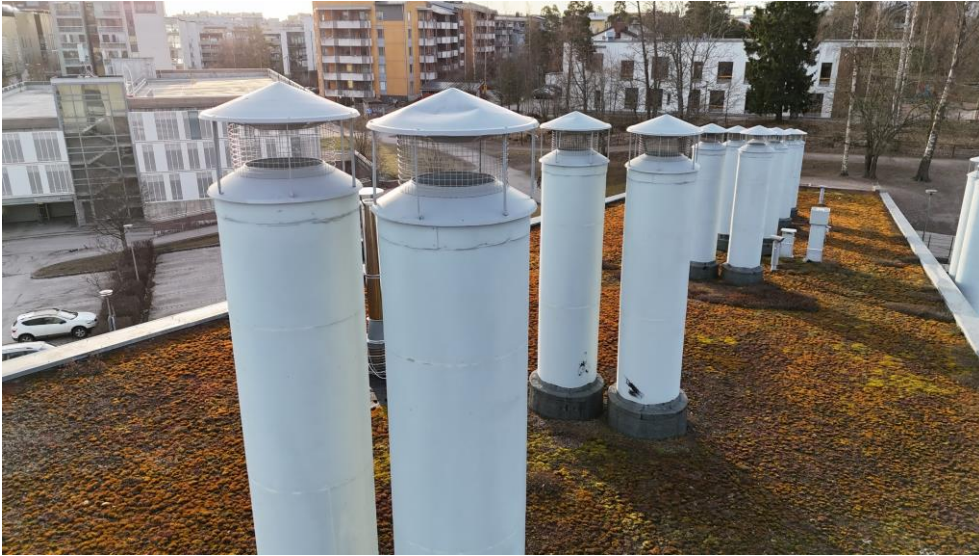
Kuva 5.1. Piiput katolla toimivat painovoimaisen ilmanvaihdon poistoilmahormeina.
