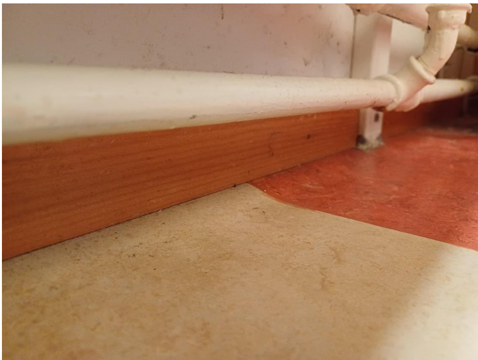
Kuva 4.8. A-osan lattiat 1krs. alueella ovat painuneet alaspäin.
