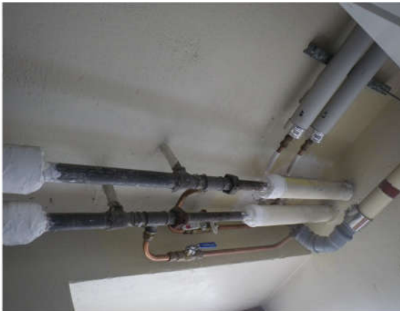
Lämpö-, vesijohto- ja viemäriasennuksia.
