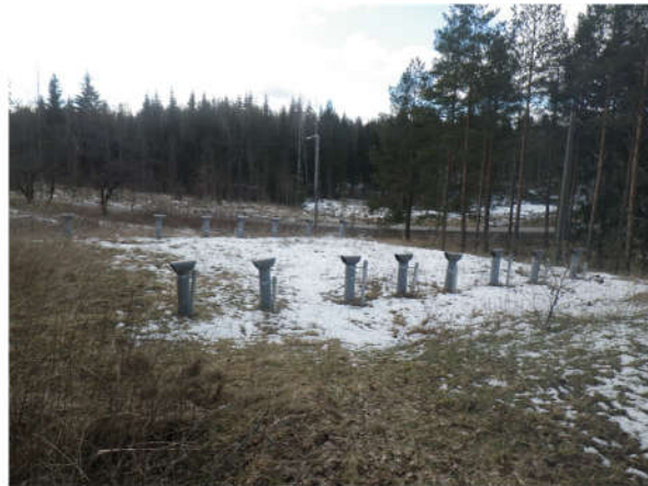
Imeytyskentän tuuletusputkia.
