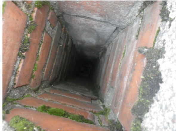
Tiilestä muurattua hormia katolta nähtynä.
