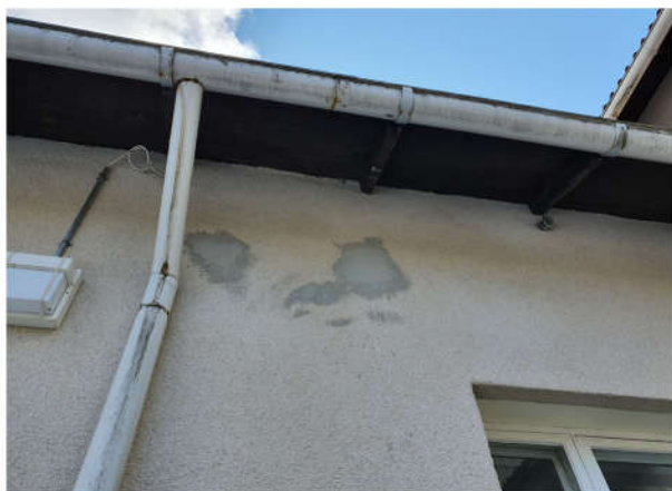
Paikkaukorjauksia on tehty.
