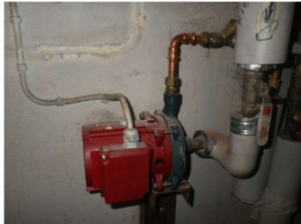
LKV-kiertovesipumppu.
