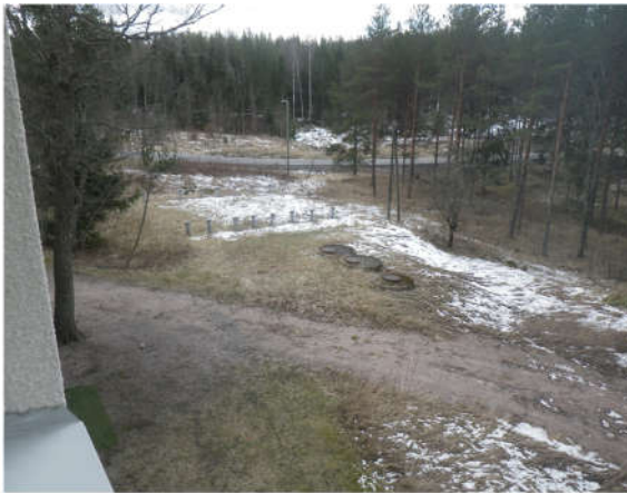
Kolme sakokaivoa ja imeytyskenttä.
