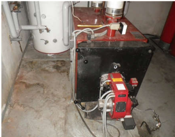
Kiinteistön öljylämmityskattila.
