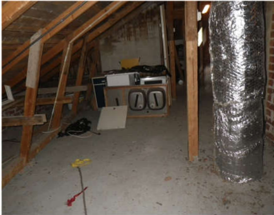
Kanavien eristykset olivat kunnossa.
