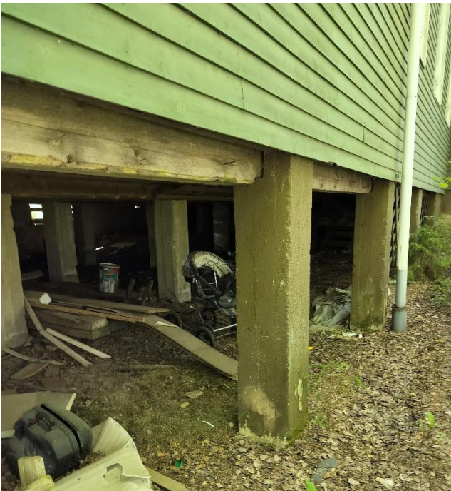
Kuva 15. Nuorisonseurantalons tuulettuva alapohja.
