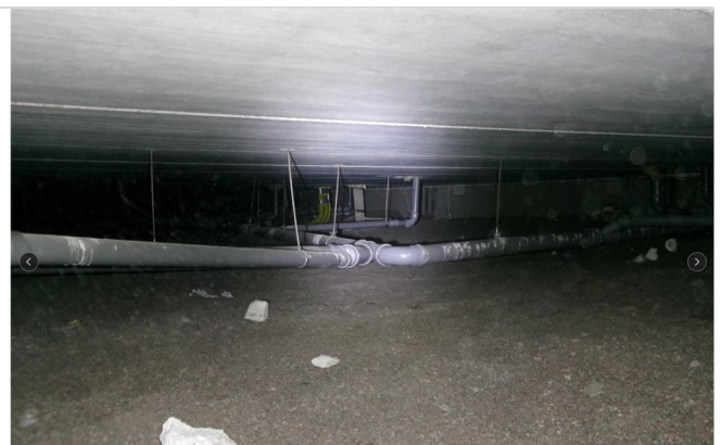
Kuva 17. Alapohjan RA5 rakenneavaus tehtiin EPS-eristekerrokseen asti. Rakennekerrokset olivat kuivat eikä niissä todettu kosteuden aiheuttamia jälkiä tai värjäytymiä. EPS-eristeessä (näyte M6) ei todettu myöskään mikrobikasvustoa.
