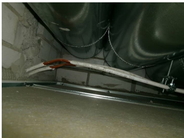
Kuva 54. Yleiskuva alakattojen yläpuolisesta tilasta muurattuihin väliseiniin.
