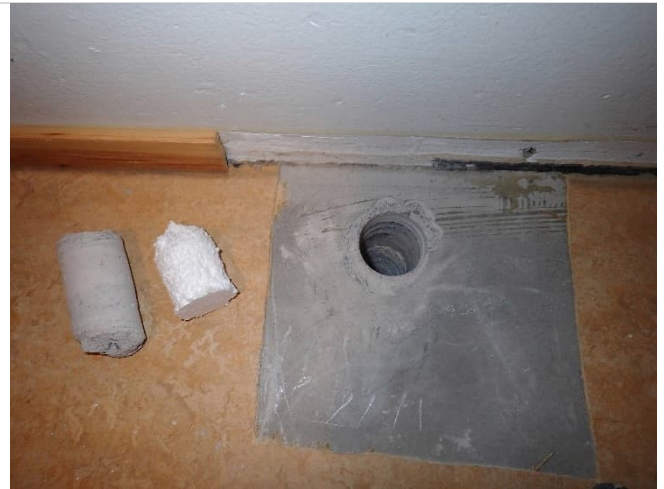
Kuva 17. Alapohjan RA5 rakenneavaus tehtiin EPS-eristekerrokseen asti. Rakennekerrokset olivat kuivat eikä niissä todettu kosteuden aiheuttamia jälkiä tai värjäytymiä. EPS-eristeessä (näyte M6) ei todettu myöskään mikrobikasvustoa.
