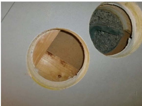
Kuva 63. RA4 avauksessa ei havaittu poikkeavuutta.
