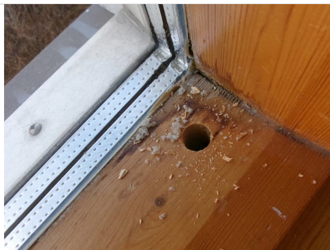
Kuva 49. Ikkunoiden tilkevälin eristeenä on käytetty polyuretaania.
