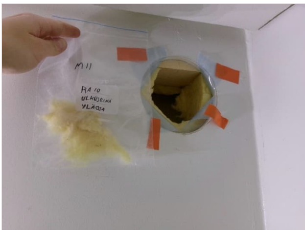
Kuva 48. RA10 kohdalla näkyvissä ulkoseinän yläjuoksu.
