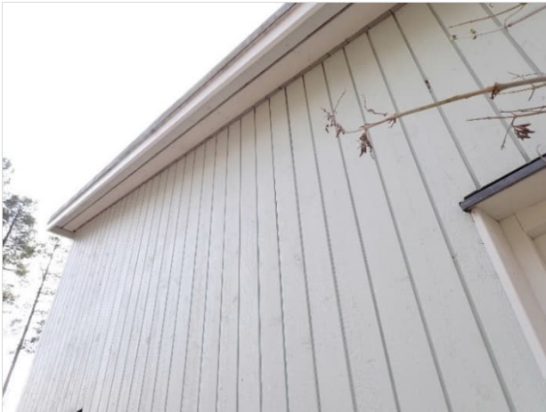
Kuva 32. Rakennuksen päädyissä on lyhyet räystäät. Julkisivun pinta on hyvässä kunnossa.
