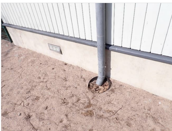
Kuva 9. Ryhmähuone 04 ulkopuolella sokkeliä vasten on mukulakiveyskaista, jonka jälkeen alkaa hiekka alue. Mukulakiveyksen päällä on runsaasti hiekkaa.
