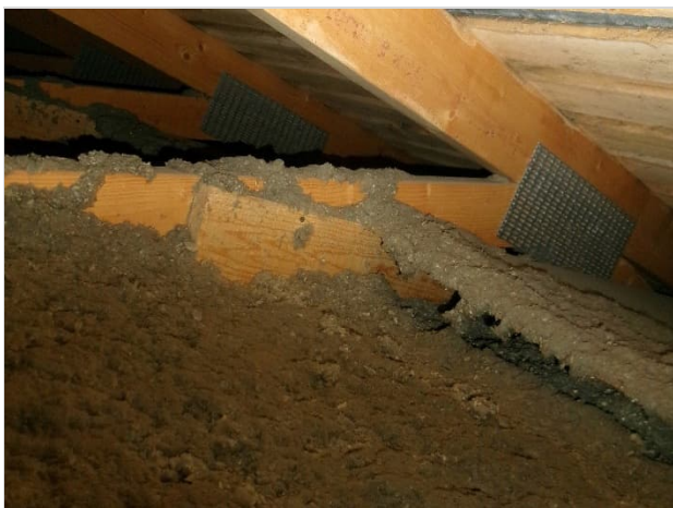
Kuva 65. Puuosissa ei havaittu poikkeamia ja yläpohjaan on asennettu tuulenojaimet räystäälle.
