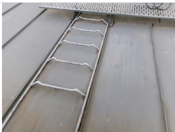
Kuva 80. Kattotikkaat ovat peltiä vasten.
