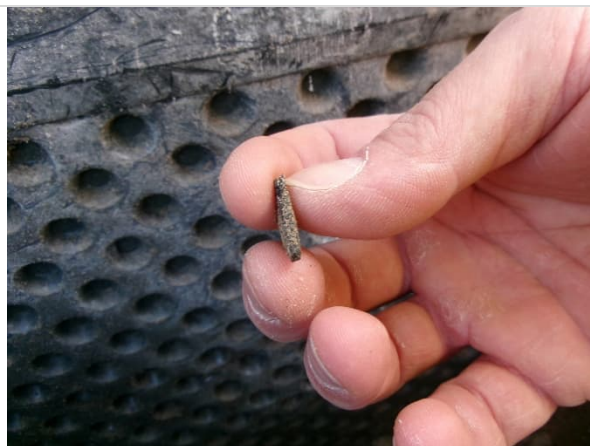
Kuva 6. Bitumisively irtosi helposti sokkelin pinnasta.
