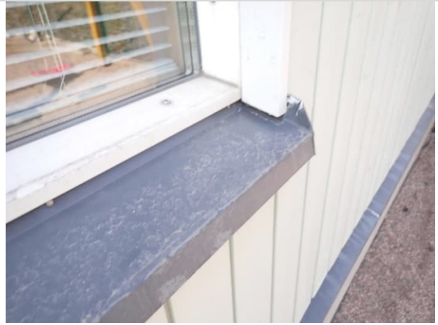
Kuva 31. Ikkunoiden vesipeltien kaadot ovat riittävät.
