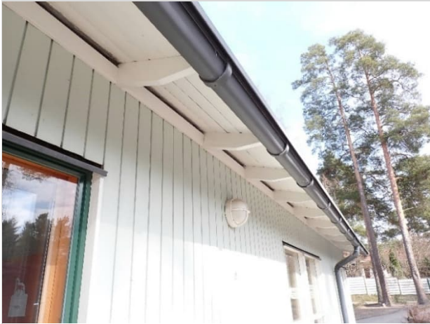
Kuva 30. Julkisivu- ja räystäslautojen maalipinta on hyvässä kunnossa.
