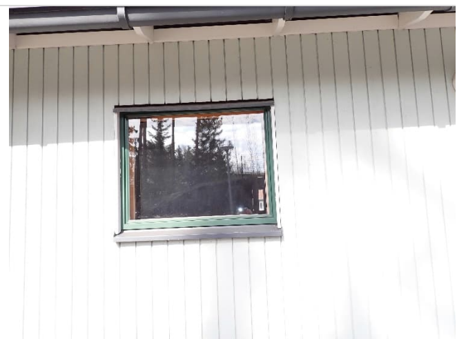
Kuva 29. Ikkunoiden karmit ovat ulkopuolelta hyvässä kunnossa.
