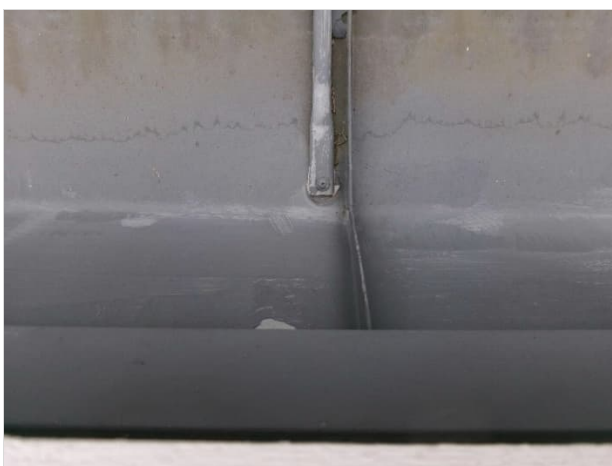
Kuva 81. Kattotikkaat ovat yläpäästä ruuvattu peltikatteen läpi.
