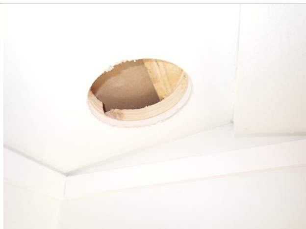
Kuva 66. RA8 tehtiin lämpökuvauksessa havaitun ilmavuodon kohtaan.
