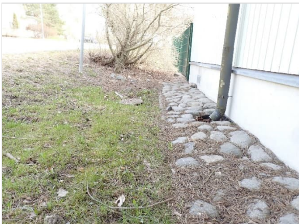
Kuva 11. Rakennuksen koillisnurkalla nurmialue viettää rakennusta kohti.
