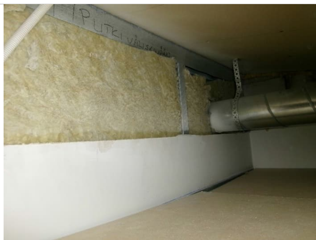
Kuva 55. Osassa metallirankaisista väliseinistä oli mineraalivillapinta näkyvissä alakattotason yläpuolella.
