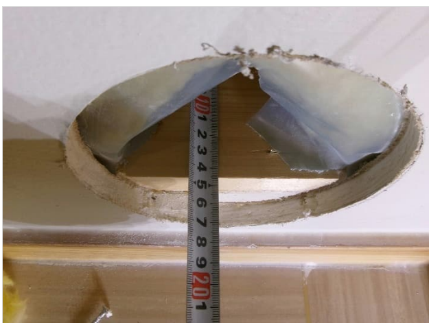
Kuva 46. Ulkoseinän runko on mitallistettua 145 x 45 mm puutavaraa
