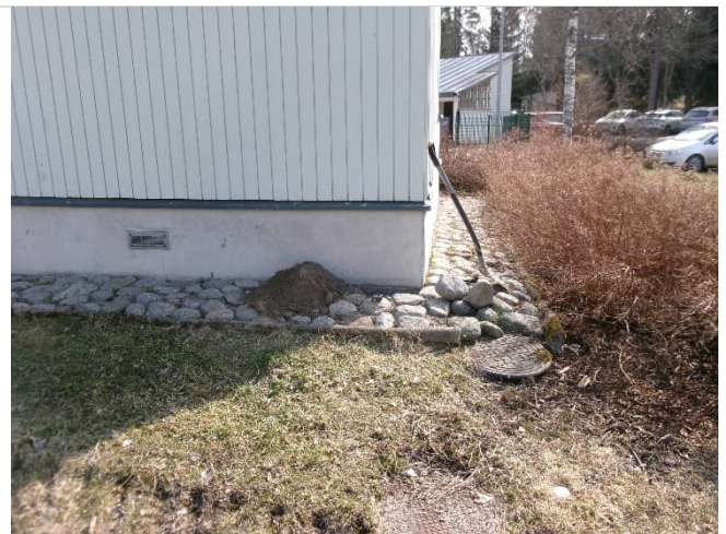
Kuva 4. Ryhmähuone 06 ulkonurkkaan kaivettiin koekuoppa 2.
