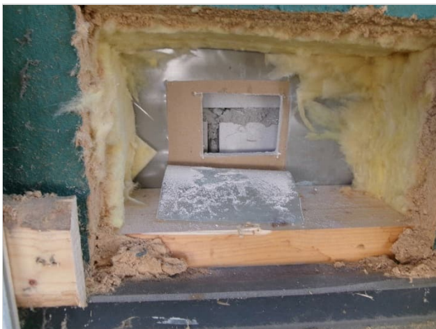
Kuva 42. RA16 pesuhuoneen 015 kohdalla rakennekerrosten yleiskuva.
