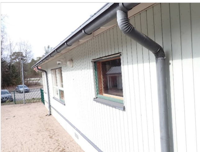
Kuva 28. Mukulakiveys sokkelin vieressä on hiekan peittämä.
