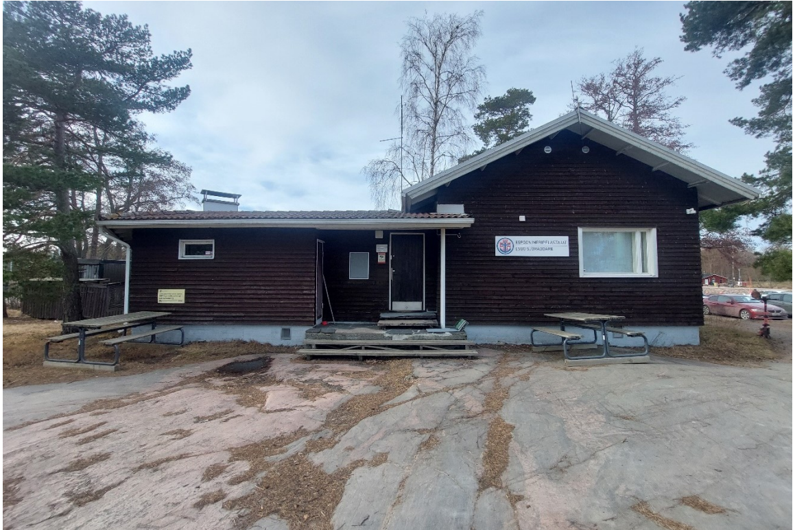
Kuva: Meripelastajien nykyinen asemarakennus. Rakennus jää kaava-alueen ulkopuolelle.
