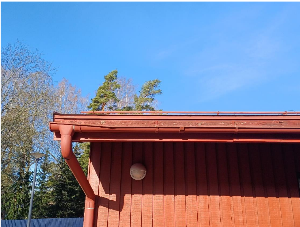
Kuva 4.7. Sadevesikouruissa on painaumia, mikä saattaa heikentää veden virtausta sadevesisyöksyihin.
