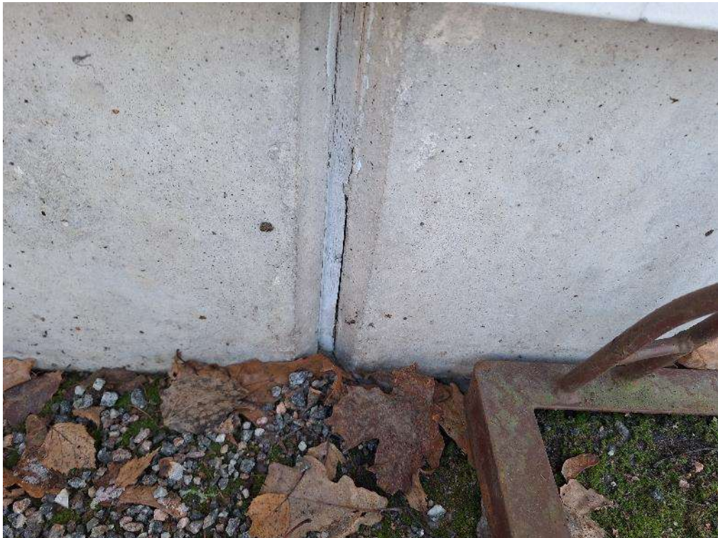
Kuva 7. Sokkelin saumamassassa (näyte 6) ei havaittu lyijyä eikä PCB-pitoisuuksia.
