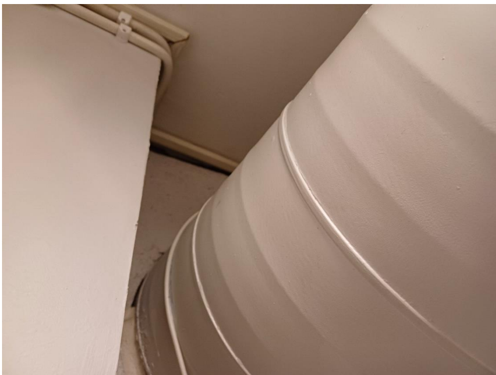
Kuva 4.9. 148 Varasto, rakenneliittymiä avoinna.
