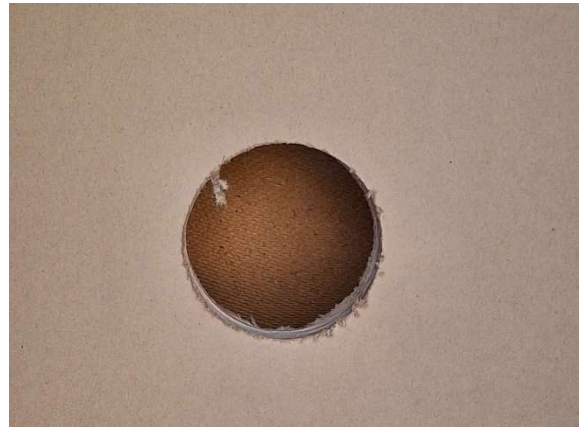
Kuva 40 Yläpohjan avaus alapohjatilassa.
