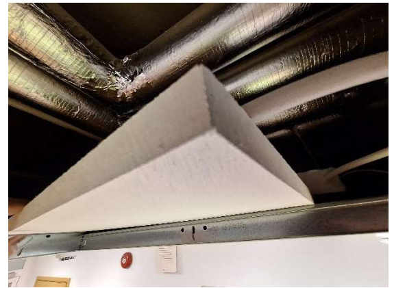
Kuva 42 Äänenvaimennuslevyjen reunat on käsitelty.
