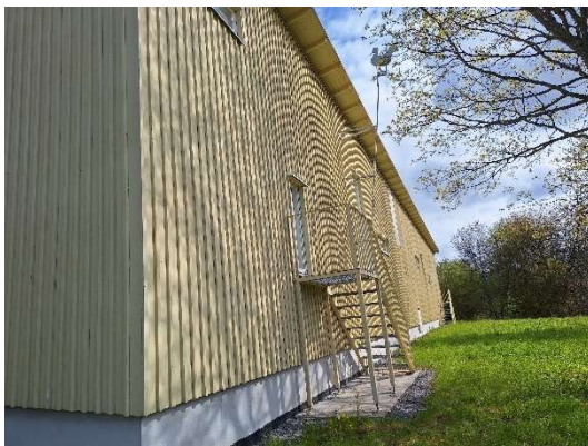
Kuva 4 Yleiskuva kohteen julkisivusta.
