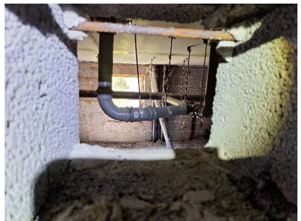
Kuva 19 Kulkuluukku alapohjatilasta päin kuvattuna.
