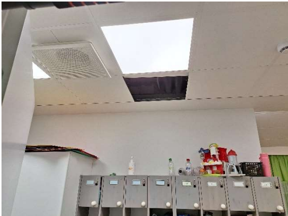
Kuva 39 Yläpohjan avaus eteistilan 03 puolella.
