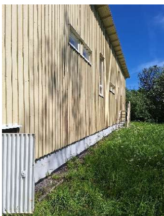
Kuva 18 Kulkuluukku alapohjatilaan rakennuksen takapuolella.
