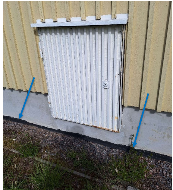
Kuva 30 Perusmuurilevyn ylälistä näkyvissä rakennuksen takapuolella, alapohjajalan oviaukon kohdalla.
