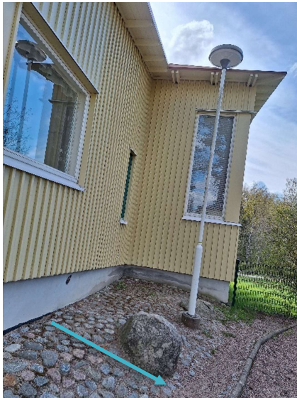
Kuva 6 Rakennuksen lounaispuolella maanpinta kaataa selvästi pois päin. Sokkelin vierustoilla on kiveys.
