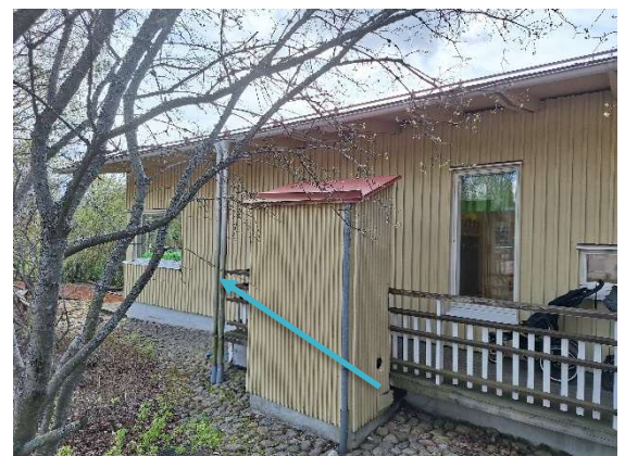
Kuva 13 Kattovedet on johdettu etupihan puolella ränniä ja syöksyputkia pitkin sadevesijärjestelmään terassin kulmilla.
