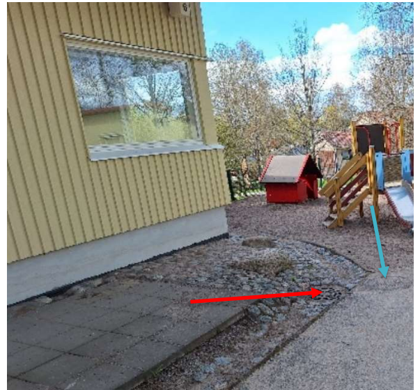
Kuva 7 Rakennuksen luoteiskulma sisäpihalla, jossa on näkyvissä pintavesikaivo (punainen nuoli) sekä mahdollinen salaojan tarkastuskaivo (sininen nuoli) asfaltilla.
