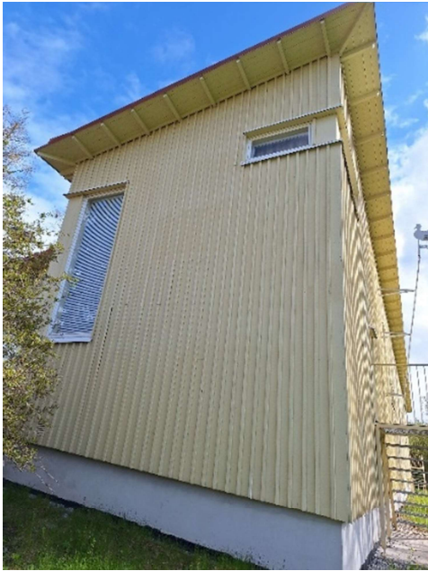
Kuva 29 Rakennuksen lounaispäädyn sokkeli on riittävän korkealla maanpinnasta.
