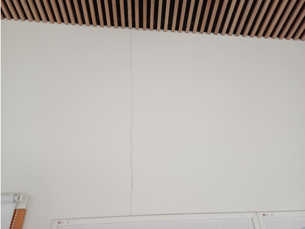
Kuva 4.1. 213 Lepohuone, seinähalkeama.
