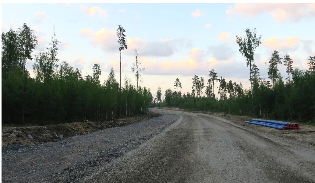
Kuva 13. Rakenteilla oleva katu Lambertin osa-alueella 4.
