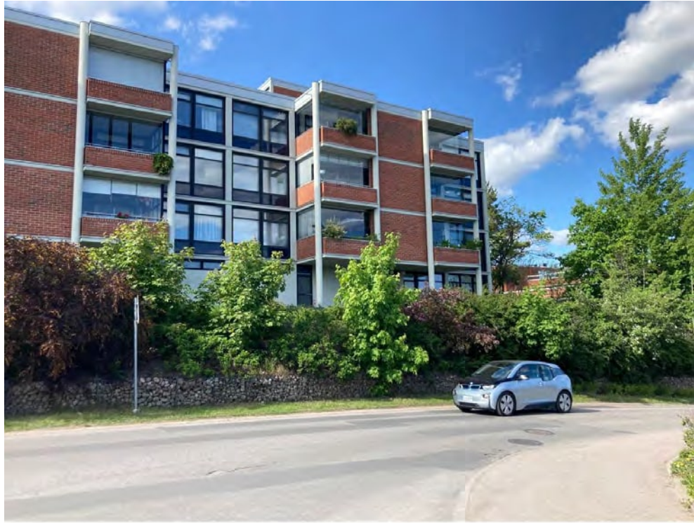
VALOKUVA 2. LÄNSIPUOLEN NAAPURIRAKENNUS KOMETANKADUN SUUNNASTA.
