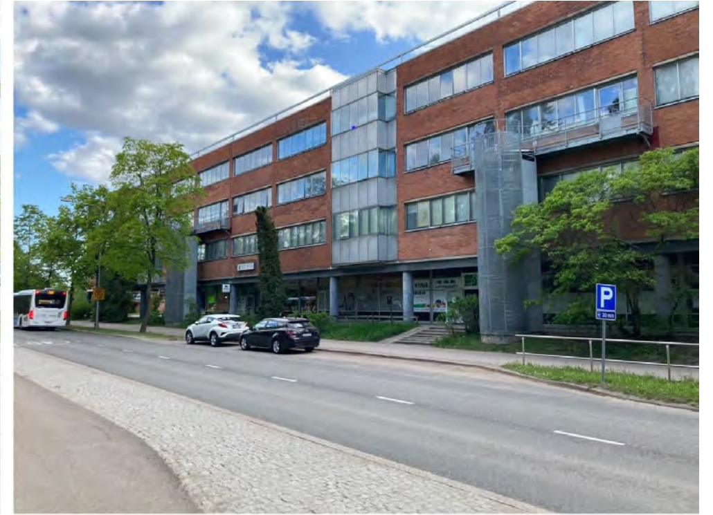
VALOKUVA 4. NYKYINEN RAKENNUS OLARINKADUN SUUNNASTA.
