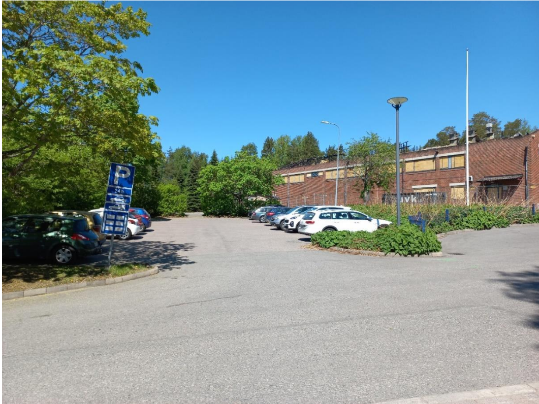
Kuva: Laurinlahden koulu ja pysäköintialue. Koulu on purettu tuhopolton jälkeen.
