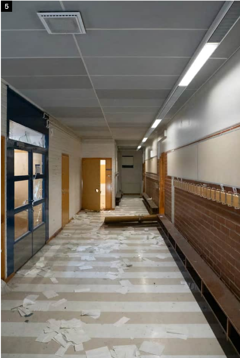
↑ Toisen kerroksen käytävä ja sisäpihalle aukeavan tuulikaapin ovi.
