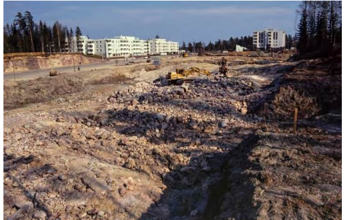
↑ Espoonlahden Lippulaivan rakennustyömaa valokuvattuna vuonna 1991. Eero Laamanen, KAMU Espoon kaupunginmuseo.
