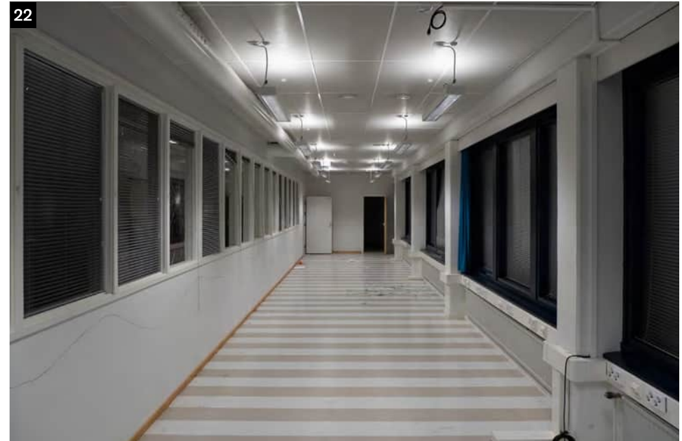
↑ Kirjaston ulkoseinällä on koulun muita tiloja korkeammat ikkunat, jotka olivat alun perin osa sisäpihan suuntaan aukeavaa tilavaa aulaa.
