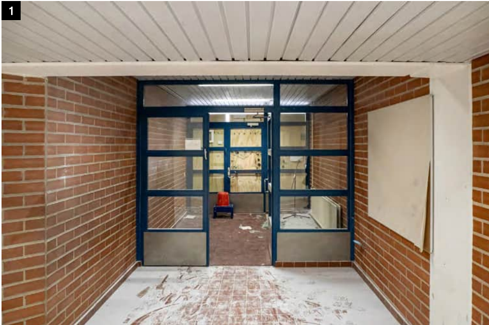
↑ Koulun tuulikaapeissa toistuvat tummansiniseksi maalatut teräslasiovet.
