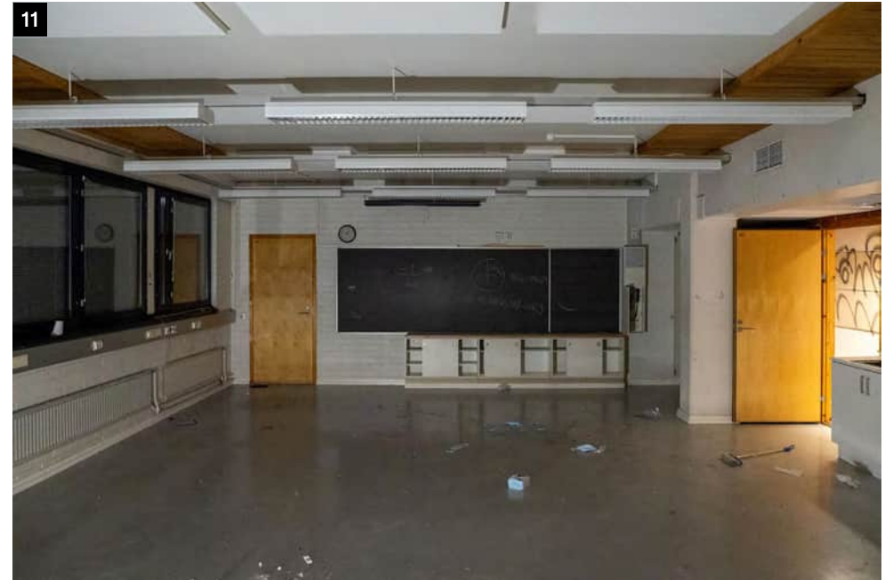
↑ Ensimmäisen kerroksen luokahuoneiden pintamateriaalit ja kiintokalusteet on pääasiassa uusittu.
