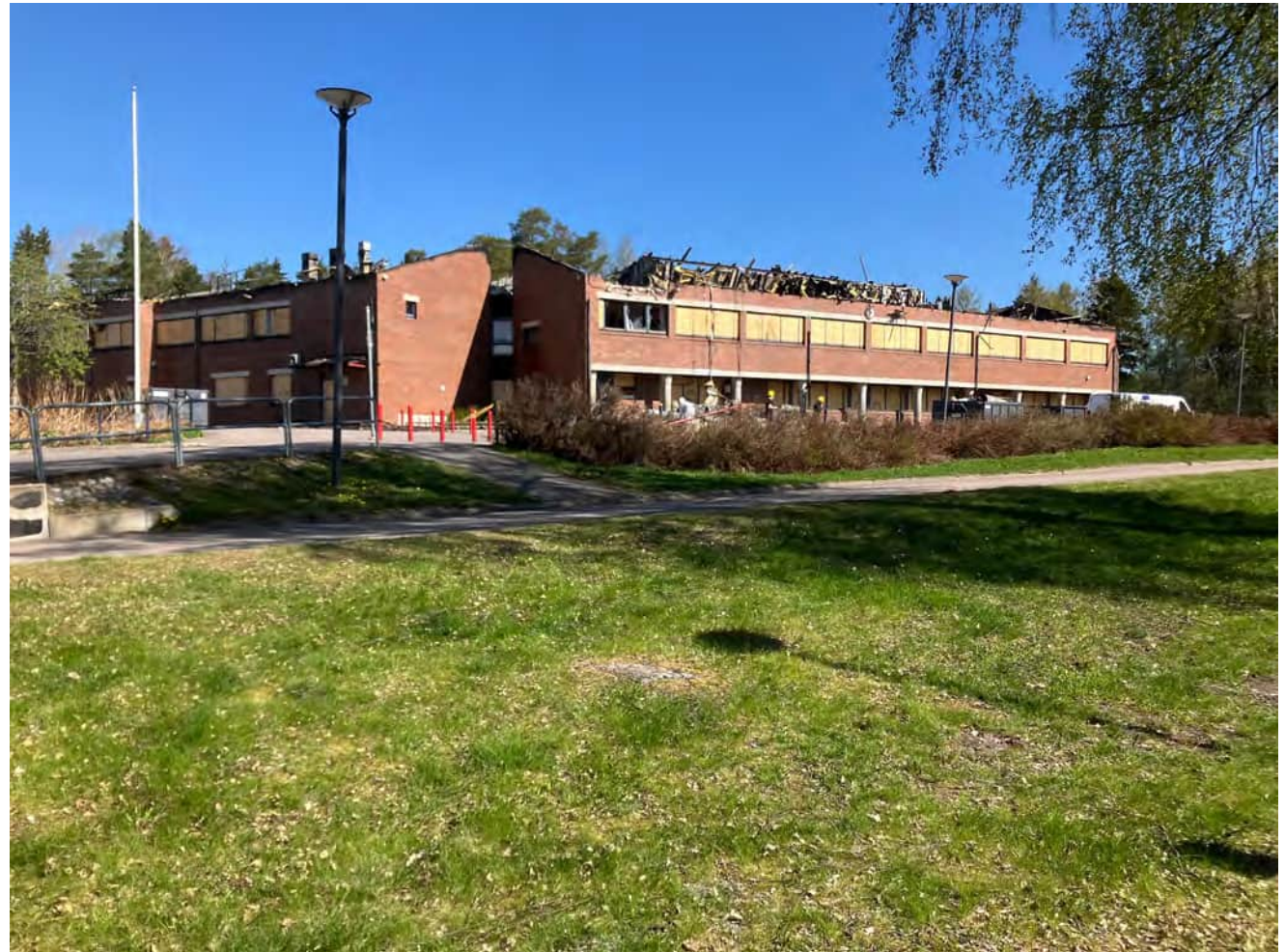
↑ Laurinlahden koulun kattorakenteet tuhoutuivat tuhopoltossa toukokuussa 2024. Kuva Juha Iivanainen, 2024.
