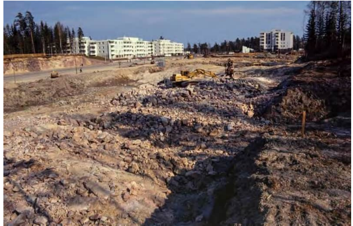
↑ Espoonlahden Lippulaivan rakennustyömaa valokuvattuna vuonna 1991. Eero Laamanen, KAMU.
