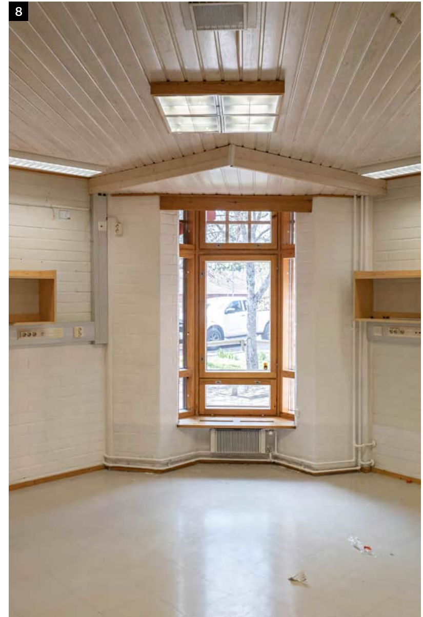
↑ Rakennusmassojen taitekohdassa on sisäpihoja kohti avautuvat erkkerit, joissa on alkupe- räiset istumatasoina toimivat patterinsuojukset. Alakaton kolmion malliset koteloinnit ovat peräisin myöhemmistä muutosvaiheista.
