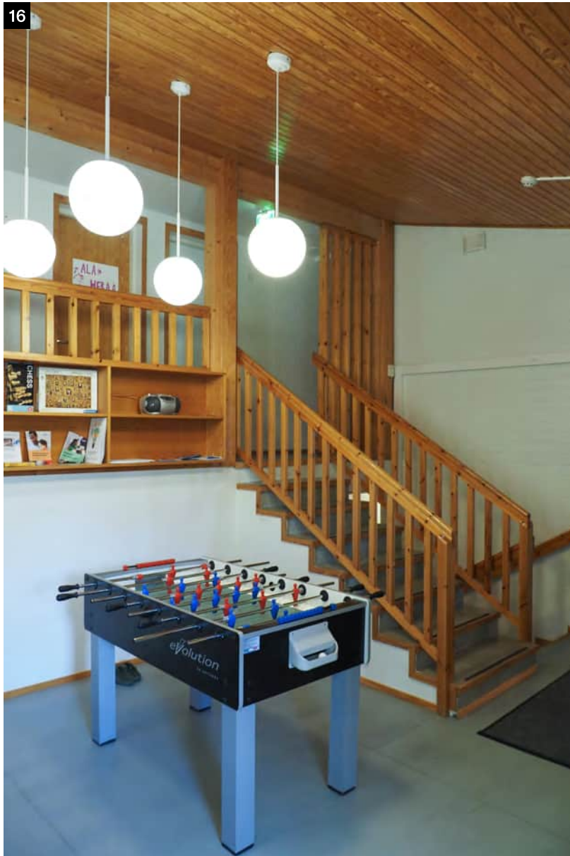
↑ Asuntolan parvessa ja portaassa on alkuperäiset puurakenteiset kaiteet.
