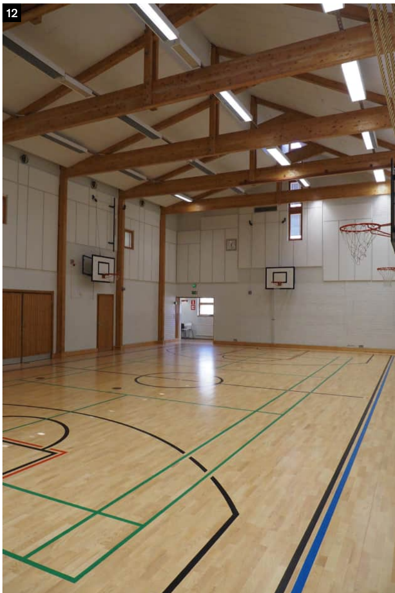
↑ Liikuntasalissa on murrettu harjakatto ja puupilareiden kannattelema puurakenteinen kattoristikko. Harjan alkuperäinen pitkä kattoikkuna on ummistettu kattoremontin yhteydessä.
