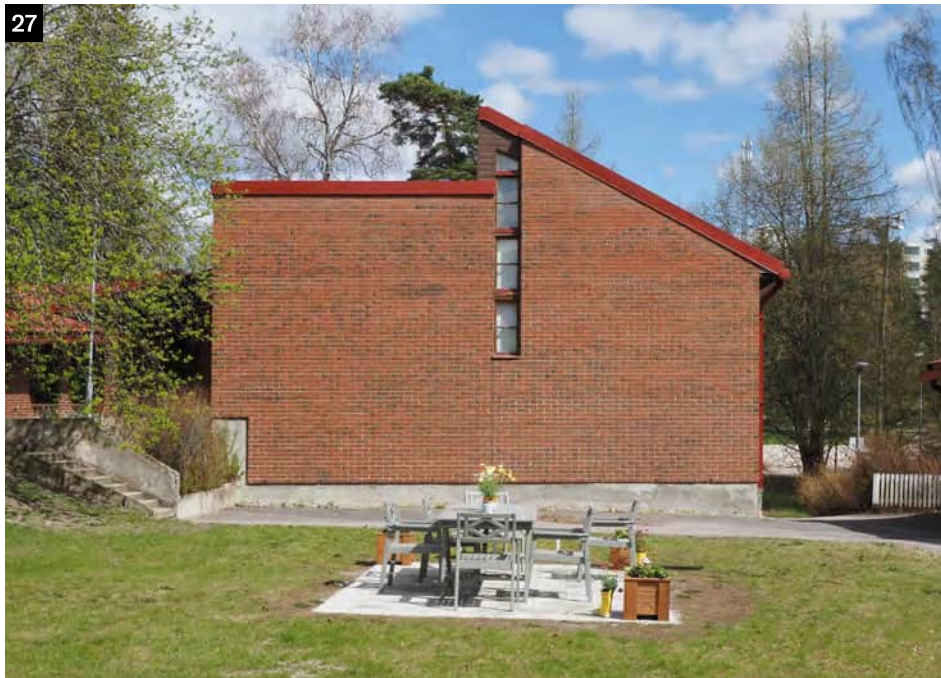
↑ Koulurakennuksen liikuntasalisiivissä on muista siivistä poiketen murettu harjakatto. Kaikkien rakennusten päätyjulkisivut ovat muurimaisen umpinaisia ja aukotus on vähäeleistä.
