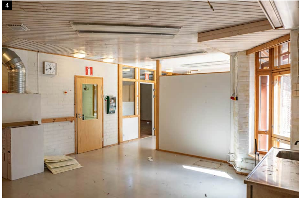
↑ Koulun teknisen työn tilat on sijoitettu rakennuksen luoteiskulmaan suurehkon aulamaisen tilan ympärille. Aulamaista tilaa on jäsennetty kuvassa näkyvällä myöhemmällä kevyellä väliseinällä.
