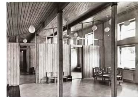
↑ Talman päiväkodissa on paljon yhtäläisyyksiä Merisaappaan koulun kanssa niin massoitellussa, materiaalipaletissa kuin sisätiloissakin. Rakennus on purettu. Kuvat Kirstin Nordinin arkistosta.
