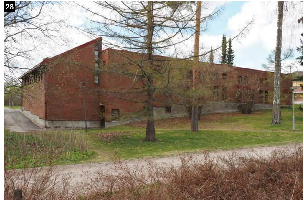
↑ Koulurakennuksen urheilukentän puoleinen itäjulkisivu ja liikuntasalisiiven eteläseinusta ovat luonteeltaan suljettuja.
