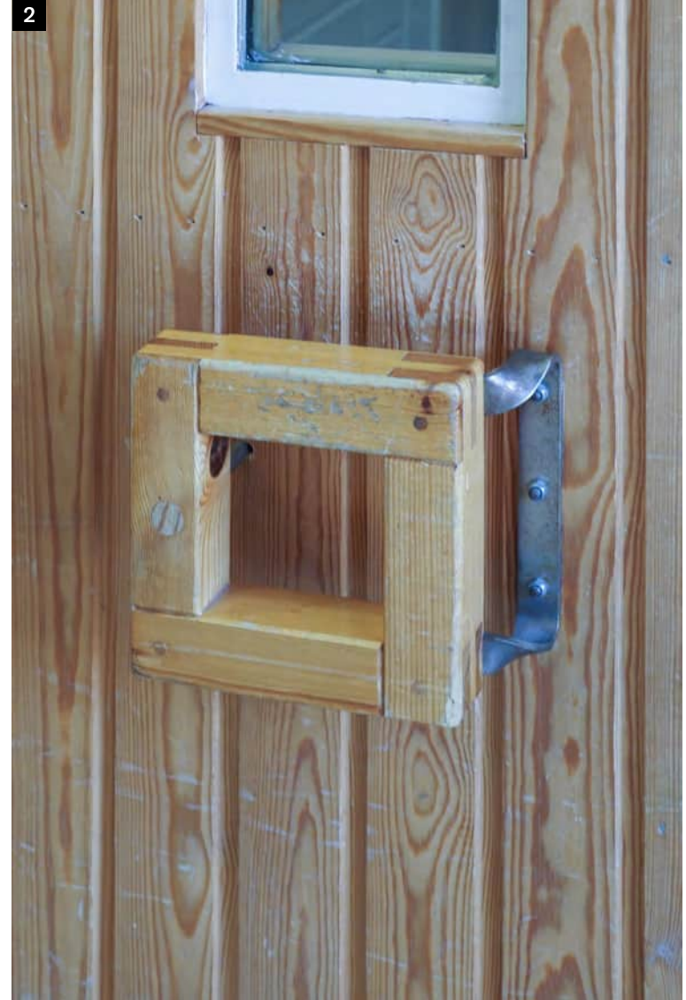
↑ Rakennuksen arkkitehtuuri on säilynyt yksityiskohtineen hyvin alkuperäisen kaltaisena. Esimerkiksi tuulikaappien sisäovet ovat alkuperäisiä pystypaneloituja puuovia, joissa neliön muotoiset puuvetimet sekä kapeat ikkuna-aukot.
