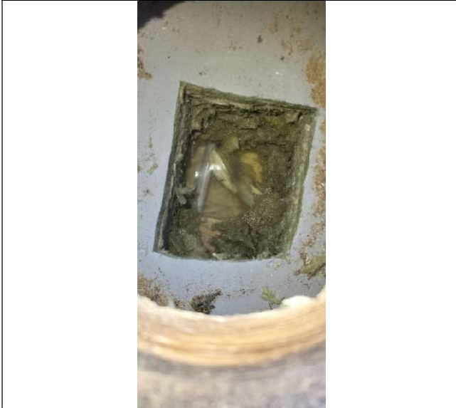
Yleiskuva rakenneavauskohdasta RA15.
