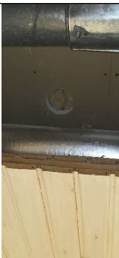
Yleiskuva rakenneavauskohdasta RA13.
