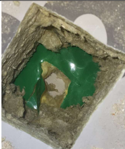
Yleiskuva rakenneavauskohdasta RA14.
