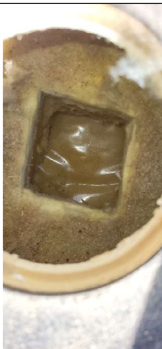
Yleiskuva rakenneavauskohdasta RA12.
