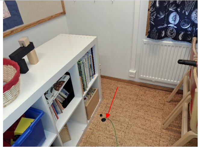
Kuva 12. Leikkitila 156 valittiin merkkiainekokeeseen (MA1), koska tilassa ei ollut seinille nostettua muovimattoja. Merkkiaine ei kulkeutunut alapohjan rakenneliittymistä sisäilmaan.
