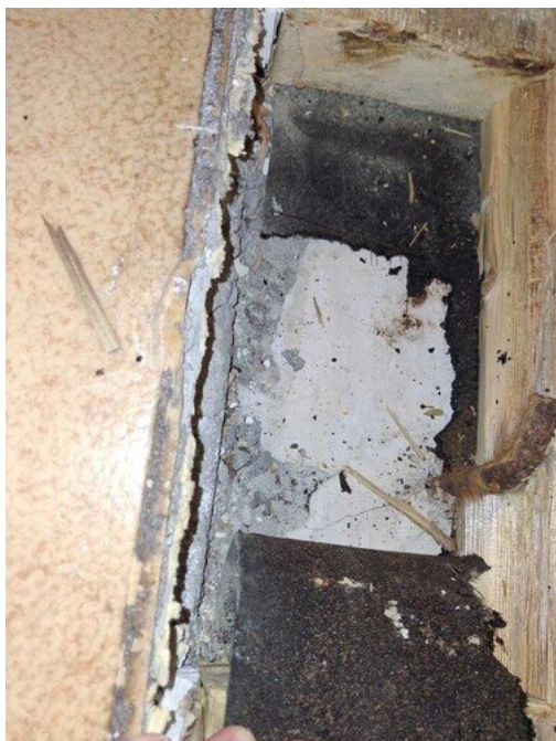
Kuva 49 Toisella puolella käytävää ei havaittu vaurioita.
