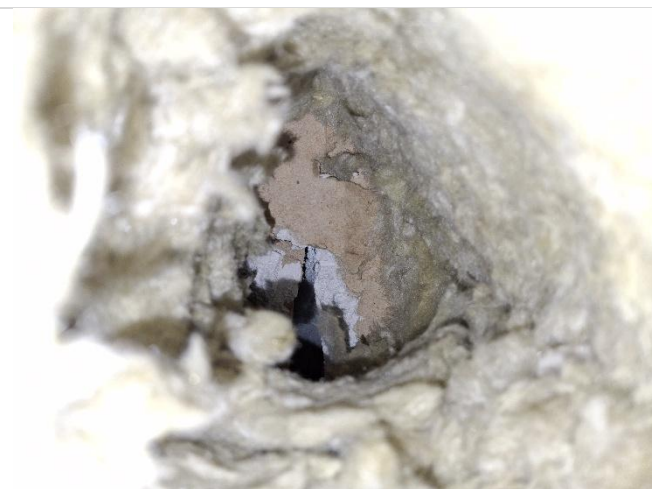
Kuva 32. Tuulensuojalevyn takana ei havaittu ilmarakoa. Kuvasa sosiaalitalan ulkoseinän yläosaan tehty rakenneavaus RA3. Lämmöneristeen sisäpinnasta kerätyssä materiaalinäytteessä MA3 havaittiin mikrobikasvua.
