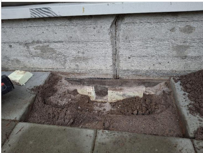
Kuva 5. Sokkelin viereen kaivettiin kuoppa, jonka kautta tarkastettiin sokkelin routa- ja vedeneristykset.
