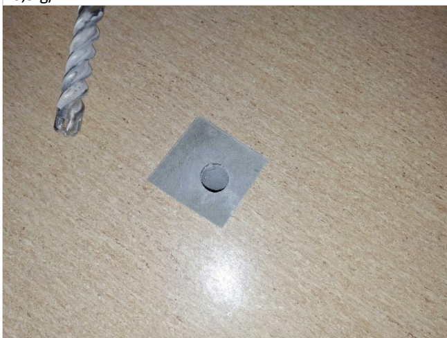
Kuva 27. Alapohjarakennetta tutkittiin porareikien kautta. Lattialaatta oli jokaisessa rakennetarkastuksessa vähintään 200 mm paksu. Laatan alla oli muovi ja kevytsorakerros.
