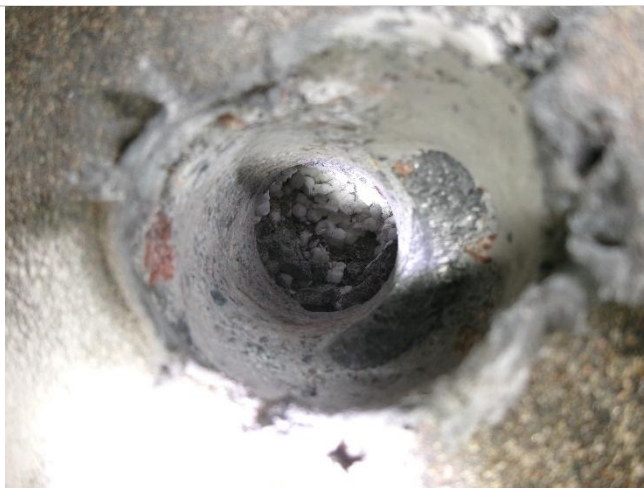
Kuva 6. Sokkeli on noin 60 mm paksua teräsbetonia ja sokkelihalkaisussa on 50-70 mm EPS lämmöneristeenä.
