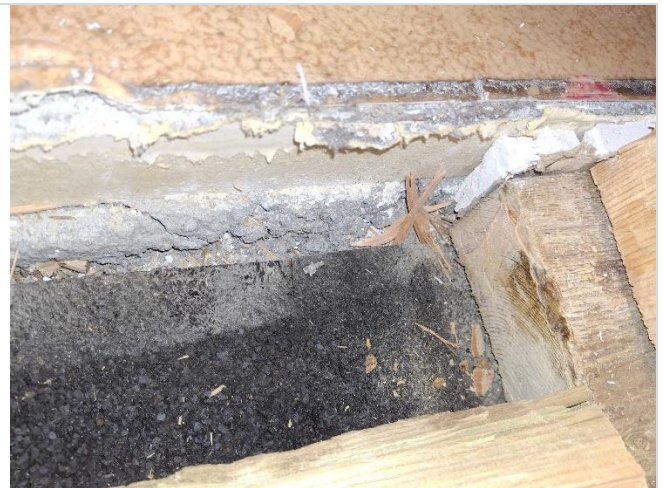
Kuva 38. Väliseinien alaohjauspuiden alle on asennettu huopakastaale. Alaohjauspuu on noin 60 mm lattiapinnan alapuolella. Kipsilevy on asennettu betonilaattaa vasten.
