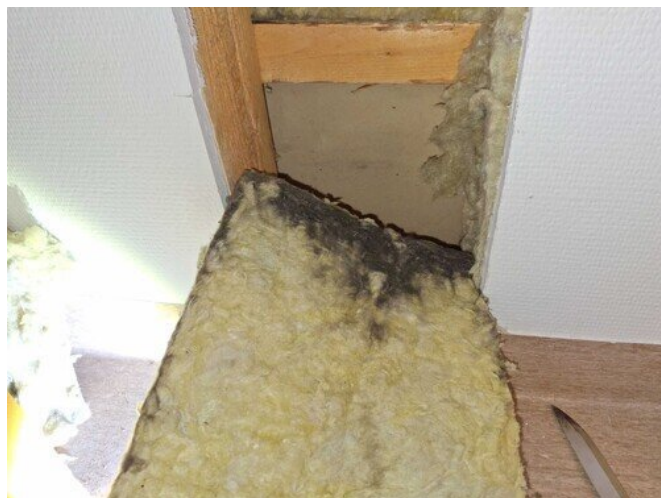
Kuva 4 RA1 kohdalla eristevillojen alaosa oli voimakkaasti tummunut.
