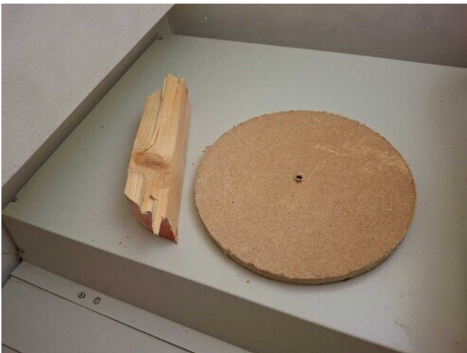
Kuva 41 Puukuitulevyn takapinta ja puurakenteet olivat puhtaita.
