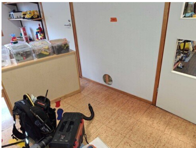
Kuva 45 RA8 tehtiin väliseinään wc-tilan ja märkätilan kohdalle.
