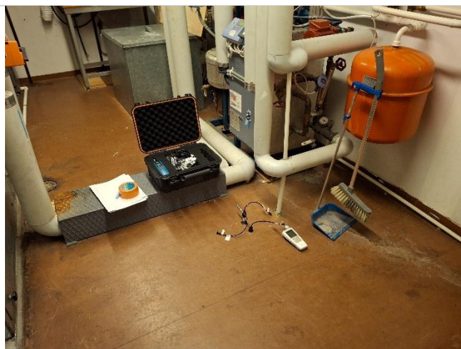
Kuva 26. Lämmönjakohuoneeseen 127 tehtiin kontrolloiva porareikämittaus PR1, alapohjalaatan suhteellinen kosteus oli normaali 71,3-73,0 %, 23,6 °C, 15,2-15,5 g/m³.
