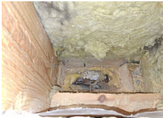
Kuva 2 Alaohjauspuu sijaitsee noin 120 mm lattiapinnan alapuolella.
