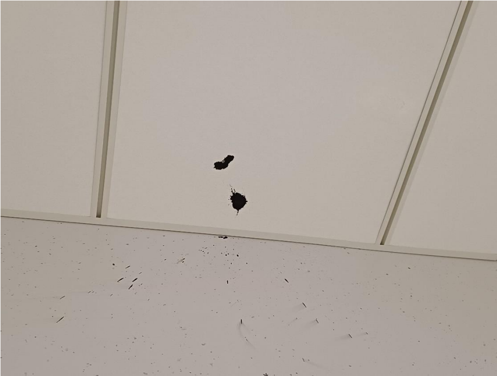
Kuva 4.10. 146 alakaton akustointilevy on likaantunut.
