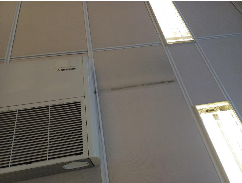
Kuva 4.9. 109 alakaton akustointilevy on likaantunut.
