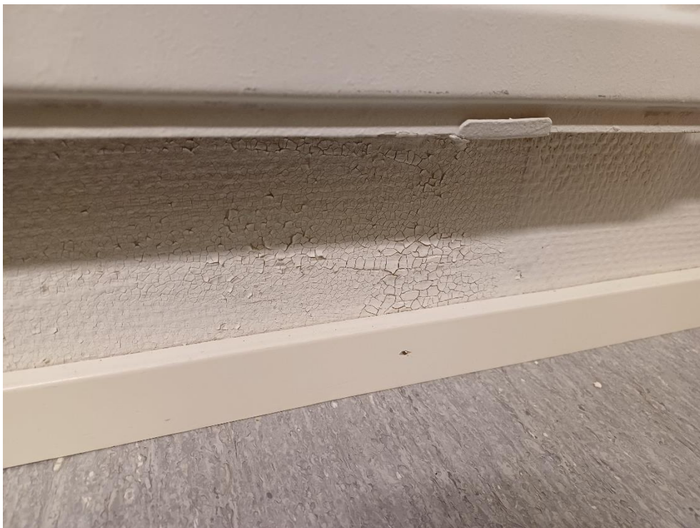
Kuva 4.2. C206 psykologi, ulkoseinälevytyksessä on vanhoja kosteuden aiheuttamia jälkiä lämpöpatterin alapuolella.
