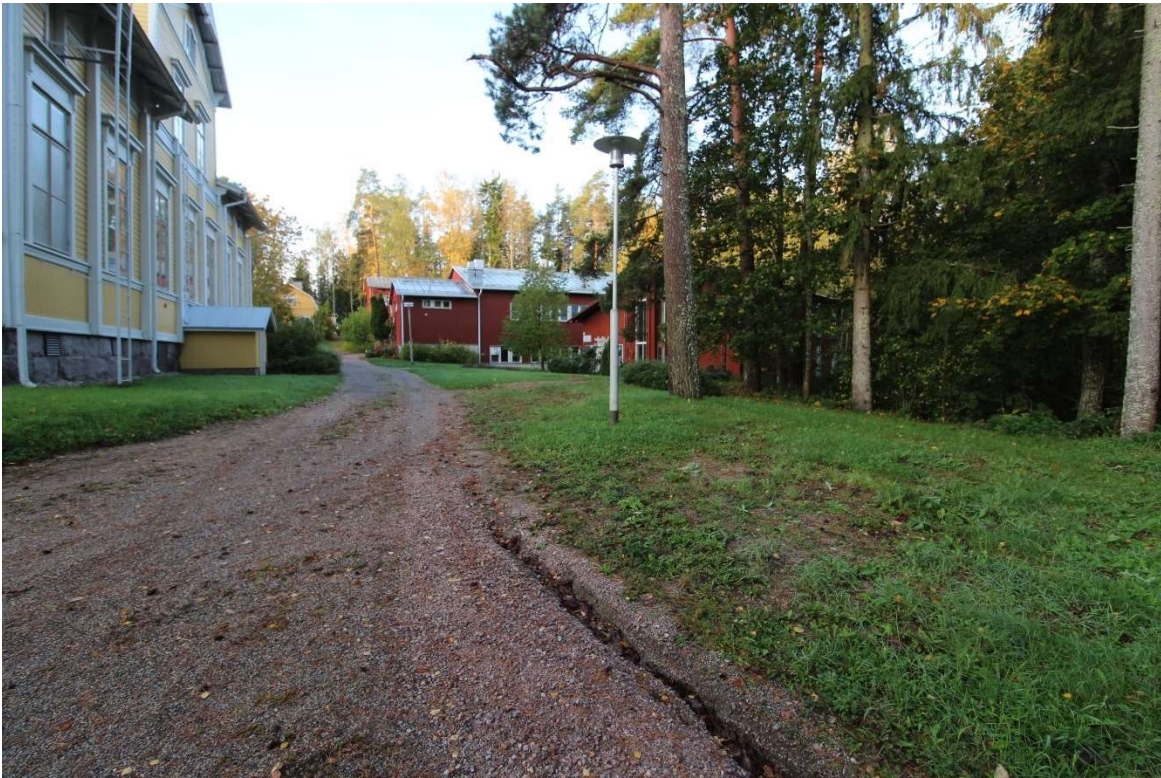
AKDG7352:18. Yleiskuva. Päärakennuksen luoteispuoli. Kuvattu koillisesta.
