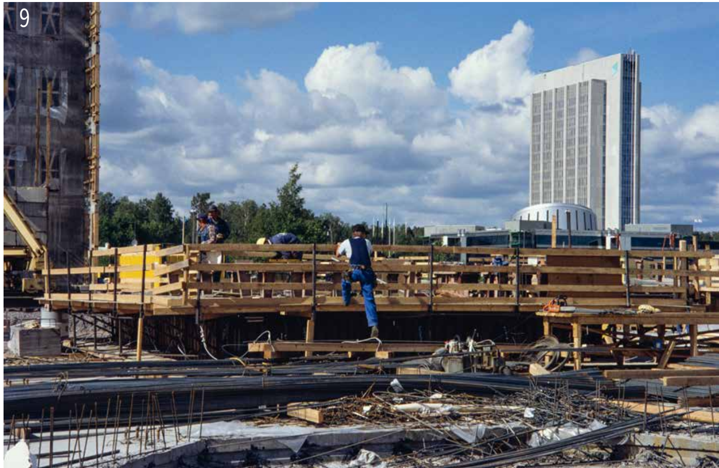
9 Nokian rakennustyöt Keilaniemessä, taustalla Nesteen pääkonttori. 1996 valmistunut Nokian pääkonttorin ensimmäinen vaihe Keilalahdessa ilmentää teknologiaboomin vaikutusta Espoon kaupunkirakenteeseen ja toimitilarakentamisen kasvuun. Kuva: Eero Laamanen 1995, KAMU Espoo.
