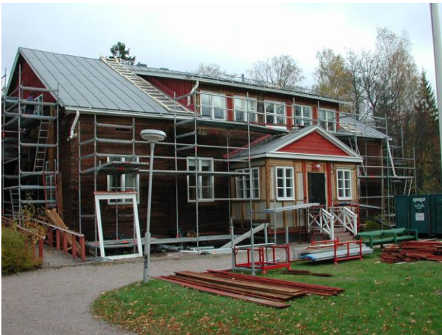
Kuva 38. Kestikievarin julkisivujen uusiminen vuonna 2003. Silloin havaittiin, että kuistin vieressä hirsiseinää oli jossain vaiheessa paikallisesti korjattu rankarakenteena. Paikkaus saattaa olla peräisin 1970-luvun tulipalon jälkeisistä korjaustöistä. Espoon kaupunginmuseum, kuvaaja Tryggve Gestrin.
