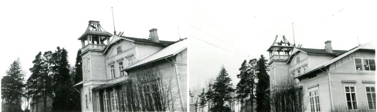
Kuva 61. Tornin huipun purkaminen vuonna 1959. Oikeanpuoleisessa kuvassa näkyy myös toisen kerroksen päätyyn 1950-luvulla avattu suuri ikkuna. SCA
