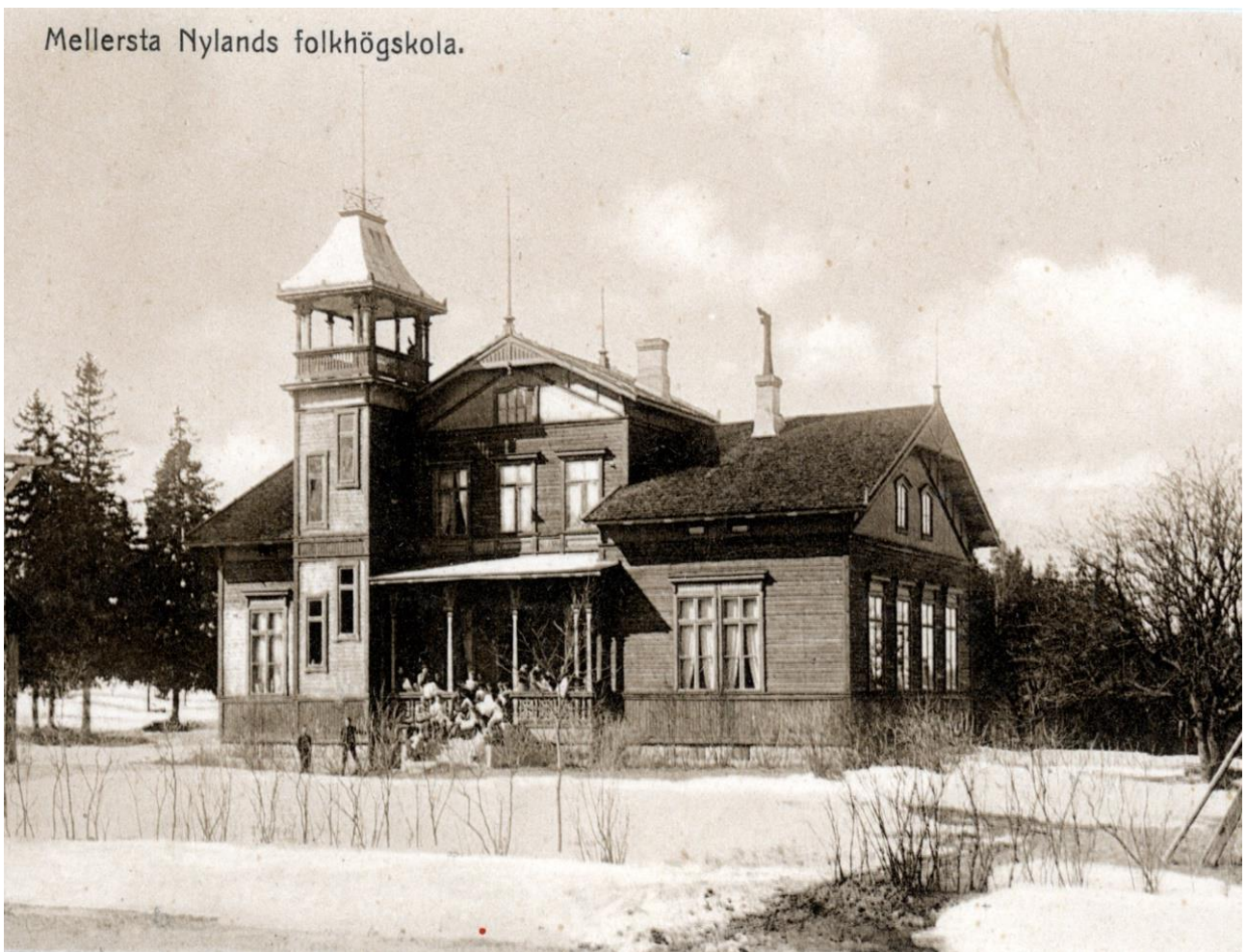
Kuva 46. Koulurakennus vuonna 1910. Lauta-aita on vaihtunut pensasaidaksi ja julkisivut on laudoitettu. Postikortti, Espoon kaupunginmuseo.
