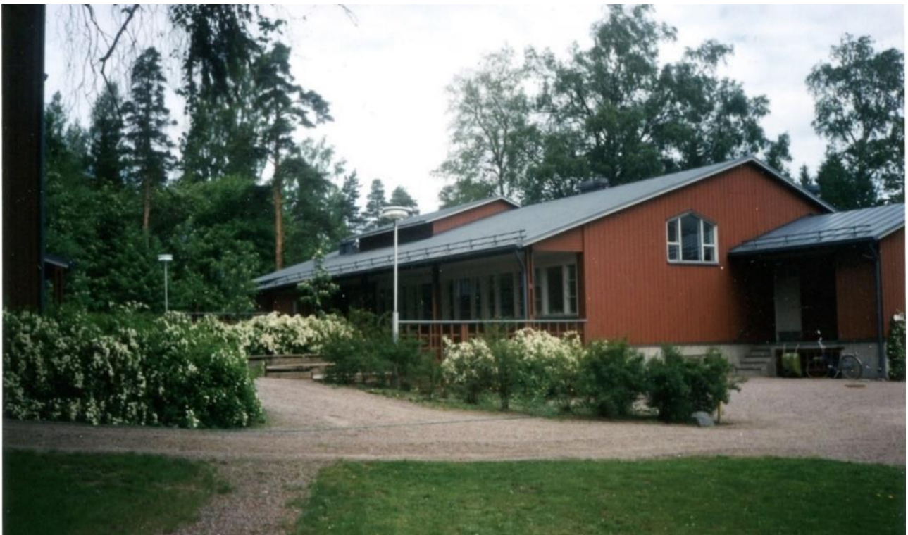
Kuva 90. Vastavalmistunut ruokala ja sen pääjulkisivu kohti asuntolaa sekä pihamaata. SCA
