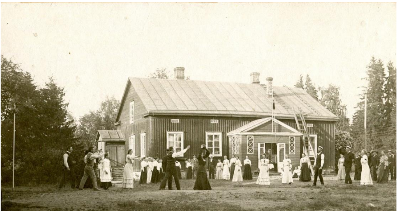
Kuva 25. Ensimmäisenä opistorakennuksena toiminut vanha kestikievarirakennus vuonna 1905. SCA
