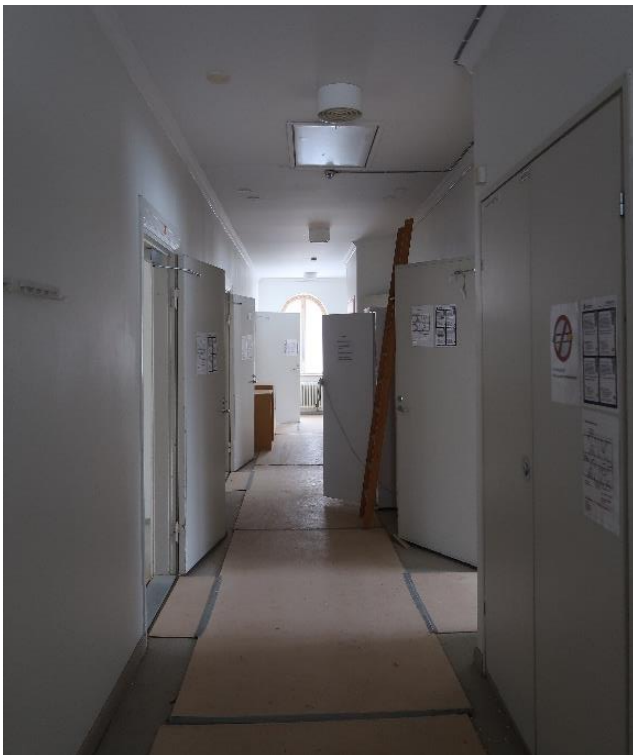
Kuva 78. Asuntolan toisen kerroksen käytävän ovet ovat vanhoja peiliovia, joiden pinnat on levytetty siten, että ovet näyttävät laakaovilta. Kaarevat ikkunat ovat alkuperäiset, mutta ikkunoiden pielet on uusittu vastikään vesikaton korjauksen yhteydessä.
