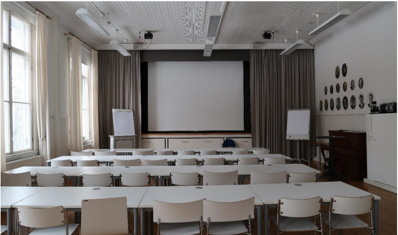
Kuva 65. Koulurakennuksen luentosali, jonka pätyyn on 1950-luvulla tehty näyttämö. Lattialauditus on 1960-luvulta, paneelikatto on todennäköisesti alkuperäinen.
