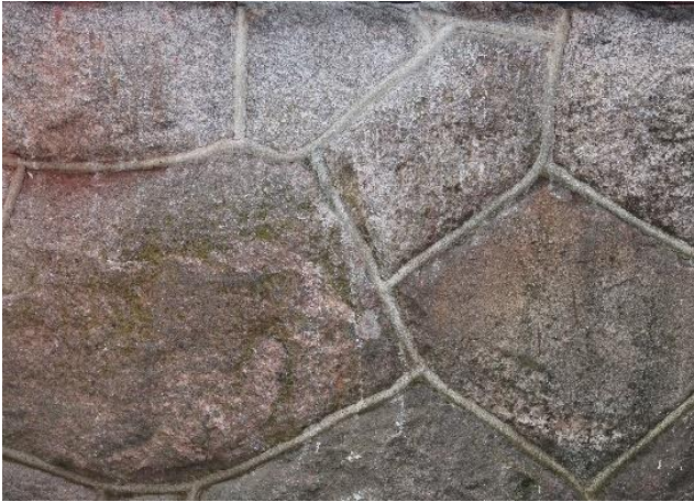
Kuva 75. Asuntolan kivijalan saumaus on tehty huolitellulla makkarasaumalla ja alkuperäisten ikkunoiden profiili on myös pyöristetty.
