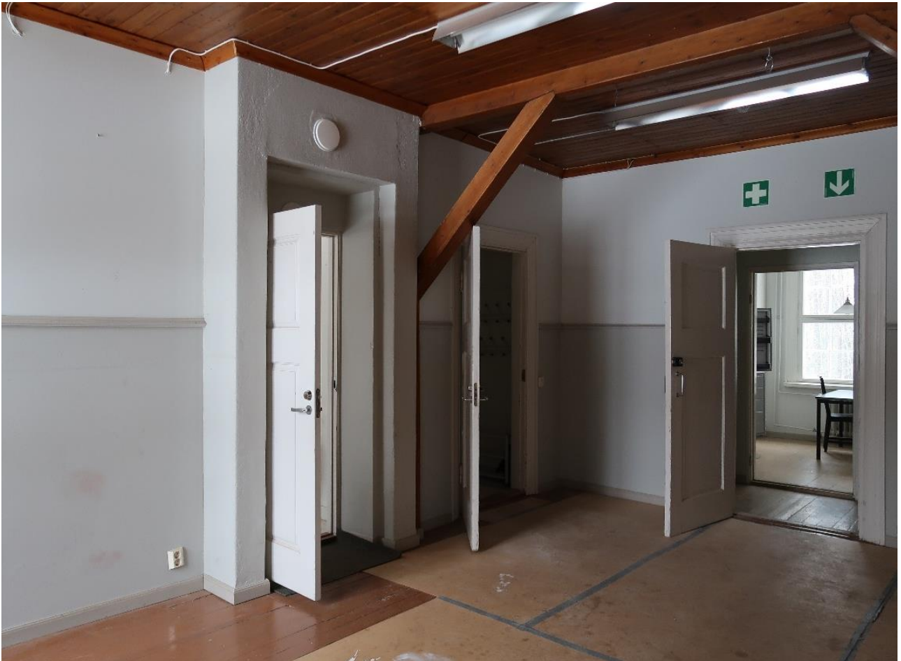
Kuva 76. Asuntolan aulassa on säilynyt lakattu paneelikatto näkyvine rakenteineen. Vanhan pönttöuunin paikalle on tehty oviaukko, johon on siirretty vanha ovilevy suljetusta oviaukosta. Lattia on kapeaa, maa-lattua lautta.
