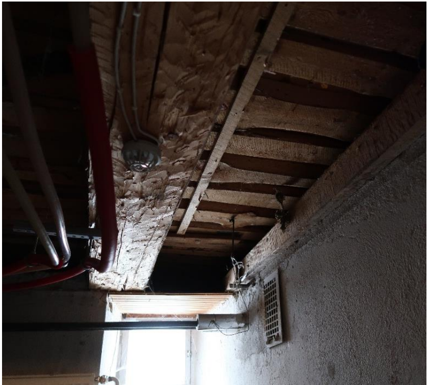
Kuva 70. Kellarissa ovet ovat 1950-luvulta ja yhdessä pienessä varastotilassa on vanha puualapohja näkyvissä, kun muualla kattopinnat on paneloitu ja lämmönjakuhuoneessa rapattu.
