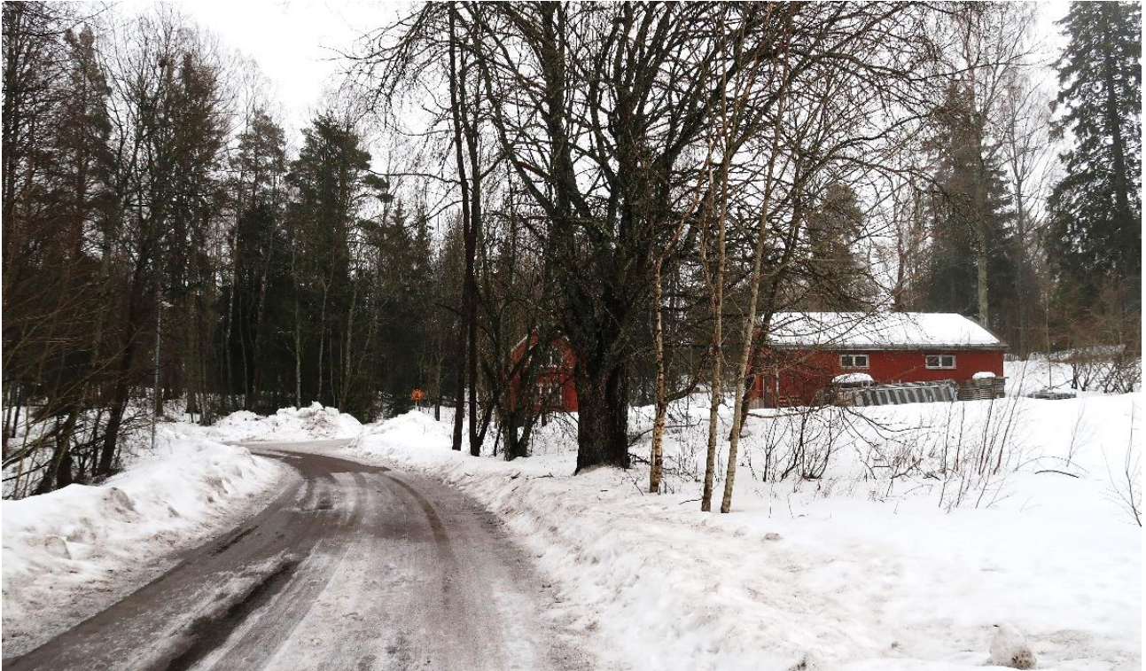
Kuva 109. Sauna ja huoltorakennus Vanhalta Vihdintieltä katsottuna.
