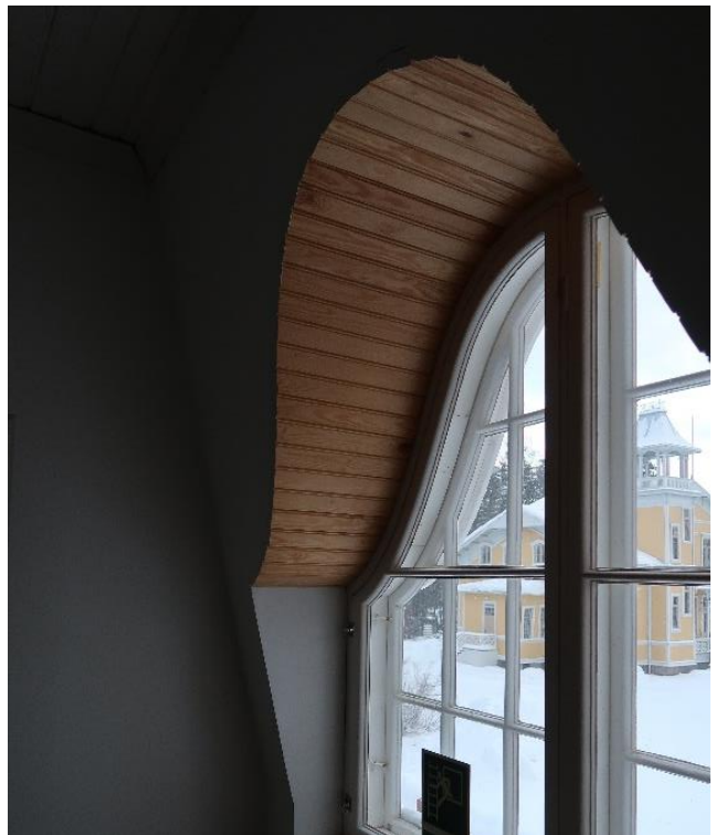
Kuva 78. Asuntolan toisen kerroksen käytävän ovet ovat vanhoja peiliovia, joiden pinnat on levytetty siten, että ovet näyttävät laakaovilta. Kaarevat ikkunat ovat alkuperäiset, mutta ikkunoiden pielet on uusittu vastikään vesikaton korjauksen yhteydessä.
