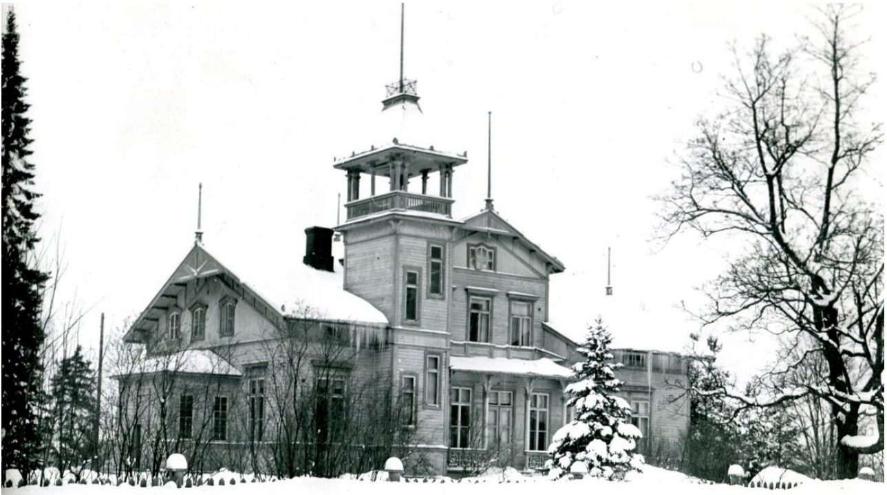
Kuva 59. Koulurakennus vuonna 1951 ennen julkisivujen maalausta. Päätyyn, toiseen kerrokseen on tehty uusi pieni ikkuna epäsymmetrisesti toiseen kerrokseen. SCA
