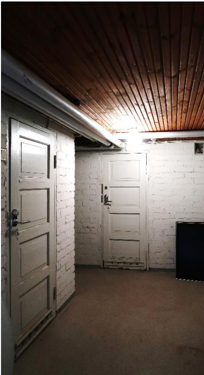
Kuva 70. Kellarissa ovet ovat 1950-luvulta ja yhdessä pienessä varastotilassa on vanha puualapohja näkyvissä, kun muualla kattopinnat on paneloitu ja lämmönjakuhuoneessa rapattu.
