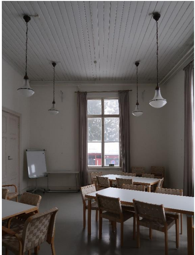
Kuva 67. Koulurakennuksen eteistilassa ja sen viereisessä alkuperäisessä kirjastossa on vanhat valaisimet. Eteistä on muutettu 1950- ja 1980-luvuilla. Väliovet ovat alkuperäisiä, samoin seinien alaosien puupaneeli niiltä osin kuin seinät ovat alkuperäisiä.
