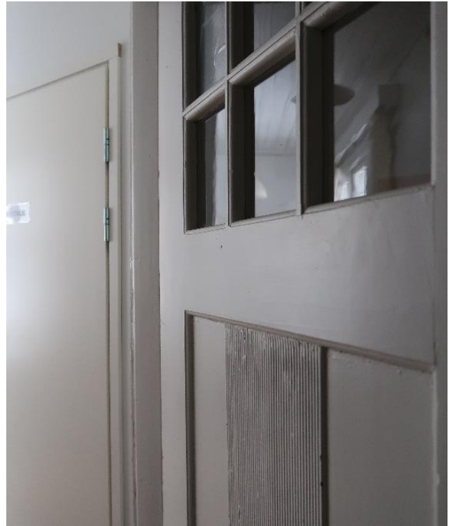
Kuva 79. Asuntolan väliovet ovat yksinkertaisia peiliovia, joissa on yleensä vain kaksi peiliä. Opettajan asunnon eteisen ovi on koristeellisempi pienine ruutuineen ja rihlattuine koristeineen peilin keskellä.
