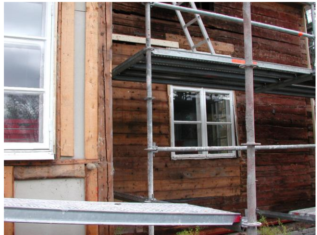
Kuva 38. Kestikievarin julkisivujen uusiminen vuonna 2003. Silloin havaittiin, että kuistin vieressä hirsiseinää oli jossain vaiheessa paikallisesti korjattu rankarakenteena. Paikkaus saattaa olla peräisin 1970-luvun tulipalon jälkeisistä korjaustöistä. Espoon kaupunginmuseum, kuvaaja Tryggve Gestrin.
