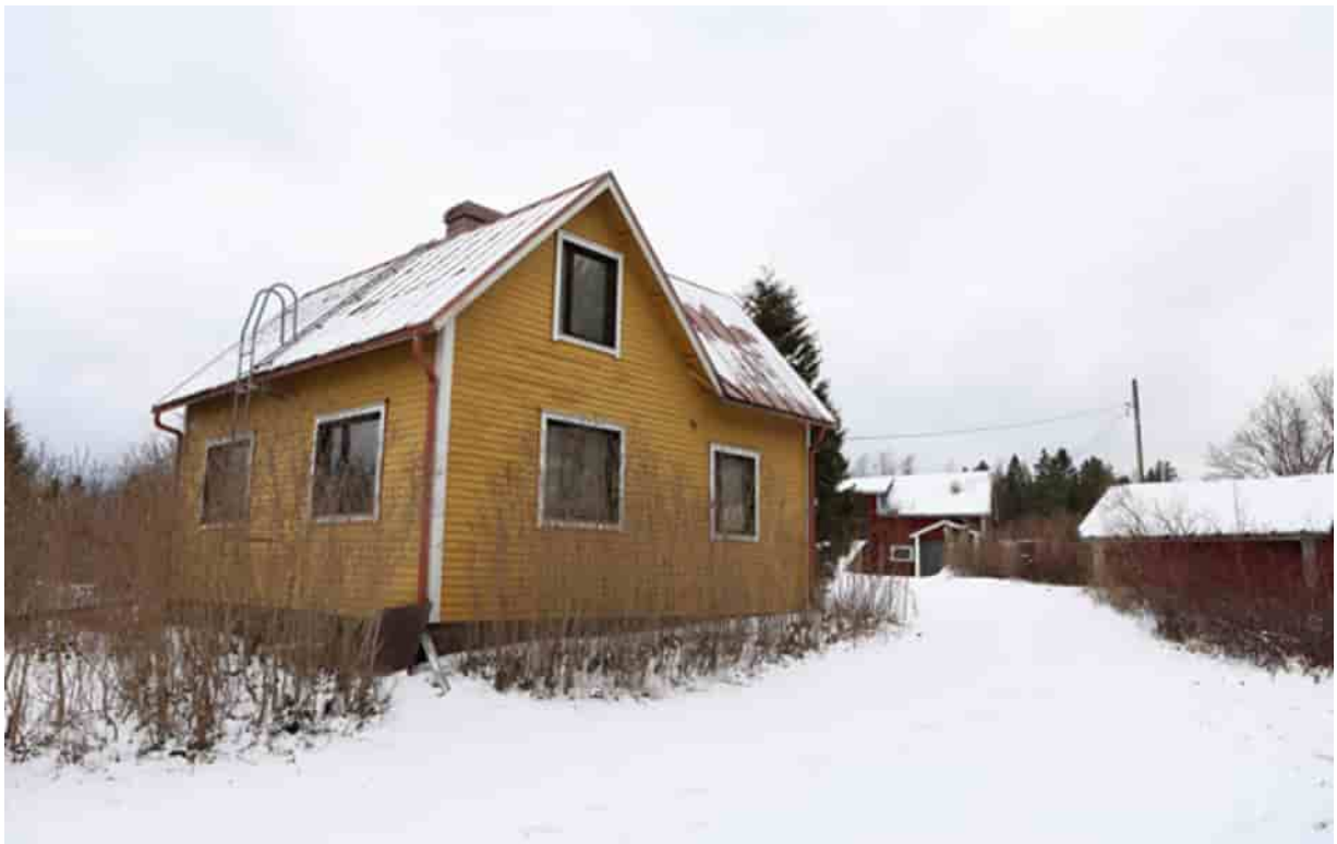
Kuva 67 Näkymä tilalle etelästä. Etualalla tilan päärakennus.
