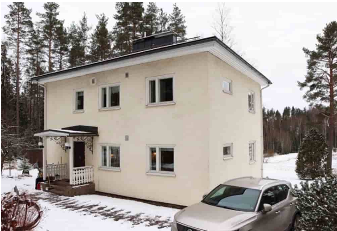
Kuva 52 Päärakennus kuvattuna pohjoisesta.
