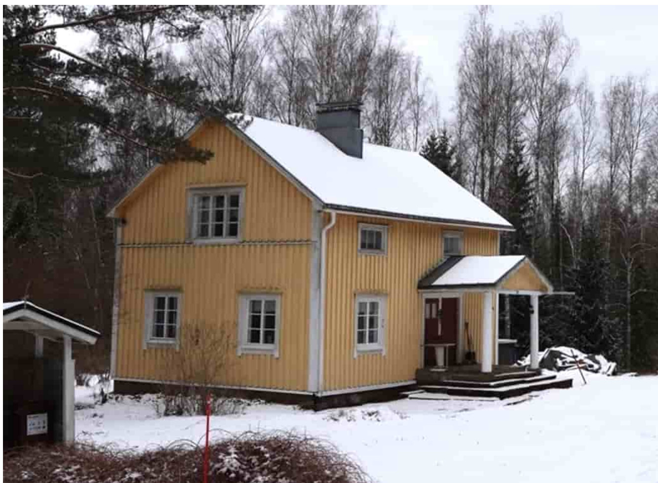
Kuva 47 Päärakennus kuvattuna idästä.
