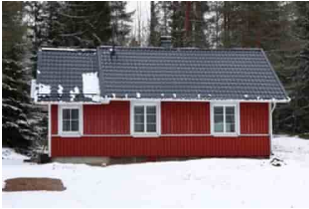
Kuva 55 Niipperintien varren vanhinta rakennuskantaa 1930-luvulta. Alkuperäiset ominaispiirteet eivät ole säilyneet.
