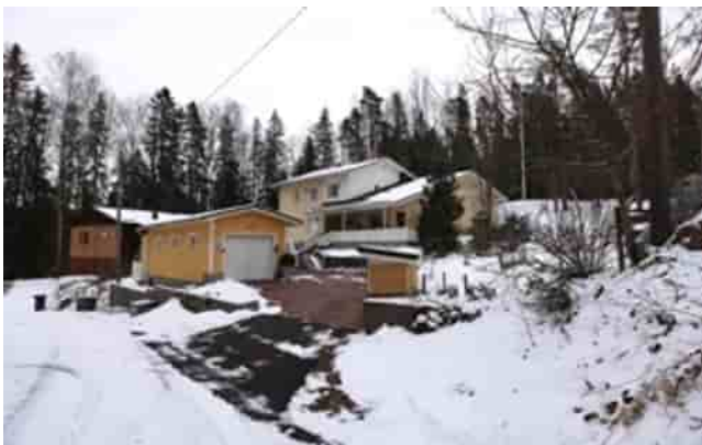
Kuva 42 Etualalla vuoden 1994 rakennus ja takana vuoden 1962 rakennus.
