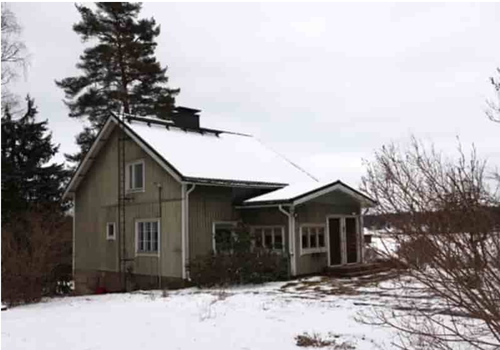
Kuva 25 Päärakennus kuvattuna pohjoisesta.
