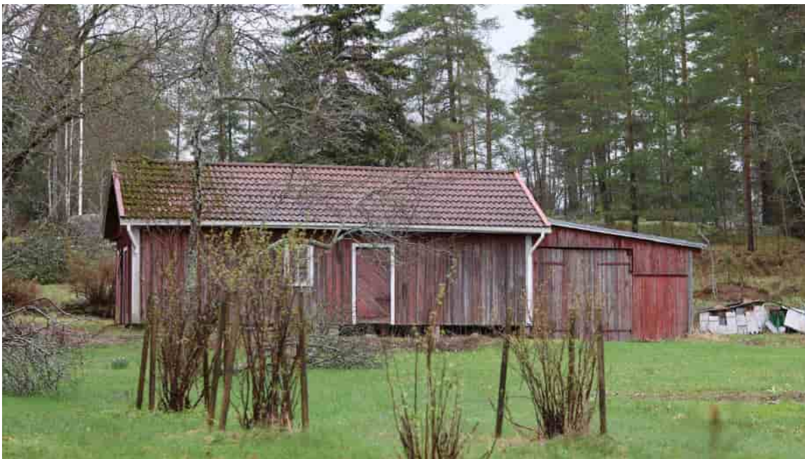
Kuva 34 Talousrakennus kuvattuna etelästä.
