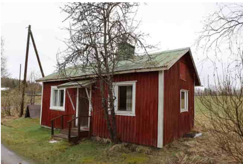
Kuva 70 Piharakennus kuvattuna koillisesta.
