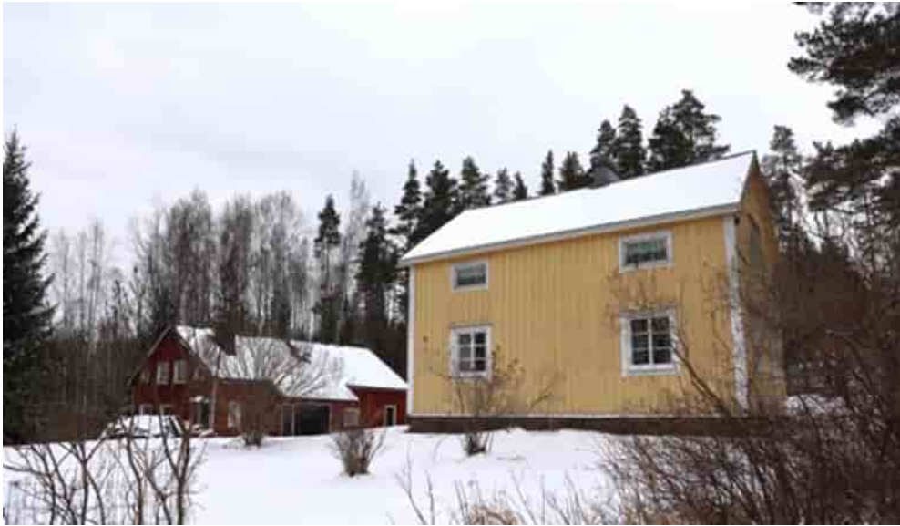
Kuva 48 Päärakennus kuvattuna etelästä.
