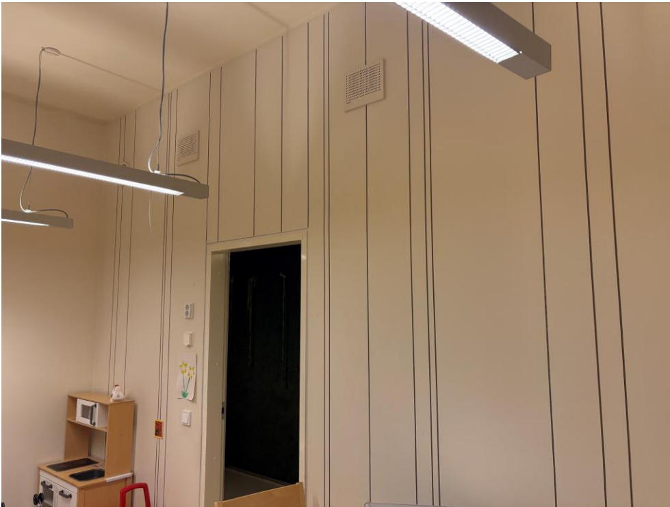
Kuva 4.6. Seinissä käytetystä ilmoitustaulu tyyppisestä seinämateriaalista irtoaa paikoin hajua. Kuva vanhempien tapaamishuone 242.
