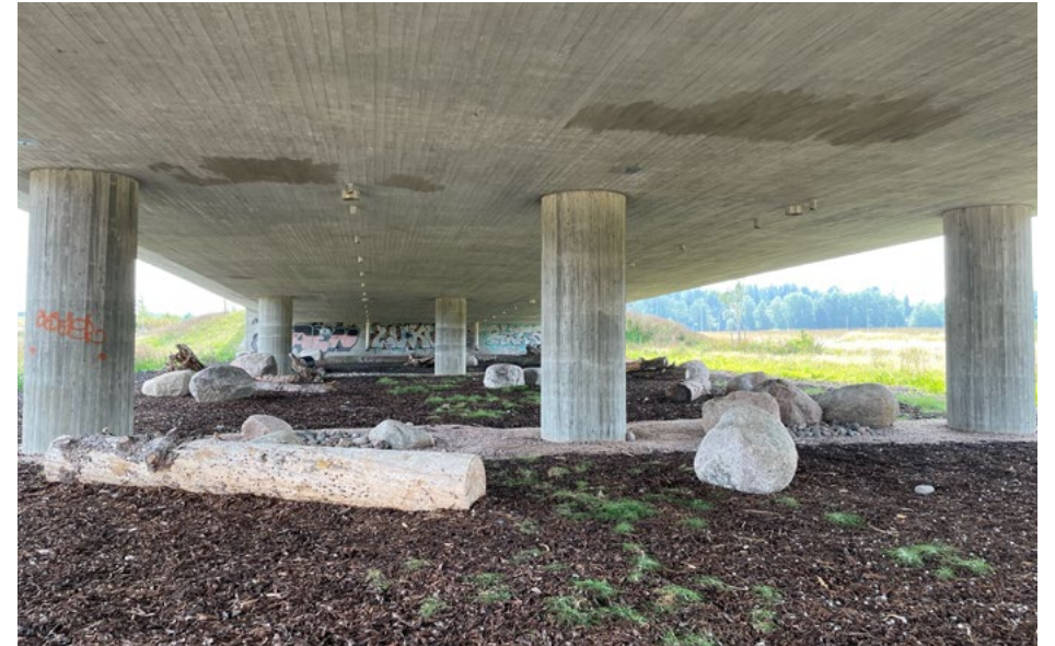
Keskuspuiston ja Storhemin välistä ekologista yhteyttä tukemaan on toteutettu Vassholmin silta, jonka ali eläimet pääsevät kulkemaan.
