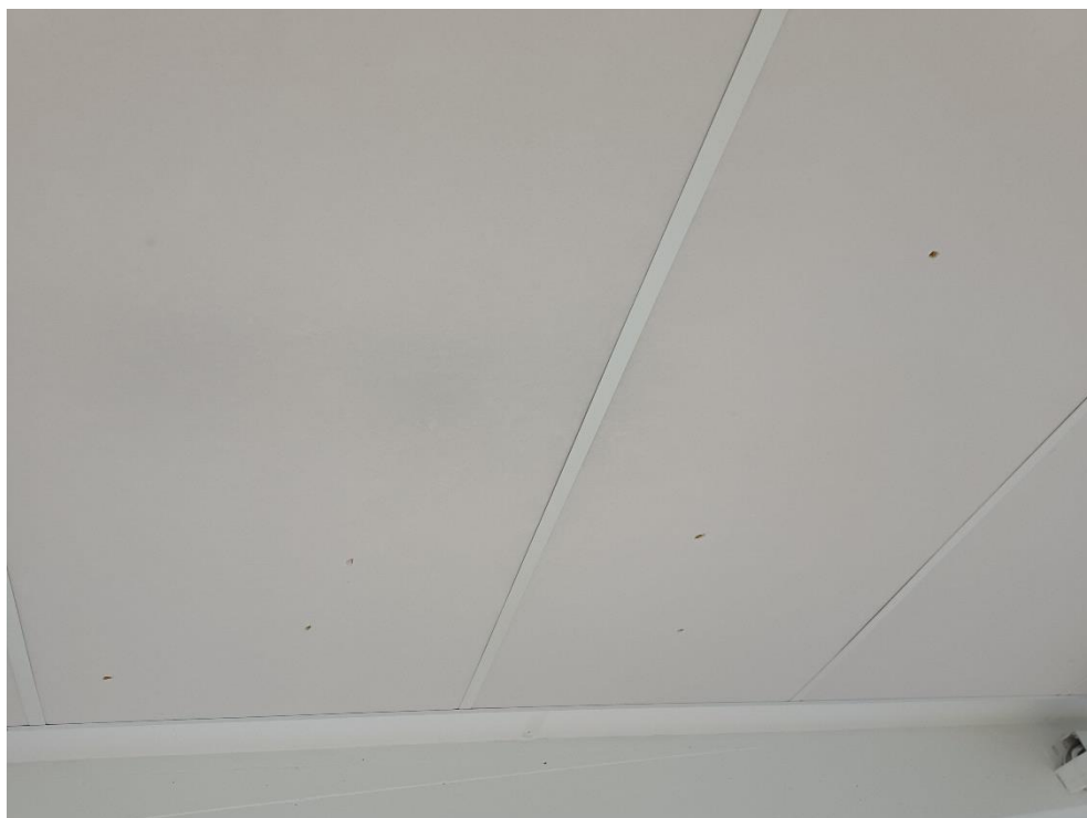
Kuva 4.10. 228 Luokka, kattoon asennetuissa akustointilevyissä on reikiä.
