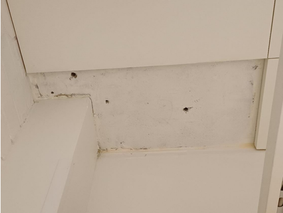
Kuva 4.1. 118 Luokka, akustointilevy on poistettu katosta.
