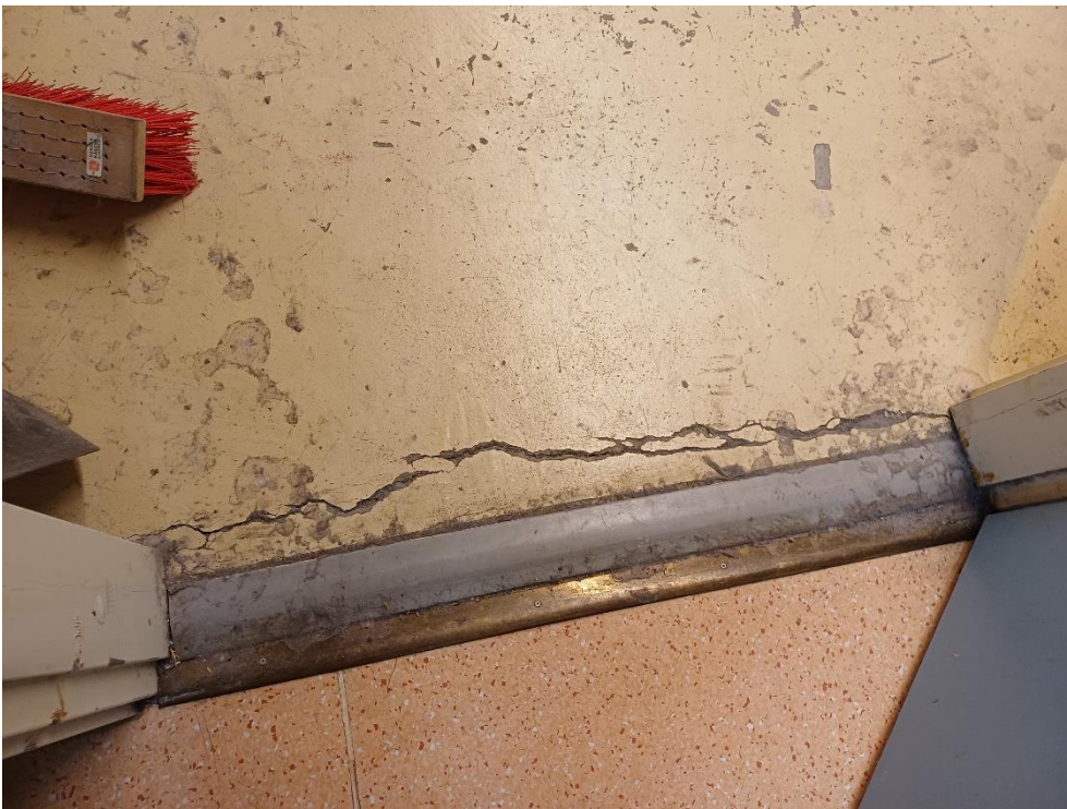
Kuva 4.4. 128 Lämmönjakohuone, lattiahalkeamia.
