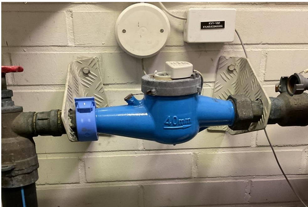
Kuva 6.2. Kylmävesimittari vuotaa.
