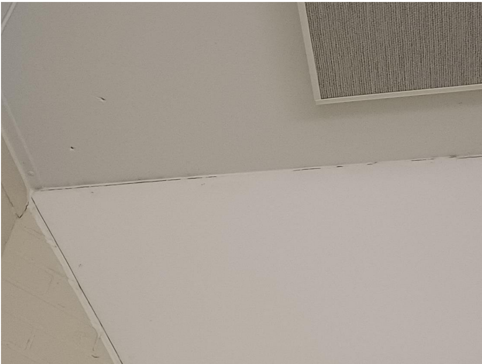
Kuva 4.1. 253 Rakenneliittymien ratkeamia.
